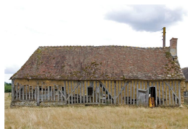
Élévation postérieure du logis. Phot. François Lasa IVR52_20087201379NUCA
