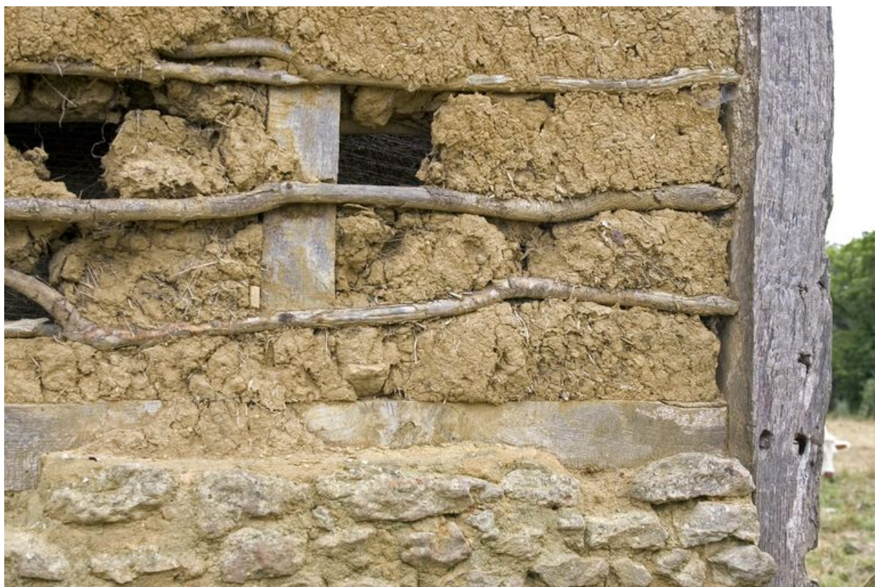
Mise en œuvre du hourdis de torchis sur le pignon nord de la grange.
