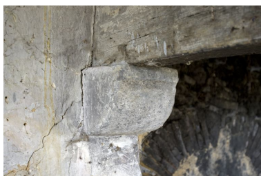
Détail de la cheminée du logis. Phot. François Lasa IVR52_20087201382NUCA
