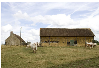
Élévation postérieure de la grange. Phot. François Lasa IVR52_20087201372NUCA
