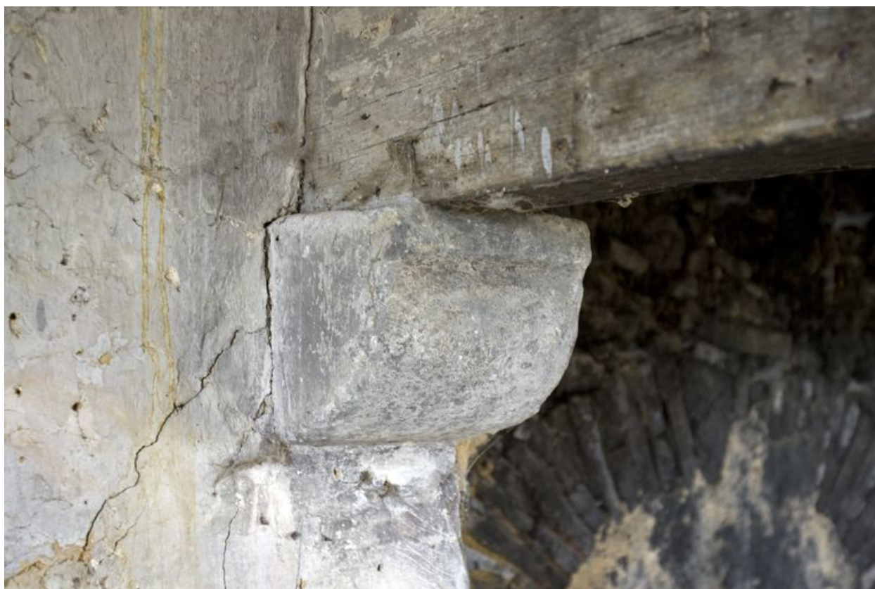
Détail de la cheminée du logis.
