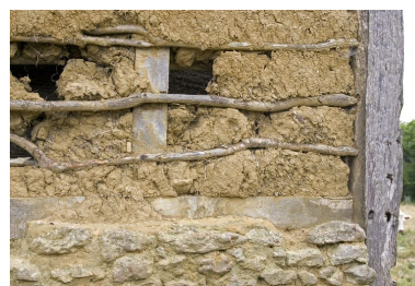
Mise en œuvre du hourdis de torchis sur le pignon nord de la grange. Phot. François Lasa IVR52_20087201373NUCA
