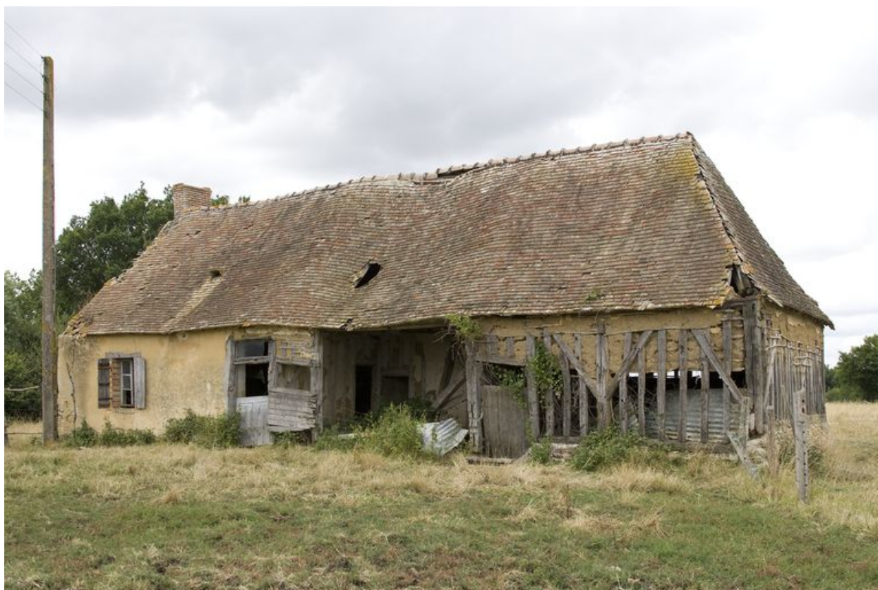
Élévation antérieure du logis.
