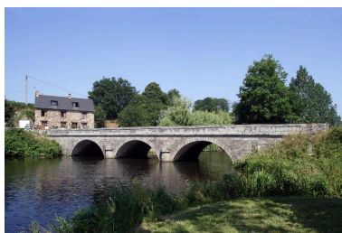
Le pont Landry vu depuis l'aval au sud. Phot. François Lasa IVR52_20055300379NUCA
