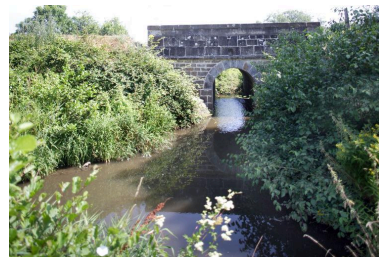
Le pont du ruisseau de Vienne. Phot. François Lasa IVR52_20055300380NUCA
