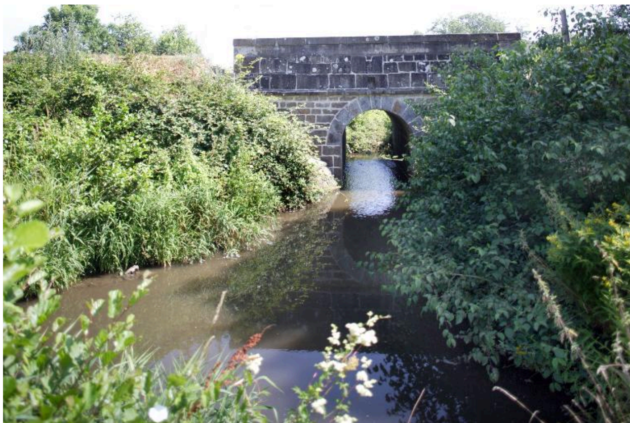
Le pont du ruisseau de Vienne.
