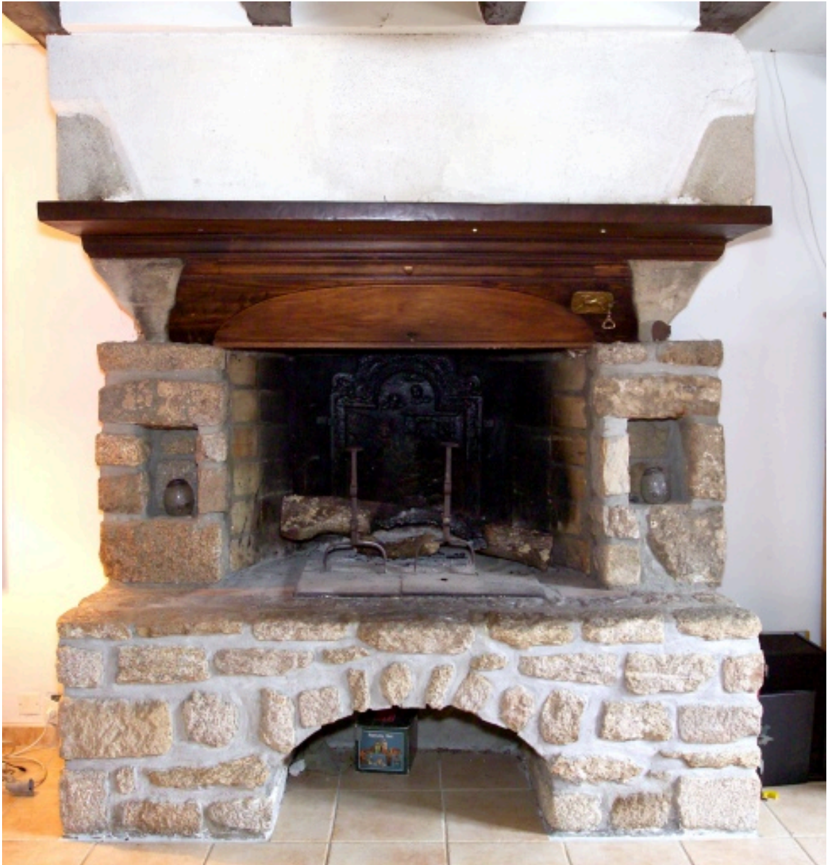
Cheminée au rez-de-chaussée.
