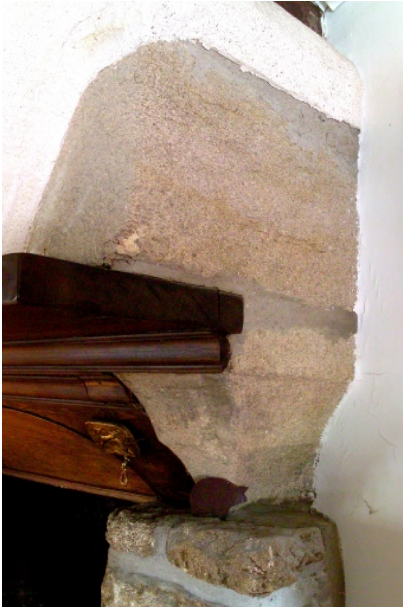
Cheminée au rez-de-chaussée, détail d'une console.
