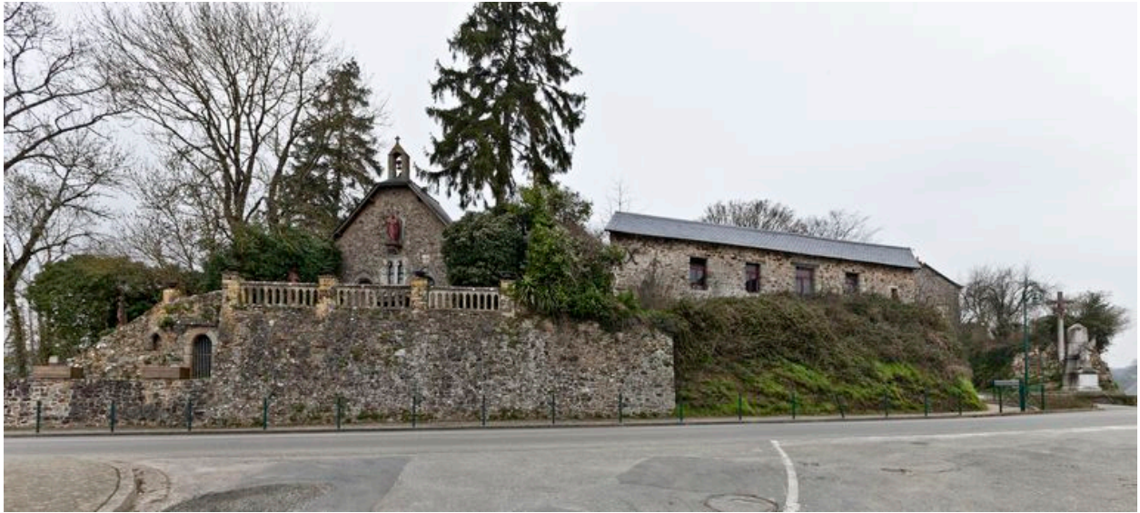
Vue générale de la chapelle commémorative Saint-Trèche et du monument aux morts de la commune.
