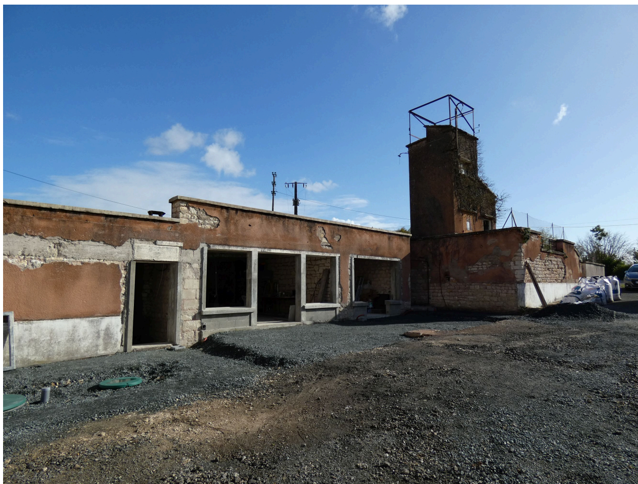
Anciens réservoirs et transformateur au nord-est de l'ensemble, vus depuis le sud-ouest.
