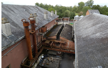
Vue depuis le second étage du bâtiment d'atomisation, en direction de l'ouest : les deux corps principaux de bâtiments, couverts en ardoise, encadrant le toit en terrasse du bâtiment des chambres froides, surmonté de bacs à eau.
