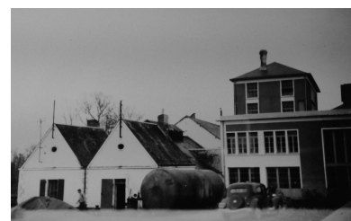
La laiterie vue depuis l'est en 1950, après construction de la tour d'atomisation, à droite, et
