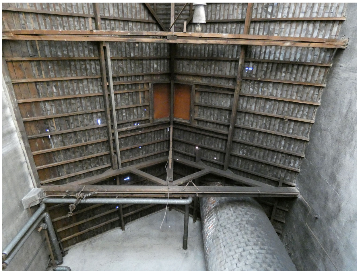
La charpente de la chaufferie.
