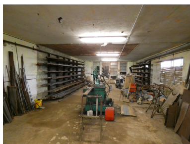
Au rez-de-chaussée du bâtiment des chambres froides, l'ancienne salle du compresseur et des chambres froides (emplacement à gauche), vue depuis l'est.
