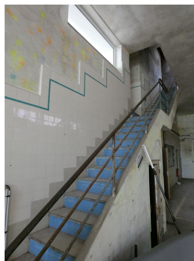
Escalier dans la salle de fabrication du beurre, montant aux bureaux situés au sud de la salle. Phot. Yannis Suire IVR52_20238500097NUCA
