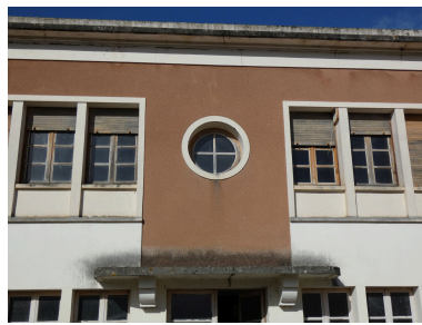
Détail de la façade est : enduit ocre, ouvertures claires, oeil-de-boeuf, corniche au-dessus de la porte. Phot. Yannis Suire IVR52_20238500086NUCA
