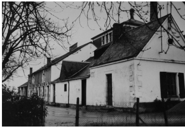
Les bâtiments sud de la laiterie, construits à la fin du 19e siècle, vus depuis le sud-est en 1950. Repro. Yannis Suire IVR52_20238500284NUCA
