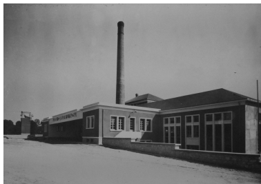
La laiterie vue depuis le nord-ouest, après sa reconstruction en 1950-1951. Repro. Yannis Suire IVR52_20238500290NUCA
