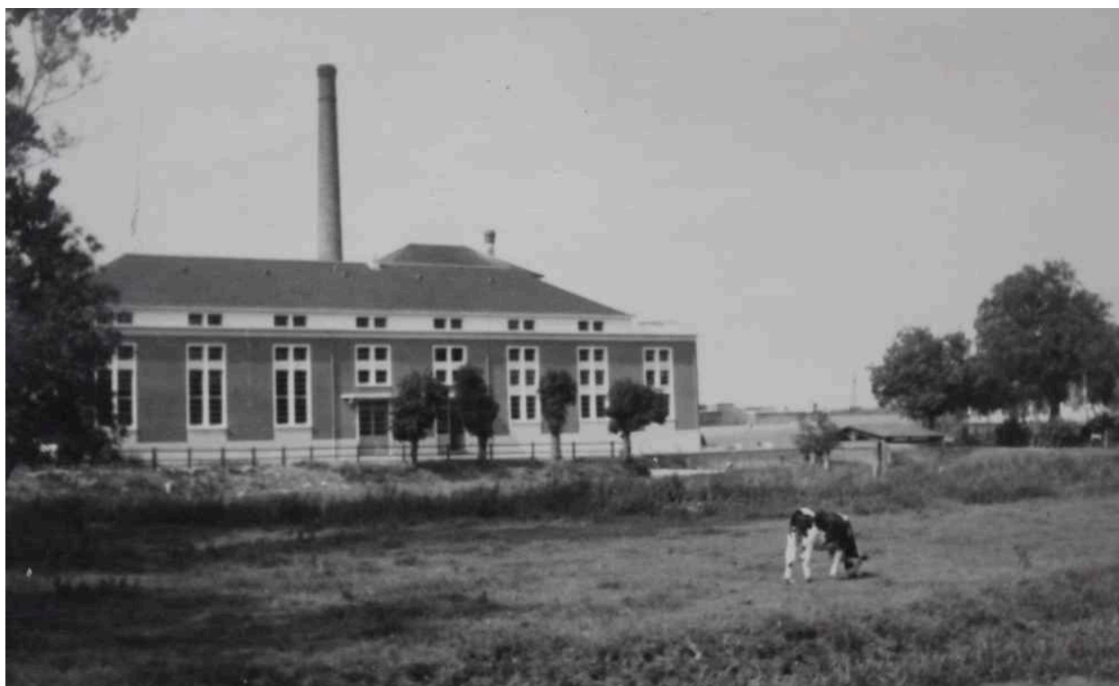
La laiterie vue depuis le sud vers 1960.
