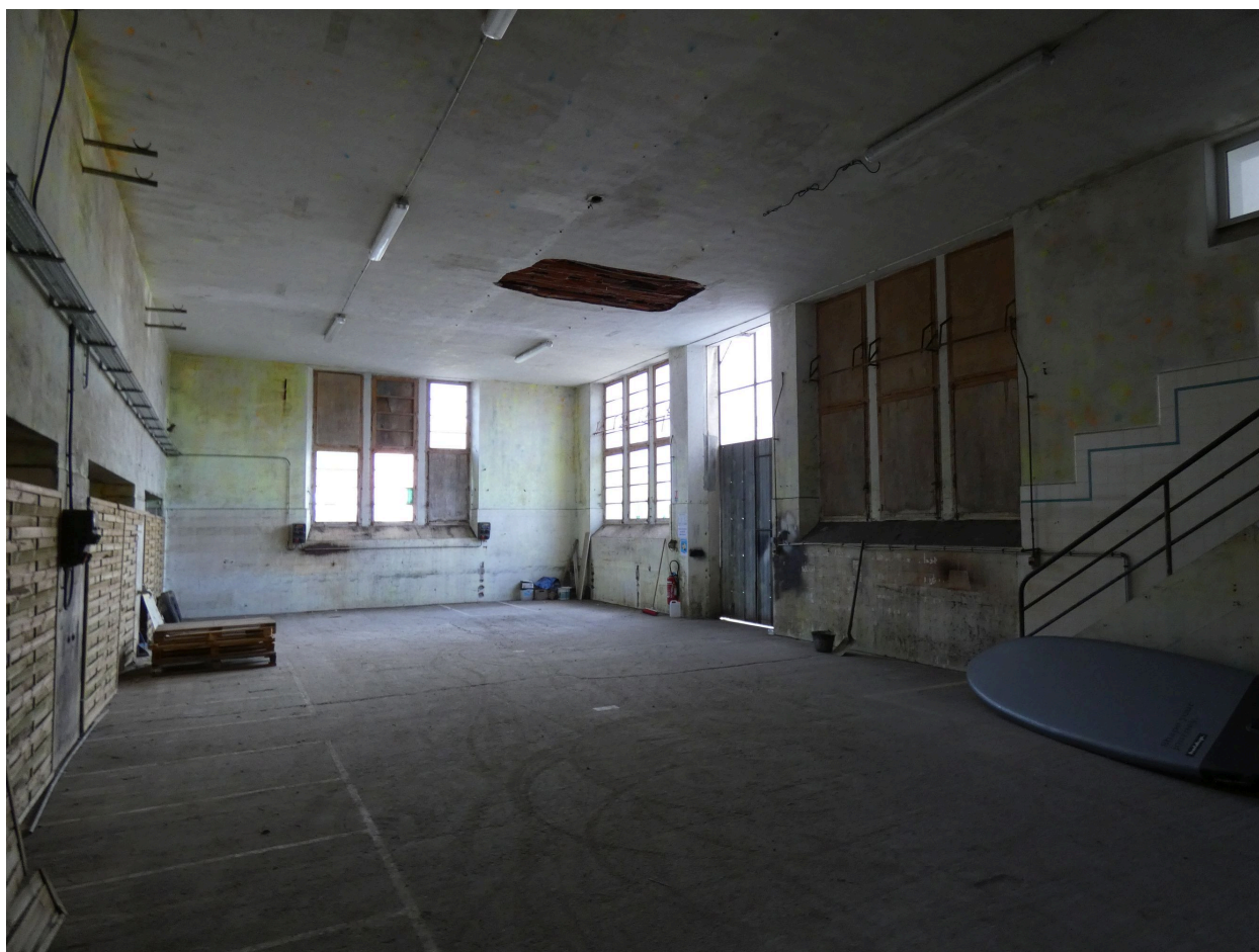
Salle de fabrication du beurre au rez-de-chaussée du corps principal de bâtiment nord, côté ouest, vu en direction de l'ouest.
