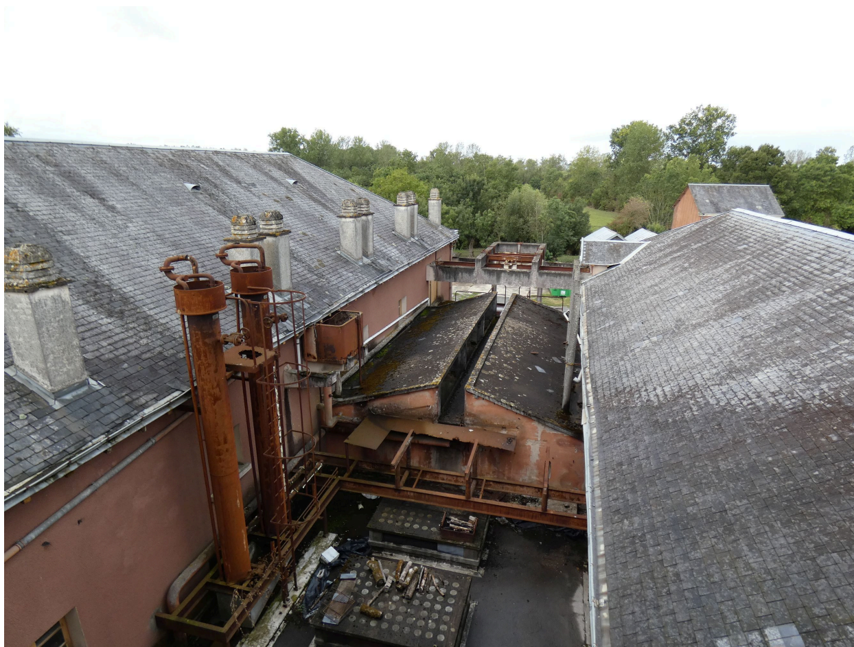
Vue depuis le second étage du bâtiment d'atomisation, en direction de l'ouest : les deux corps principaux de bâtiments, couverts en ardoise, encadrant le toit en terrasse du bâtiment des chambres froides, surmonté de bacs à eau.
