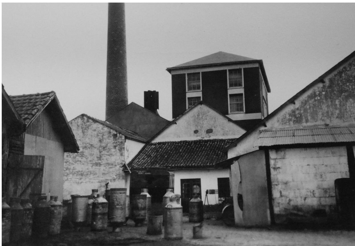
La laiterie vue depuis l'ouest en 1950, après construction de la tour d'atomisation et avant démolition des anciens bâtiments.
