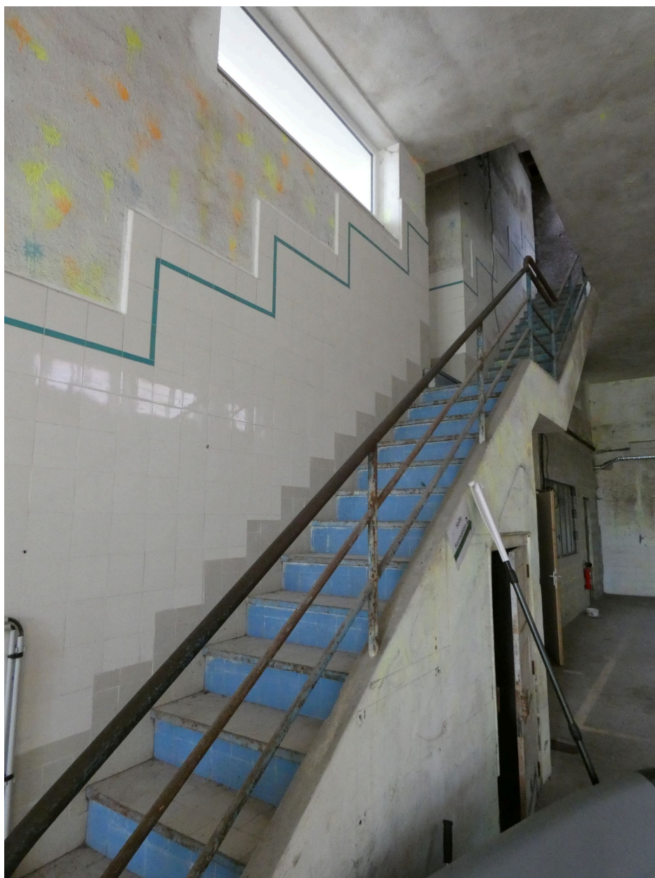
Escalier dans la salle de fabrication du beurre, montant aux bureaux situés au sud de la salle.
