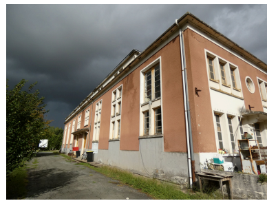
Le corps principal de bâtiment sud, vu depuis le sud-est : enduit ocre, travées d'ouvertures. Phot. Yannis Suire IVR52_20238500120NUCA
