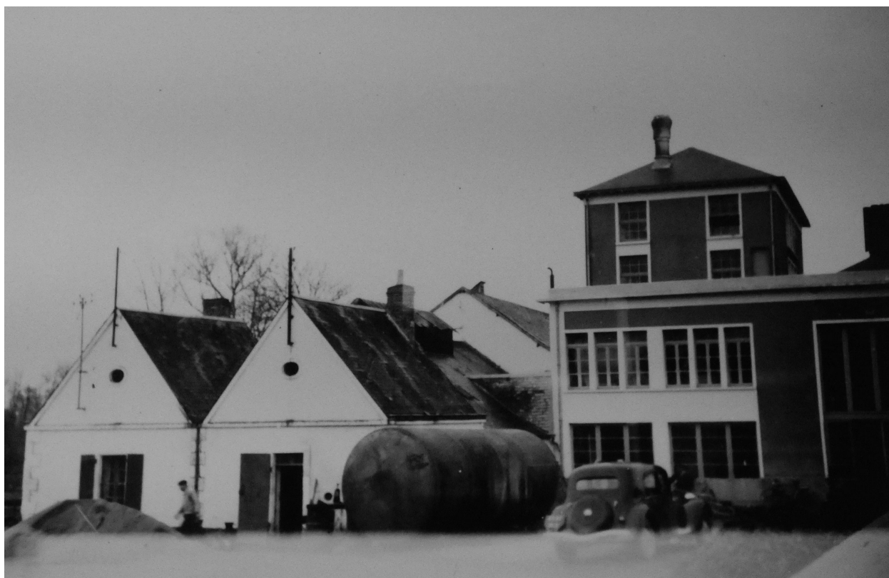
La laiterie vue depuis l'est en 1950, après construction de la tour d'atomisation, à droite, et avant démolition des anciens bâtiments sud, à gauche.
