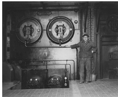
Chaudière et installation d'énergie à vapeur, dans la chaufferie, vers 1950. Repro. Yannis Suire IVR52_20238500310NUCA
