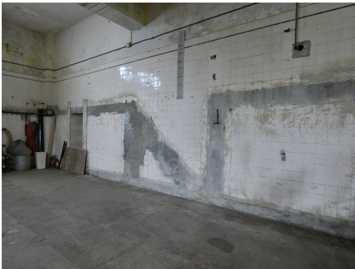
Traces d'emplacement des anciennes cuves dans la caséinerie.
