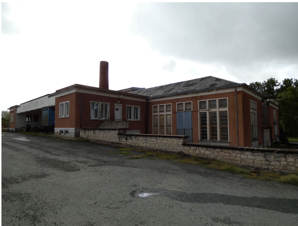
La laiterie vue depuis le nord-ouest. De gauche à droite : le quai de déchargement, le bâtiment de bureaux, le corps principal nord.
