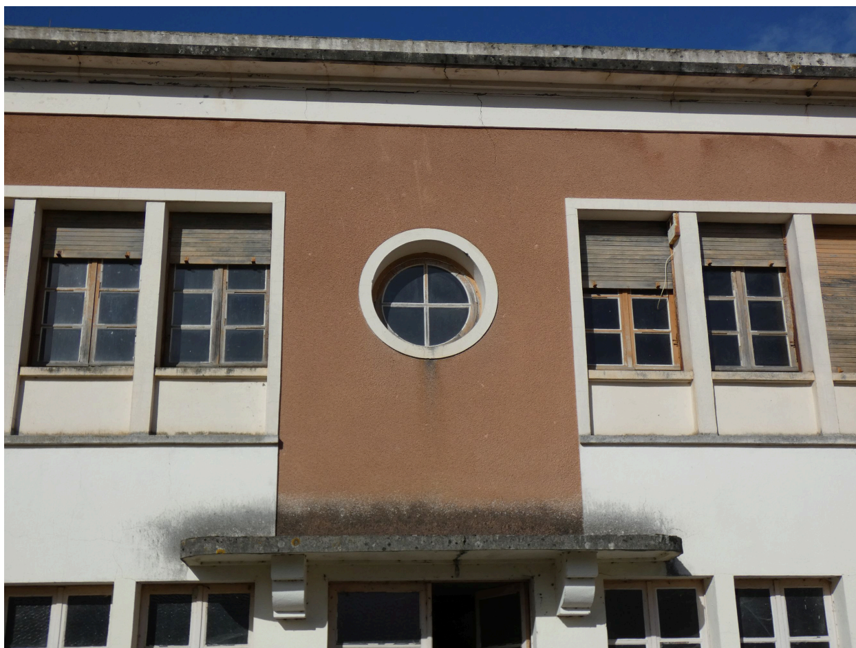
Détail de la façade est : enduit ocre, ouvertures claires, oeil-de-boeuf, corniche au-dessus de la porte.
