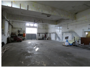
La caséinerie au rez-de-chaussée du corps principal de bâtiment sud, côté ouest, vue en direction de l'ouest.
