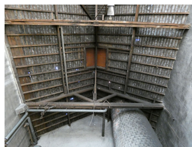
La charpente de la chaufferie. Phot. Yannis Suire IVR52_20238500089NUCA
