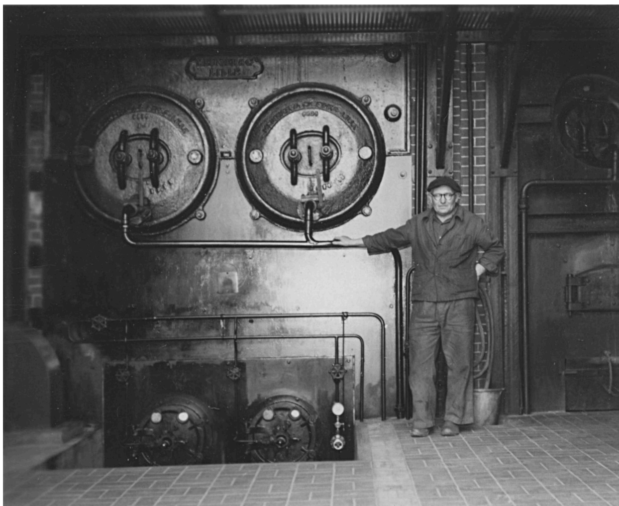
Chaudière et installation d'énergie à vapeur, dans la chaufferie, vers 1950.
