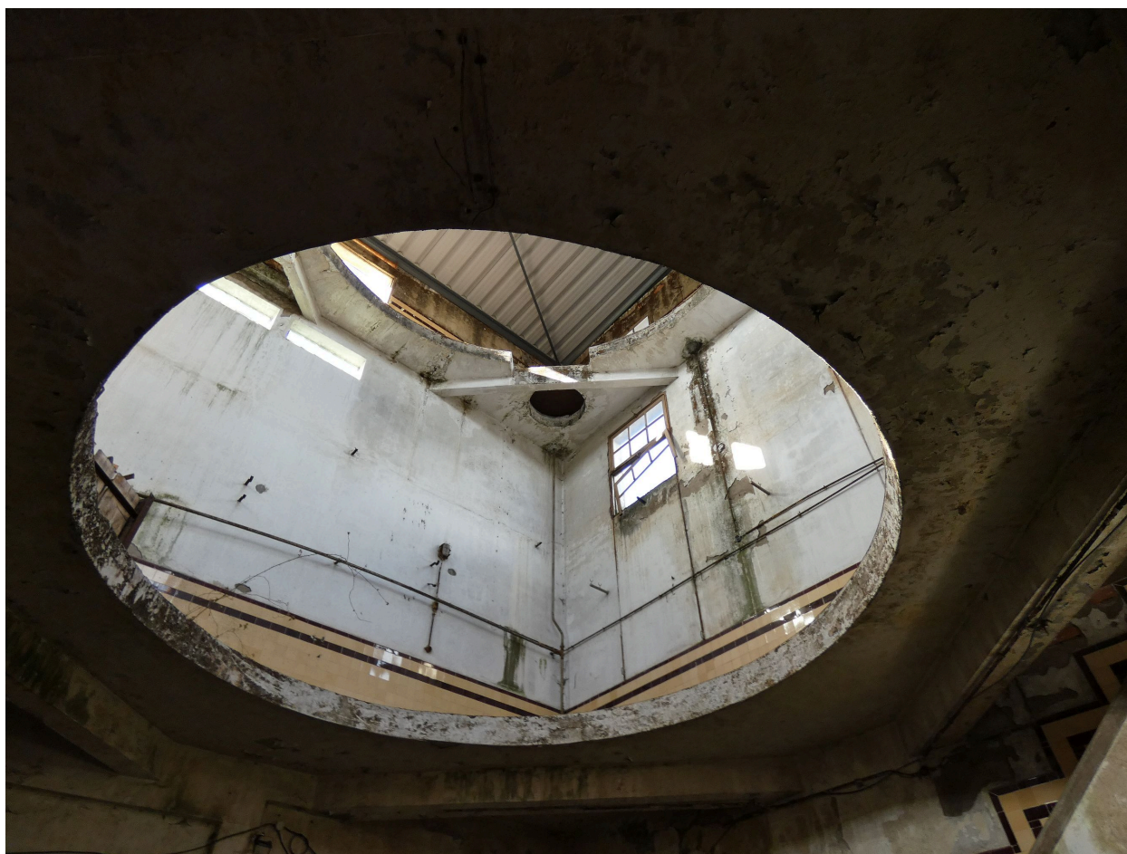
L'emplacement de la tour d'atomisation percé dans le plancher du premier étage du bâtiment.
