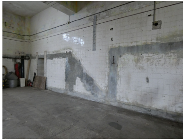
Traces d'emplacement des anciennes cuves dans la caséinerie.
