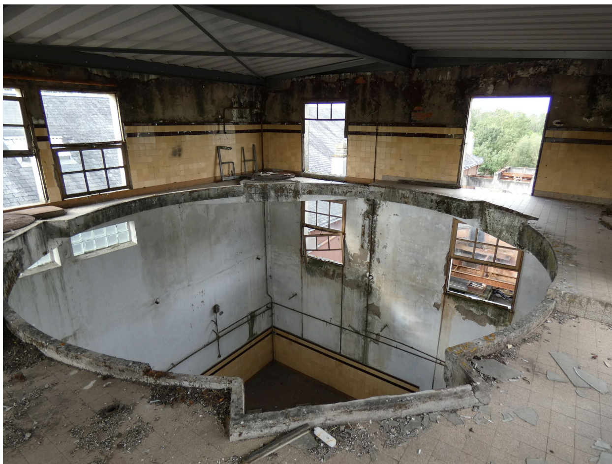
Emplacement de la tour d'atomisation percé dans le plancher du dernier étage du bâtiment.
