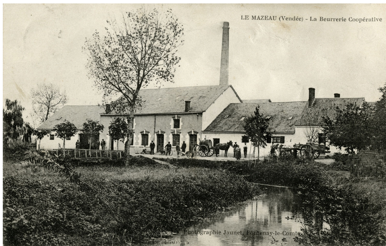
La laiterie vue depuis le sud vers 1900.
