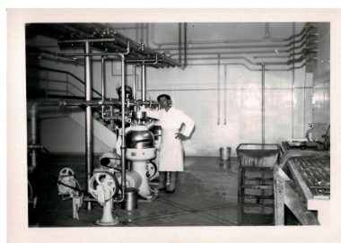
Une chambre à crème, avec moteur à courroie, vers 1955. Repro. Yannis Suire IVR52_20238500316NUCA
