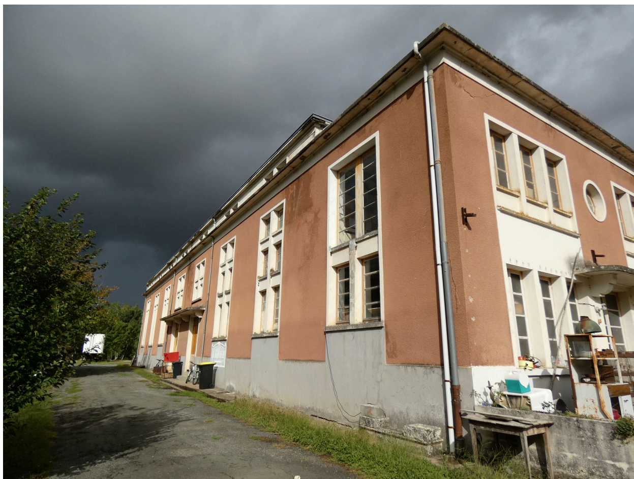
Le corps principal de bâtiment sud, vu depuis le sud-est : enduit ocre, travées d'ouvertures.
