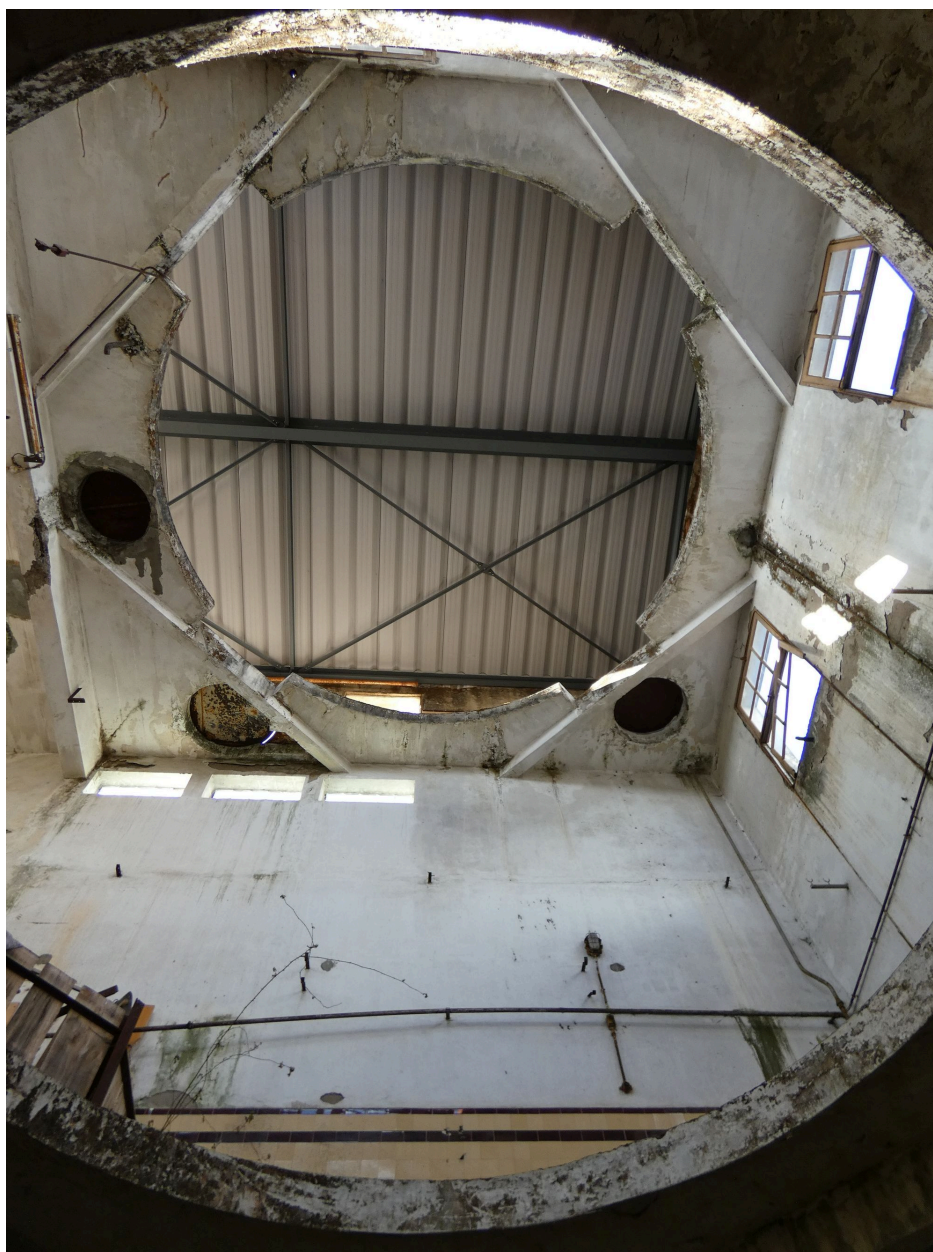
L'emplacement de la tour d'atomisation percé dans les planchers des différents niveaux du bâtiment.
