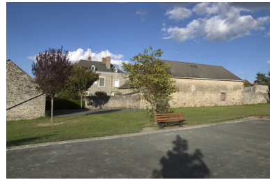
Vue depuis l'arrière. Phot. François Lasa IVR52_20045303093NUCA
