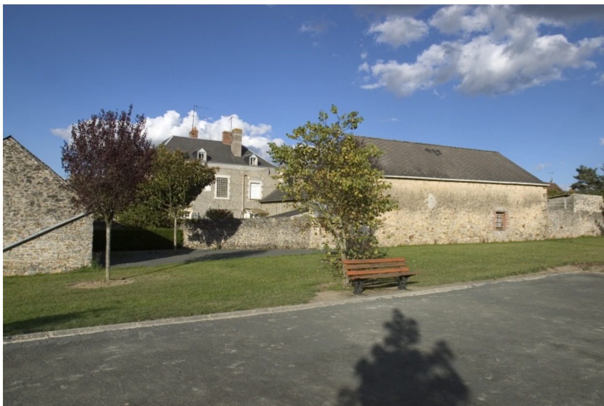
Vue depuis l'arrière.
