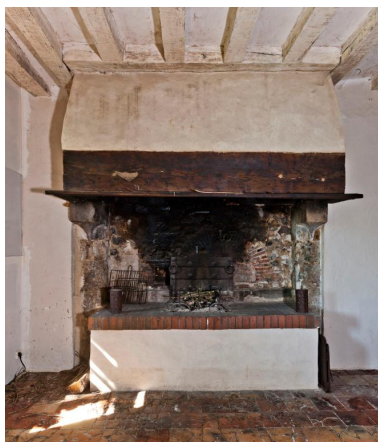
Cheminée du logis de La Cocardière. Phot. Yves Guillotin IVR52_20147201660NUCA
