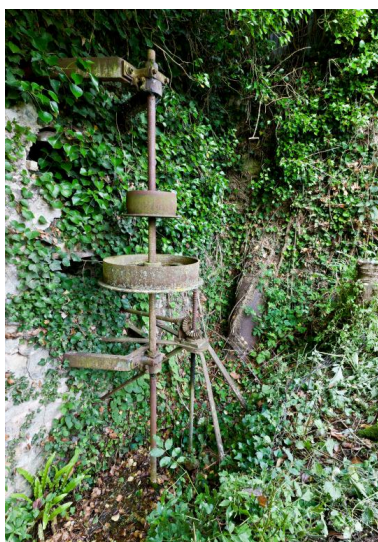
Le Moulin Neuf. Turbine hydraulique verticale au pignon droit du moulin. Phot. Yves Guillotin IVR52_20137200556NUCA
