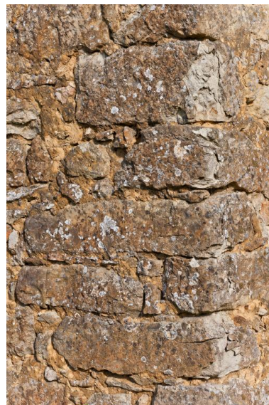
La Borde. Détail de l'une des chaînes d'angle en grès de la grange. Phot. Yves Guillotin IVR52_20137200454NUCA
