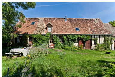
Ferme de La Cocardière, élévation antérieure du logis en pan-de-bois. Phot. Yves Guillotin IVR52_20147201659NUCA
