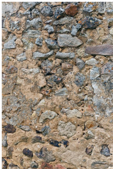
Détail d'une maçonnerie de moellons de silex enduits. Phot. Yves Guillotin IVR52_20137200441NUCA
