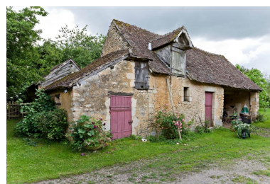
Le Carrefour. Logis simple désaffecté et remise sous même faîte. Phot. Yves Guillotin IVR52_20137200546NUCA
