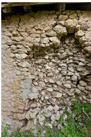
Le Carrefour. Porcheries. Maçonnerie de moellons calcaire liés à la terre et enduits. Phot. Yves Guillotin IVR52_20137200550NUCA
