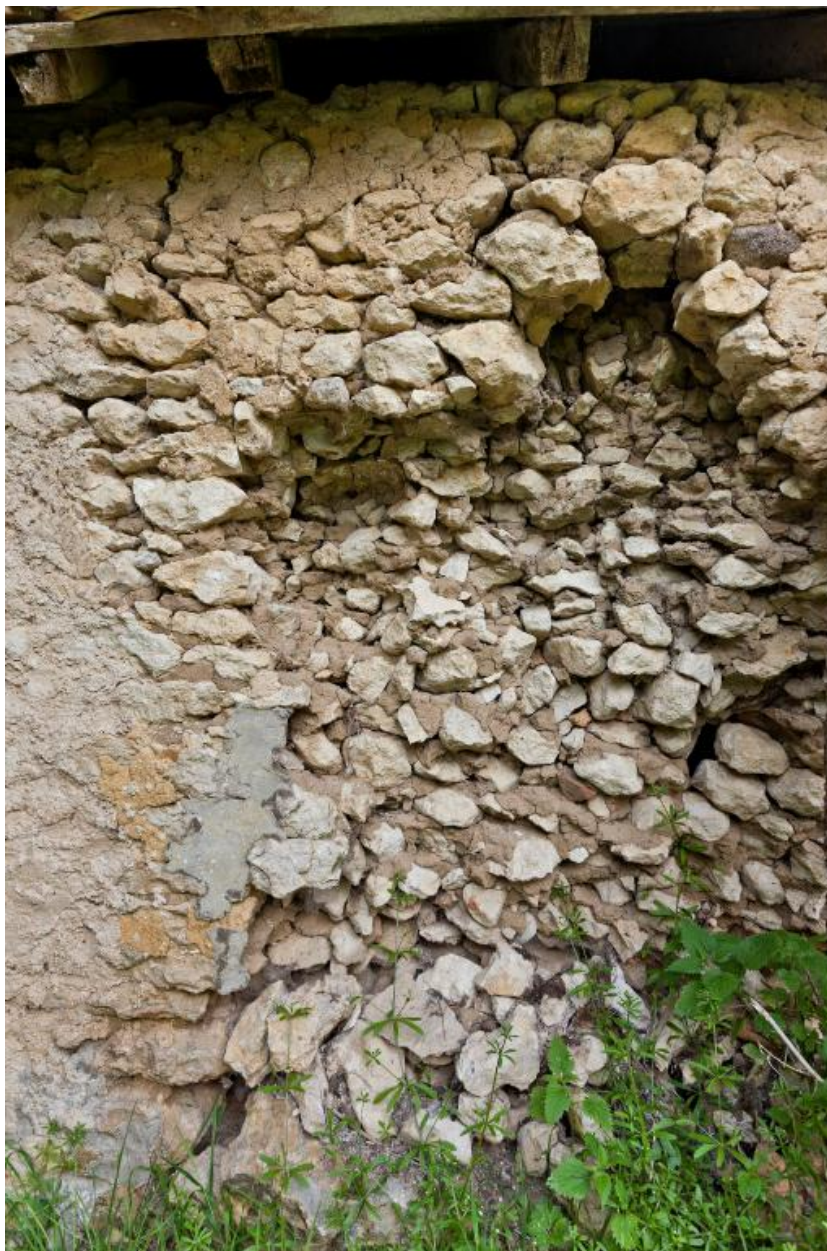
Le Carrefour. Porcheries. Maçonnerie de moellons calcaire liés à la terre et enduits.
