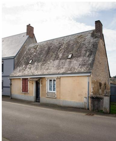
Maison, 7 rue de Cassière : édifice antérieur à 1834, probablement construit en pan-de-bois enduit, sauf le mur-pignon à cheminée et son important retour sur le gouttereau, construits en maçonnerie de moellons enduit.
