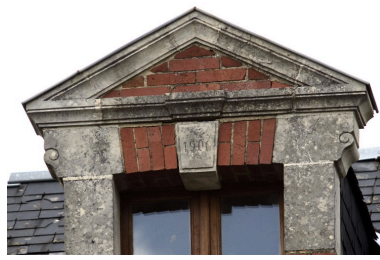
Lucarne du corps central, détail. Phot. François Lasa IVR52_20077200785NUCA
