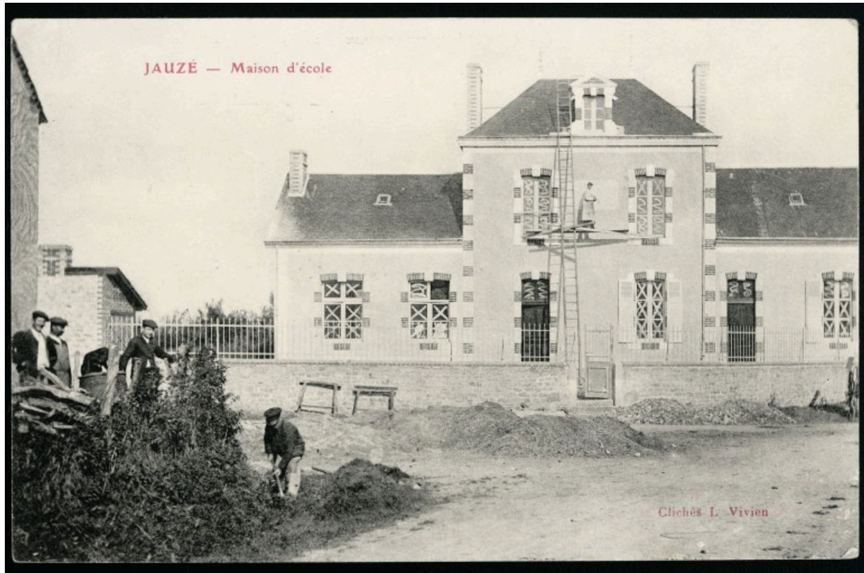
La mairie-école en construction en 1906.
