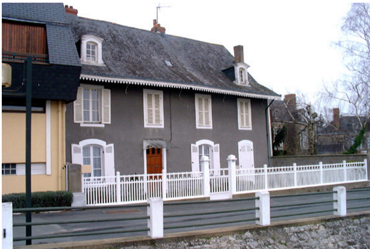
Ancien bâtiment d'exploitation (?), actuellement maison.
