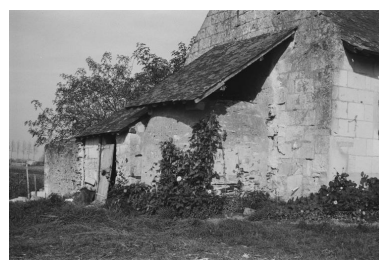
Vue du mur pignon de la maison portant la trace en négatif d'un ancien bâtiment. Repro. Bruno Rousseau, Repro. Dominique Letellier IVR52_19764900066Z
