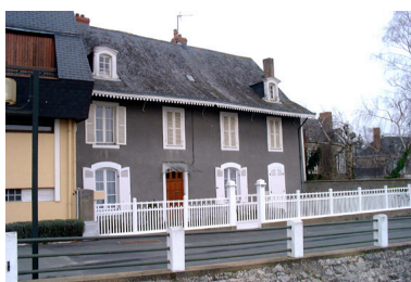
Ancien bâtiment d'exploitation (?), actuellement maison. Phot. Ronan Durandière IVR52_20064903541NUCA
