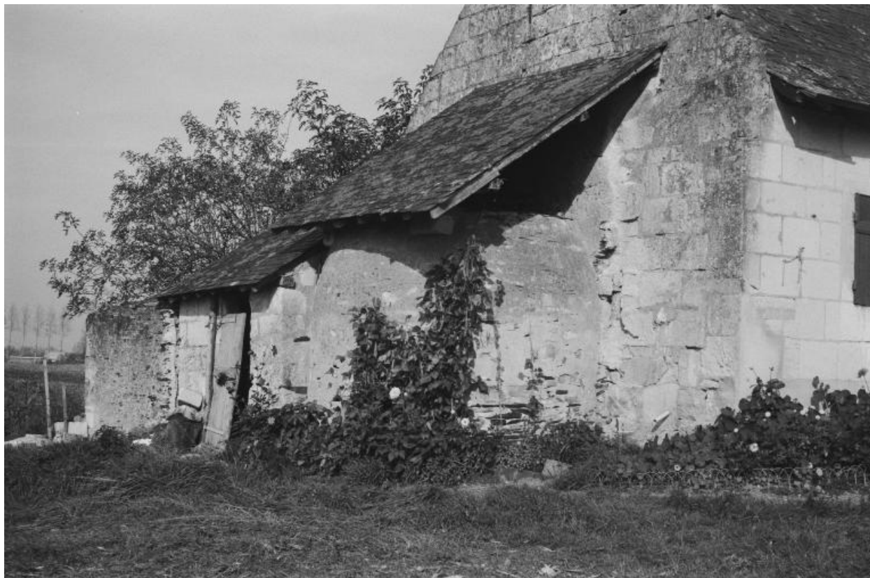
Vue du mur pignon de la maison portant la trace en négatif d'un ancien bâtiment.
