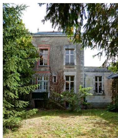
Façade postérieure sur le jardin. Phot. Yves Guillotin IVR52_20117200825NUCA
