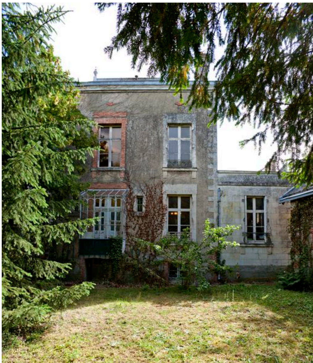
Façade postérieure sur le jardin.
