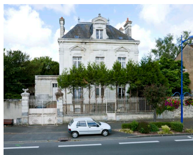
Vue d'ensemble prise du boulevard Fisson. Phot. Yves Guillotin IVR52_20117200829NUCA
