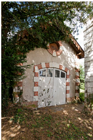
Communs : le pignon est ouvert sur la cour antérieure pour servir de remise, puis garage.
