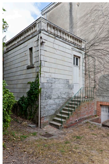
Aile basse, détail : façade sur la cour antérieure. Phot. Yves Guillotin IVR52_20117200828NUCA
