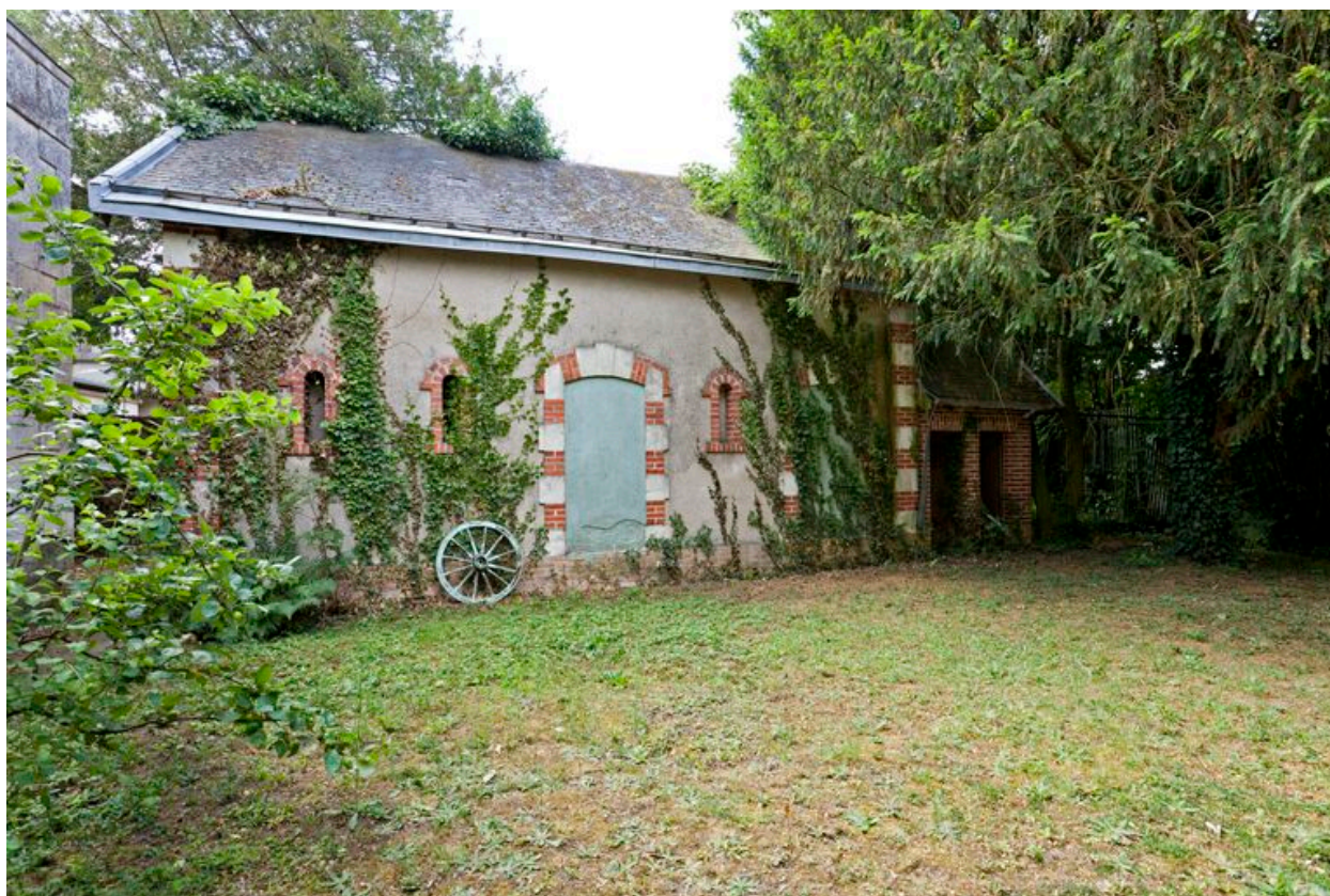
Communs en retour d'équerre dans le jardin : façade sur le jardin.
