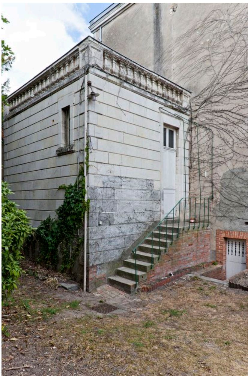
Aile basse, détail : façade sur la cour antérieure.
