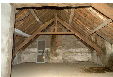
Vue de la charpente. Phot. Denis Pillet IVR52_20074400273NUCA
