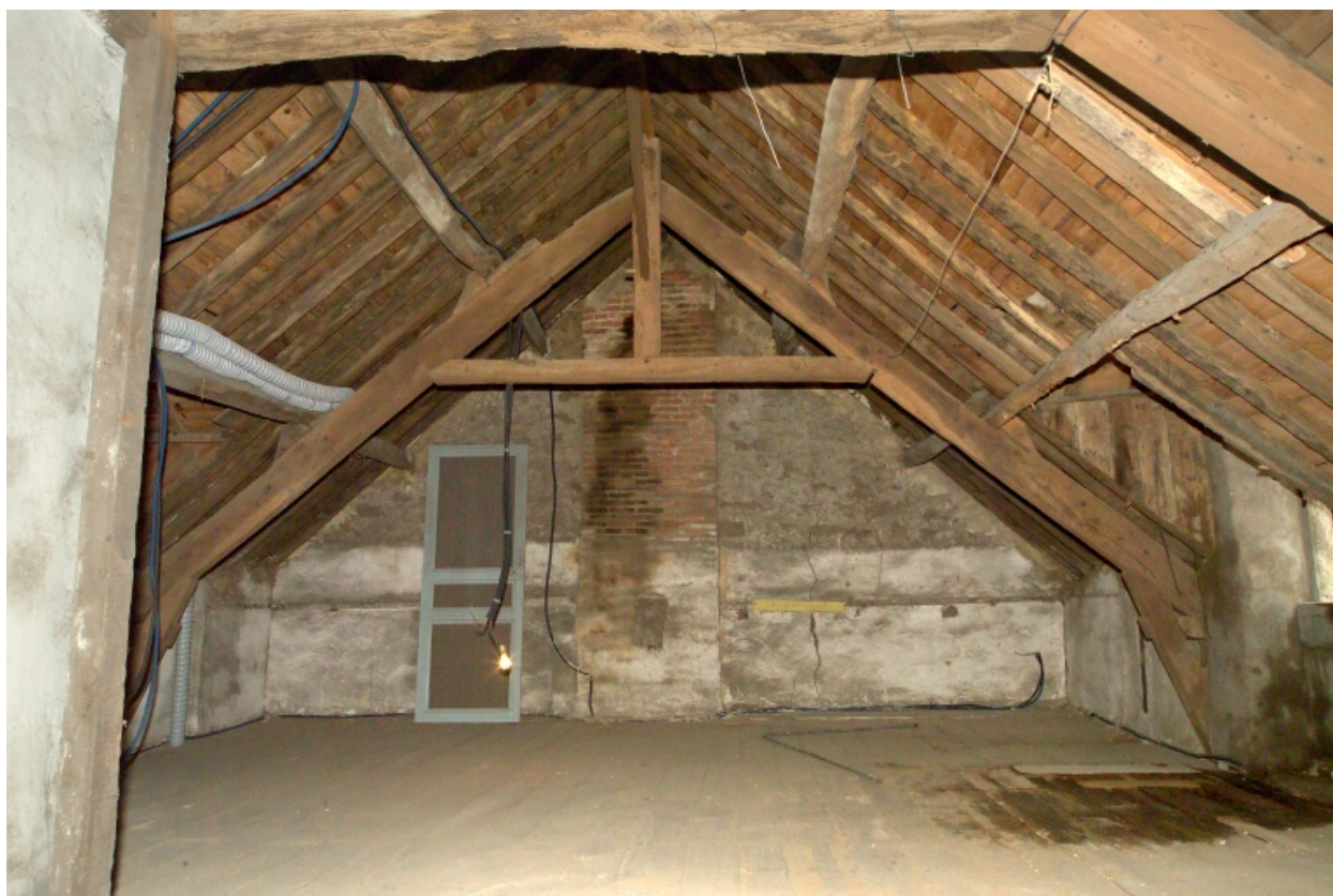
Vue de la charpente.
