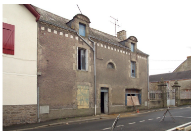
Vue de la façade sur rue. Phot. Denis Pillet IVR52_20074400308NUCA
