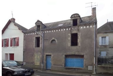
Vue de la façade sur rue. Phot. Denis Pillet IVR52_20074400484NUCA
