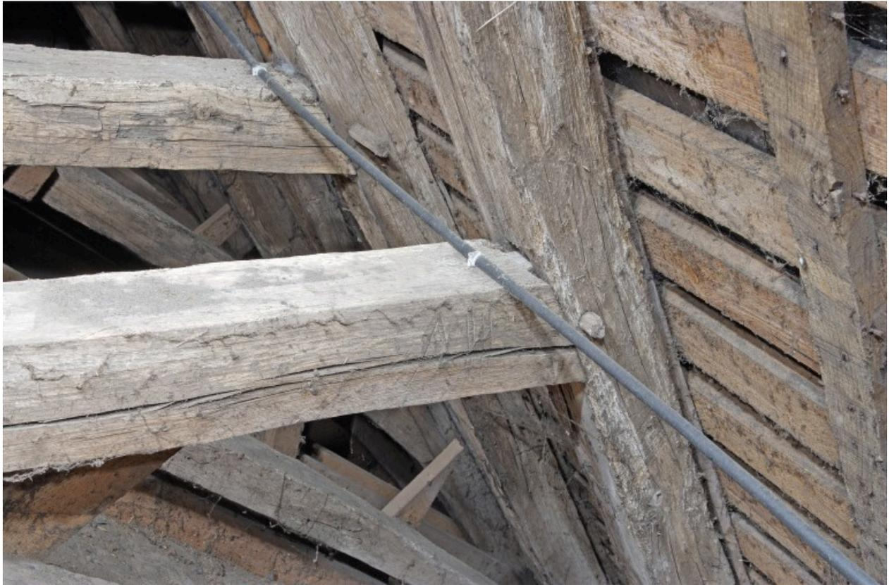
La charpente : vue de détail de l'assemblage des faux-entrants et des chevrons avec les marques.
