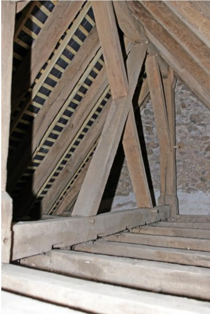
La charpente : vue de détail des chevrons, des faux-entrails et des aisseliers.
