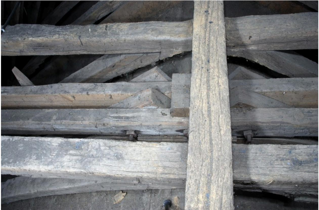
La charpente : vue de détail de deux fermes secondaires et d'une ferme moderne moisée.
