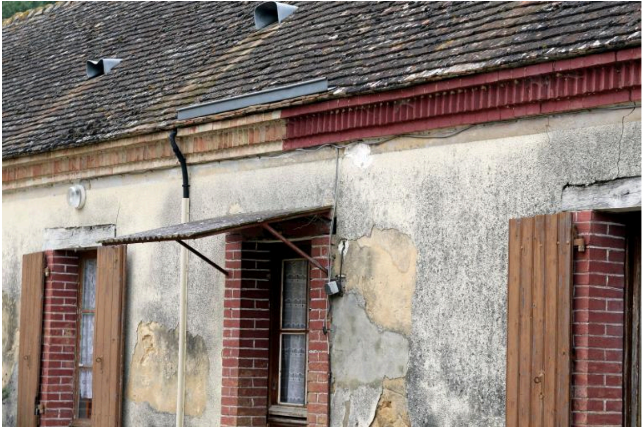
Logis, élévation antérieure : détail de la corniche.
