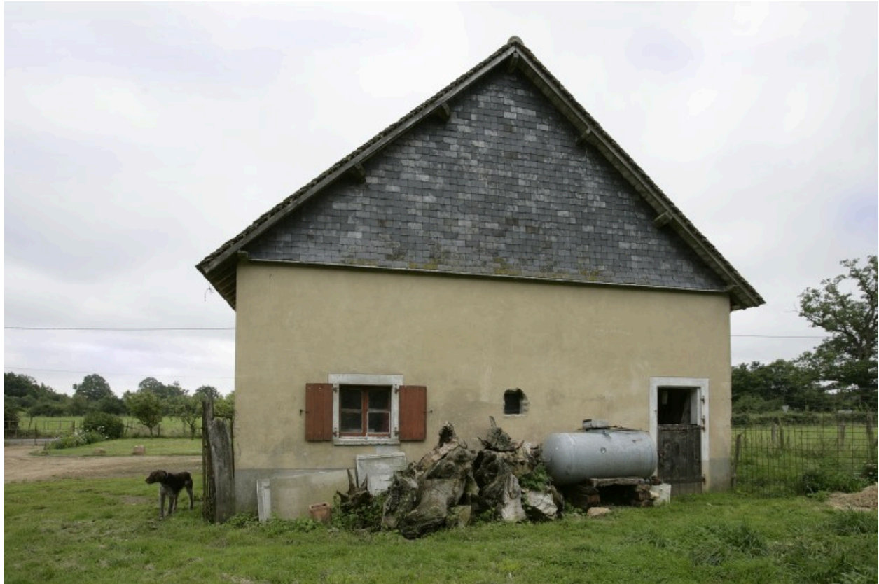
Grange-étable : mur-pignon ouest avec fenêtre du logement.
