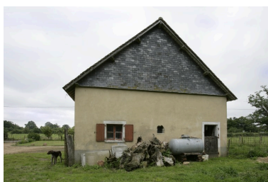
Grange-étable : mur-pignon ouest avec fenêtre du logement. Phot. François Lasa IVR52_20077200707NUCA
