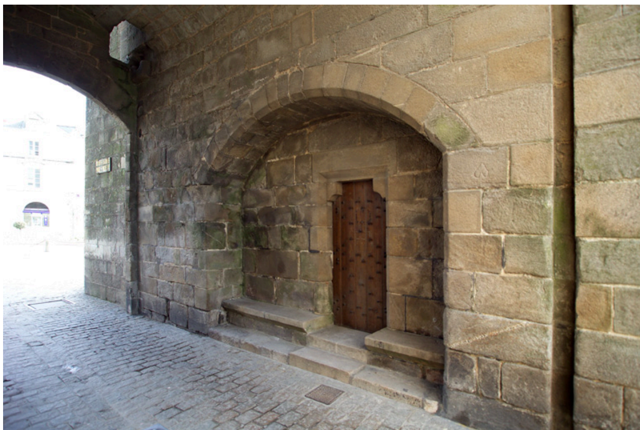
Vue du passage, détail du parement sud.
