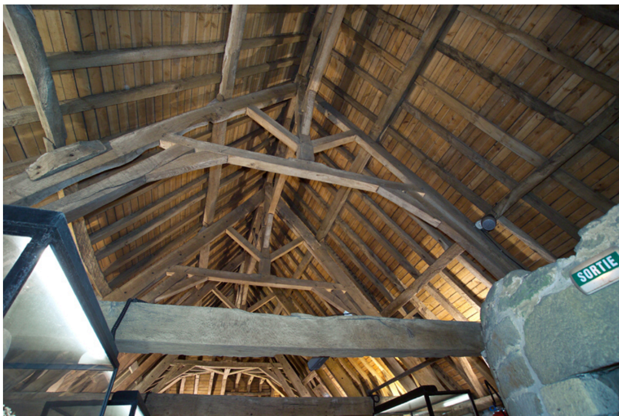
Vue de la charpente.
