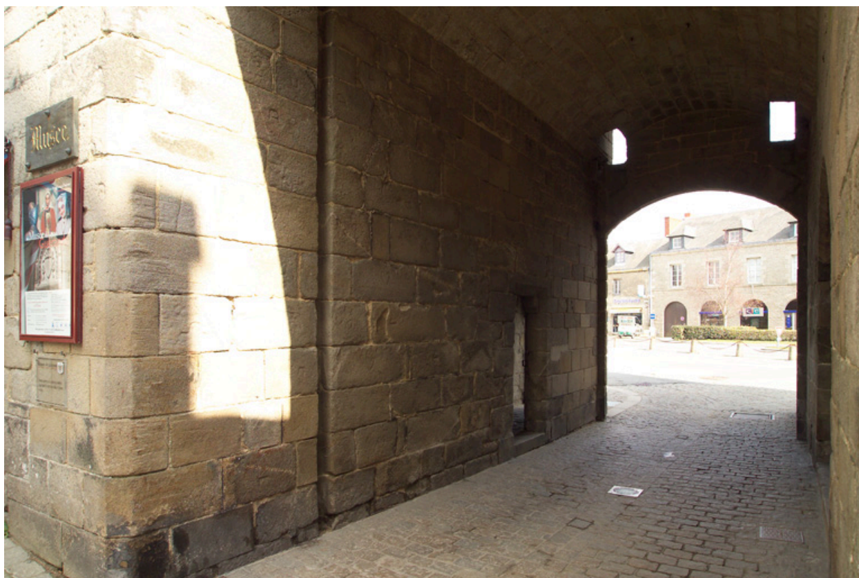
Vue du passage, parement nord.
