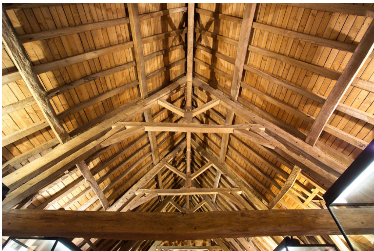
Vue de la charpente.
