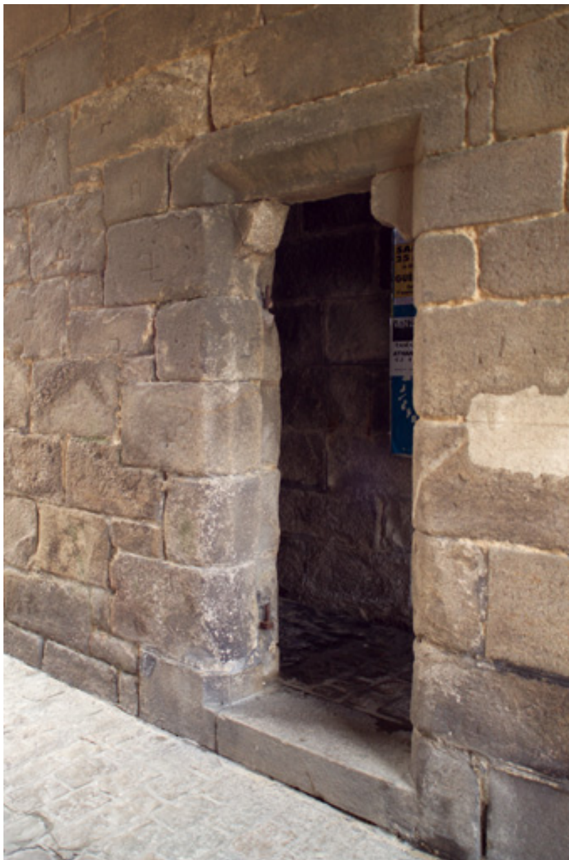
Vue du passage, détail de l'accès piéton.
