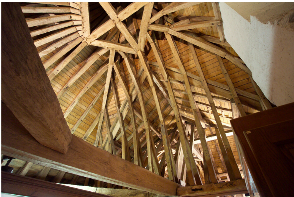
Vue de la charpente, couvrement de tour.
