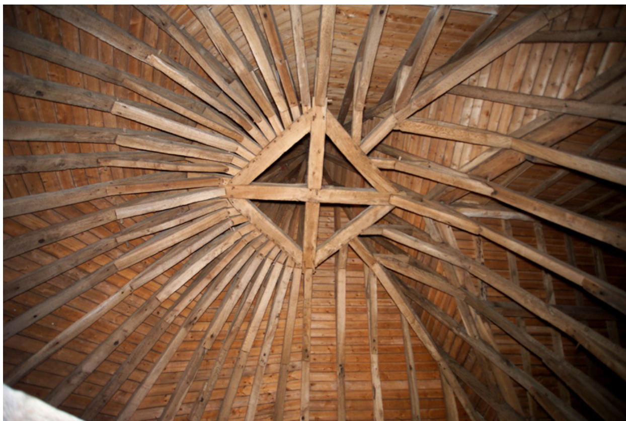
Vue de la charpente, couvrement de tour.
