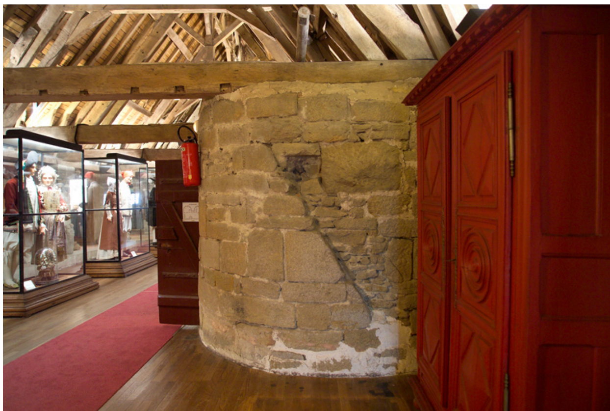
Vue du comble.
