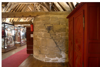
Vue du comble. Phot. Denis Pillet IVR52_20064401510NUCA
