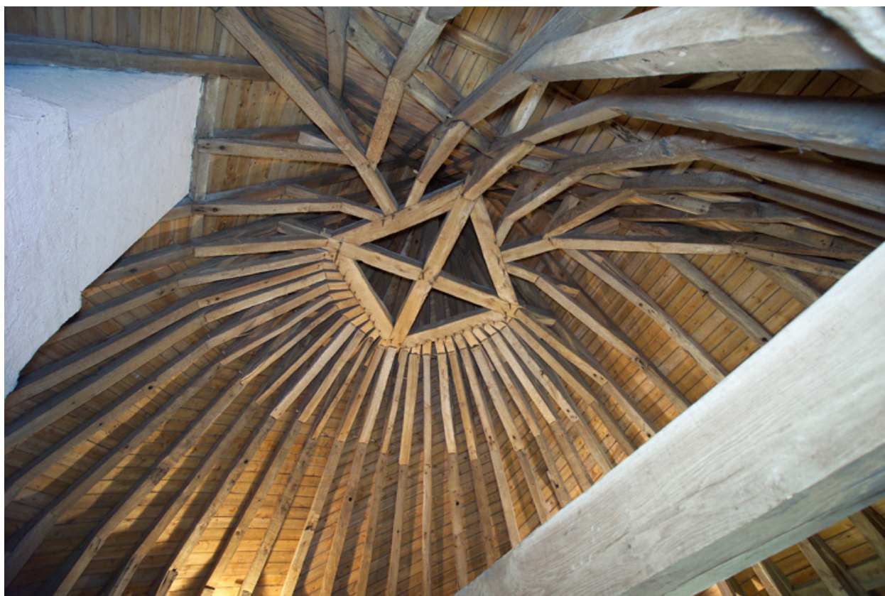
Vue de la charpente, couvrement de tour.
