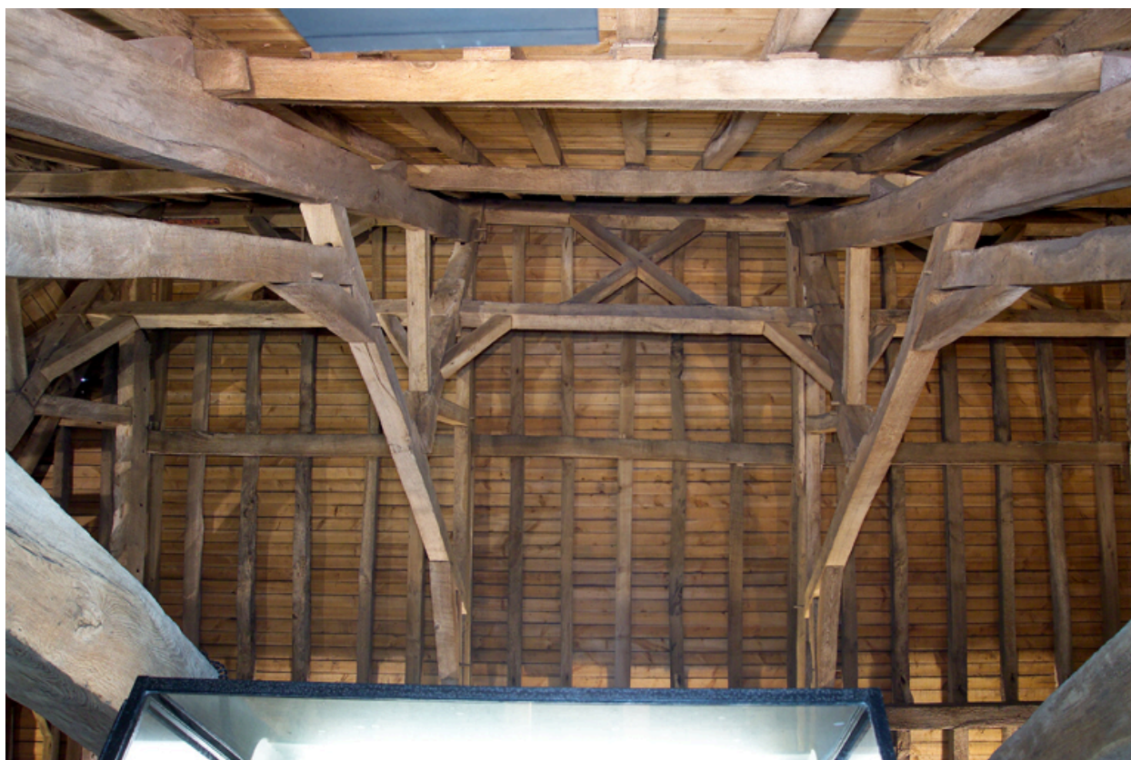
Vue de la charpente.
