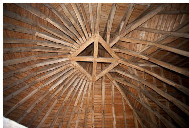
Vue de la charpente, couvrement de tour.
