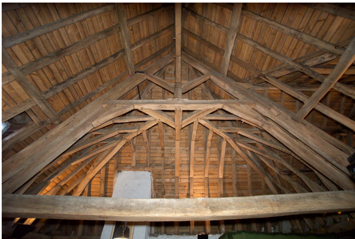
Vue de la charpente, croupe.
