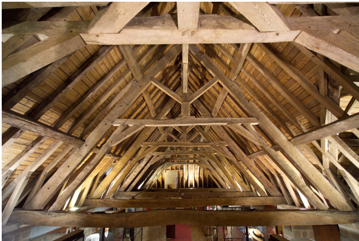
Vue de la charpente.
