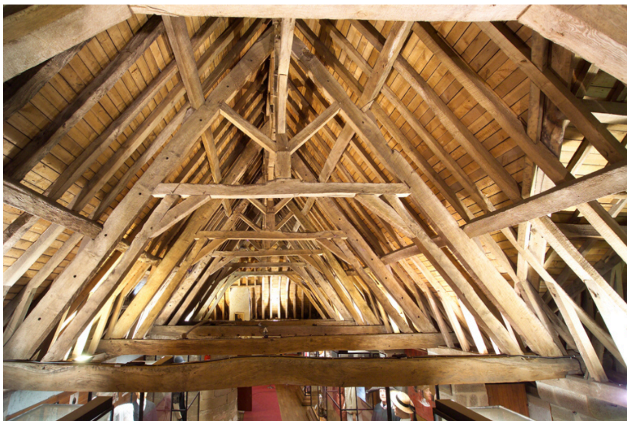
Vue de la charpente.
