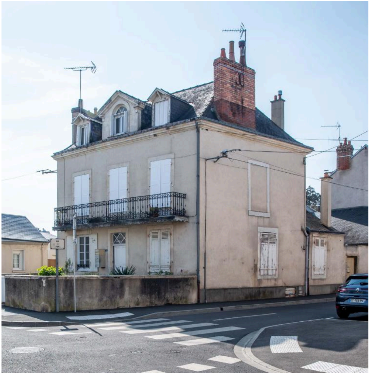
Vue du bâtiment de l'ancienne mairie de Saint-Pavin-des-champs.
