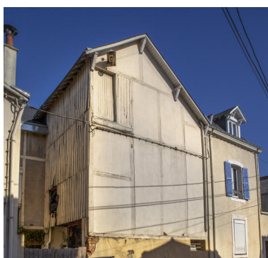
Vue d'un ancien atelier en pans de bois rue des Mûriers. Phot. Pierre-Bernard Fourny IVR52_20197201833NUCA
