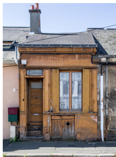
Vue d'une ancienne boutique rue Saint-Pavin. Phot. Pierre-Bernard Fourny IVR52_20187200915NUCA
