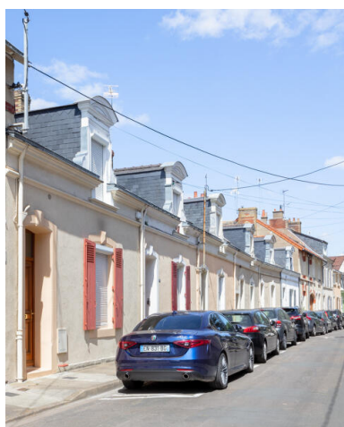
Vue de l'alignement de mancelles rue de Valmy. Phot. Paul Hamelin IVR52_20227200494NUCA
