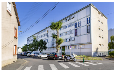
Vue d'un immeuble rue Amboise Paré. Phot. Pierre-Bernard Fourny IVR52_20197201895NUCA
