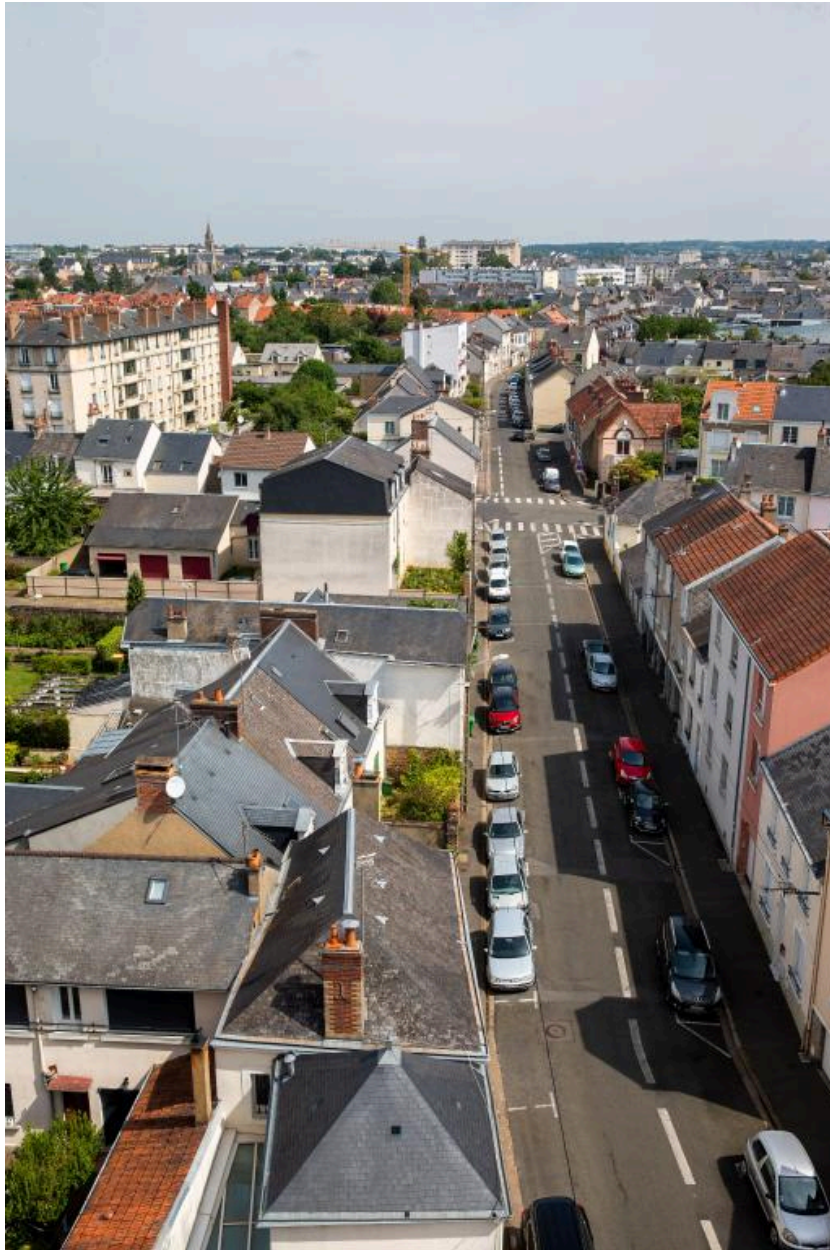
Vue de la rue de la Grande Maison depuis l'immeuble du Patis.
