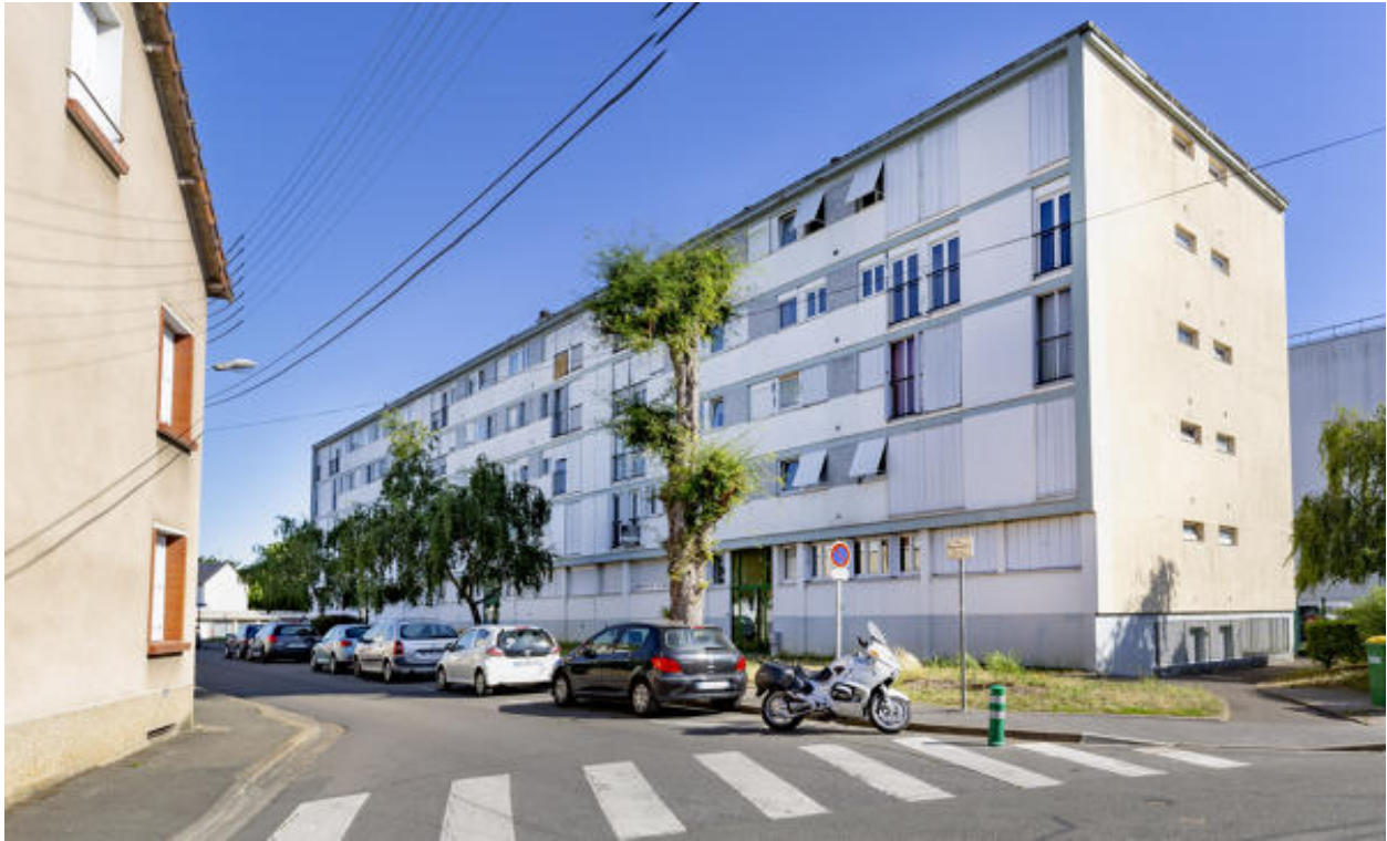
Vue d'un immeuble rue Amboise Paré.
