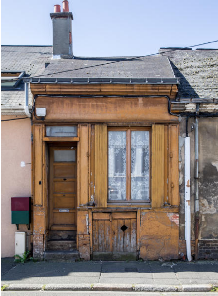
Vue d'une ancienne boutique rue Saint-Pavin.
