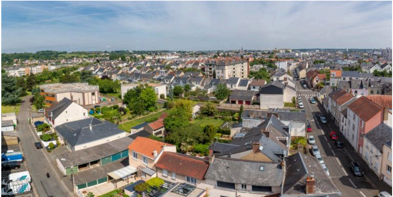
Vue de Saint-Pavin depuis l'immeuble du Pâtis.
