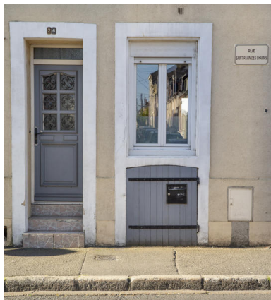
Vue d'une ancienne maison dite de tisserands rue Saint-Pavin. Phot. Pierre-Bernard Fourny IVR52_20197201827NUCA
