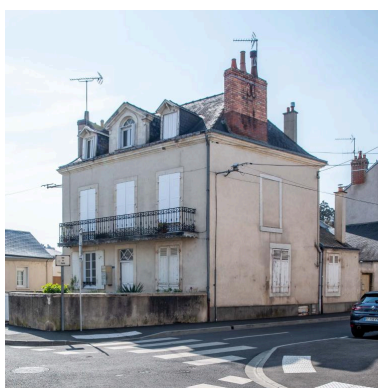
Vue du bâtiment de l'ancienne mairie de Saint-Pavin-des-champs. Phot. Pierre-Bernard Fourny IVR52_20197200528NUCA
