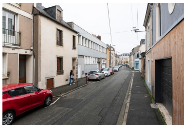
Vue de la rue Saint- Pavin-des-Champs. Phot. Thierry Seldubuisson IVR52_20227200353NUCA
