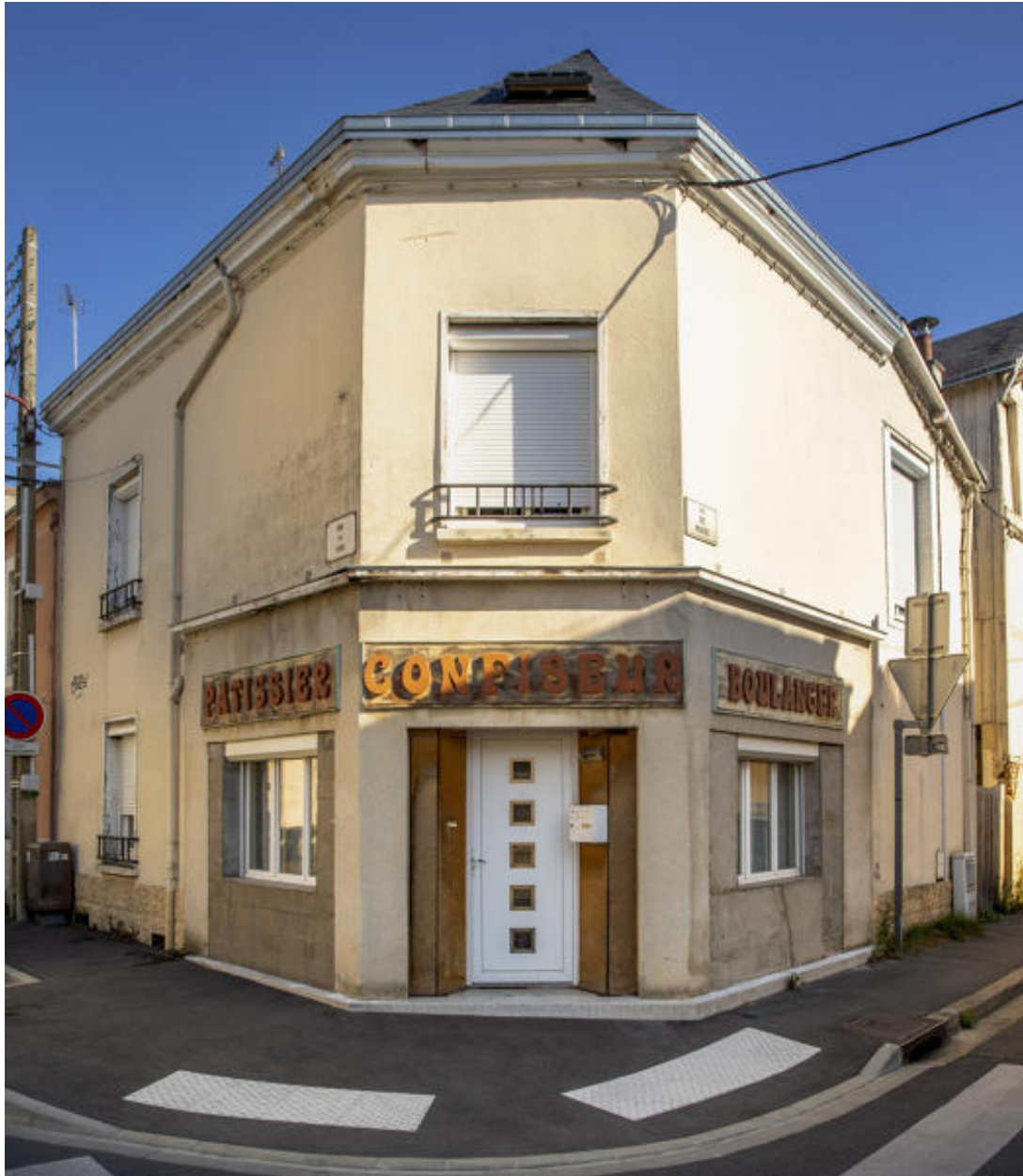
Vue d'une ancienne maison à commerce place de la croix de fer.
