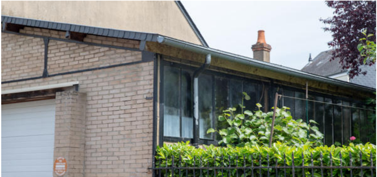
Vue d'un atelier à l'arrière d'une maison rue du Maréchal-Gallieni.
