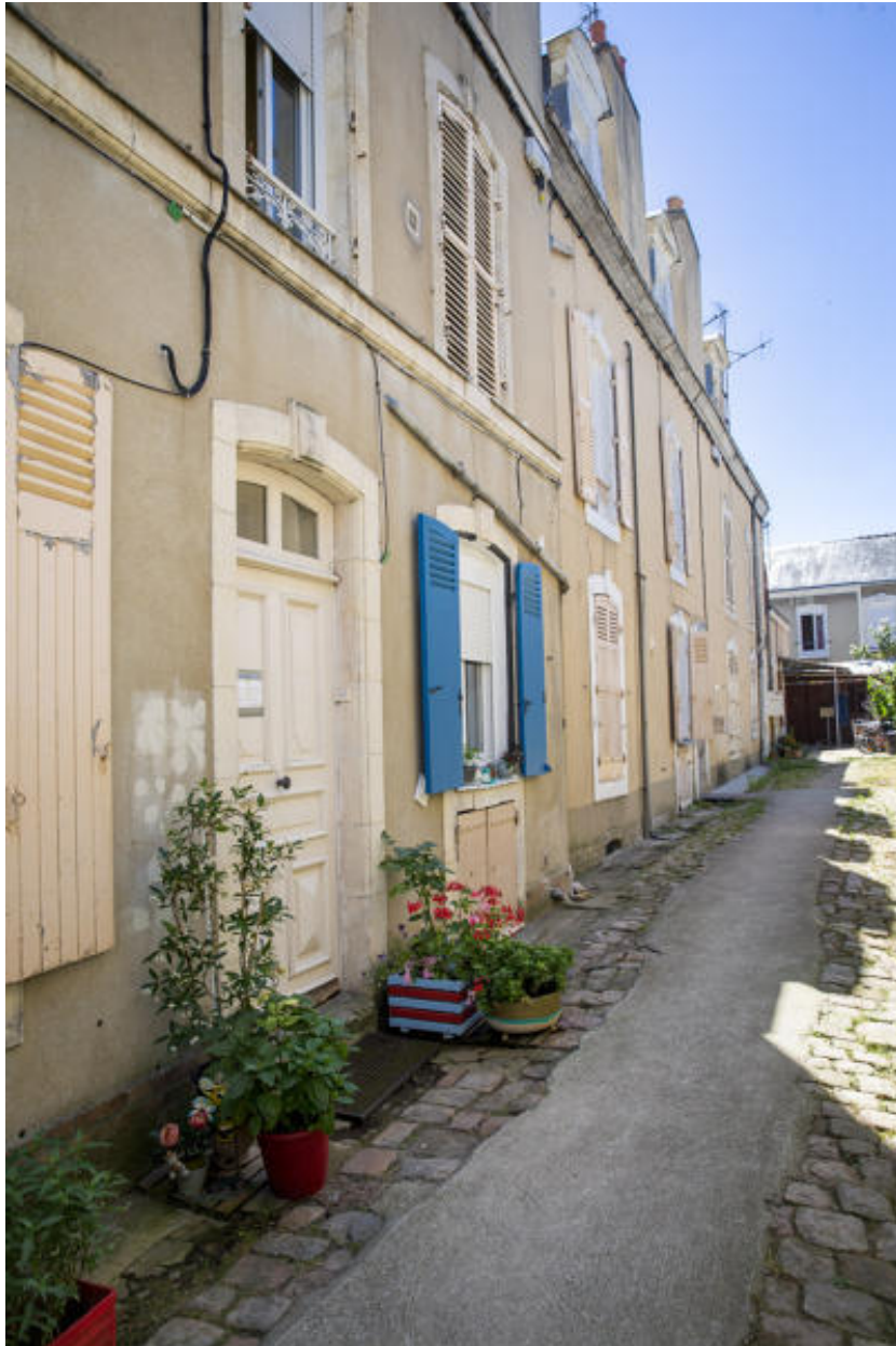
Vue d'une cour commune ouverte sur la rue Saint-Pavin.
