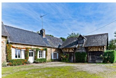
Maison et étable-grange de la ferme de la Basse-Cour Phot. Yves Guillotin IVR52_20175300212NUCA
