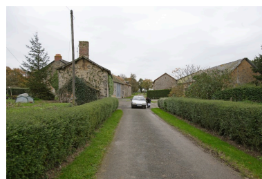
Vue d'ensemble depuis le chemin d'accès au nord-ouest : au premier plan, les pignons du fournil et de la porcherie ; au second, ceux du logis- étable-grange et de l'étable-grange. Phot. François Lasa IVR52_20065302741NUCA
