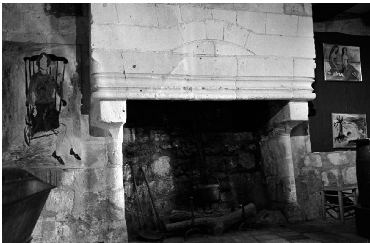
Rez-de-chaussée, salle sud. Cheminée du XVe siècle, contre le pignon sud (en 1979).
