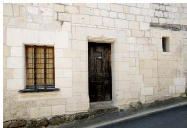
Rez-de-chaussée du pignon sur rue : baies reprises à la fin du XXe siècle et médiévalisées (moulurations et accolades). Phot. Bruno Rousseau IVR52_20134900736NUCA
