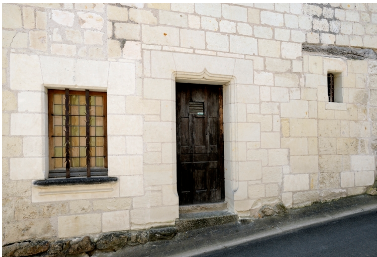
Rez-de-chaussée du pignon sur rue : baies reprises à la fin du XXe siècle et médiévalisées (moulurations et accolades).
