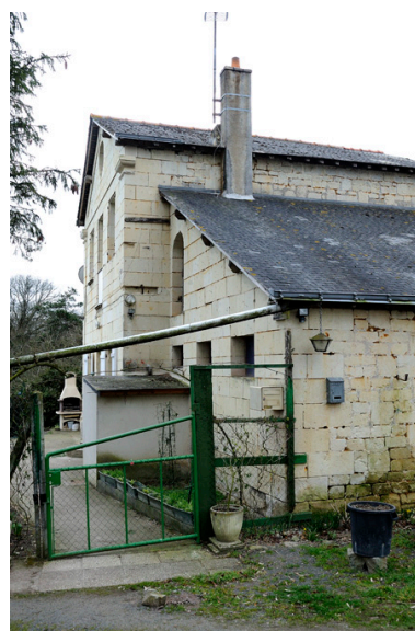
Angle nord-est du bâtiment principal Phot. Bruno Rousseau, Phot. Youenn Communeau IVR52_20114900699NUCA
