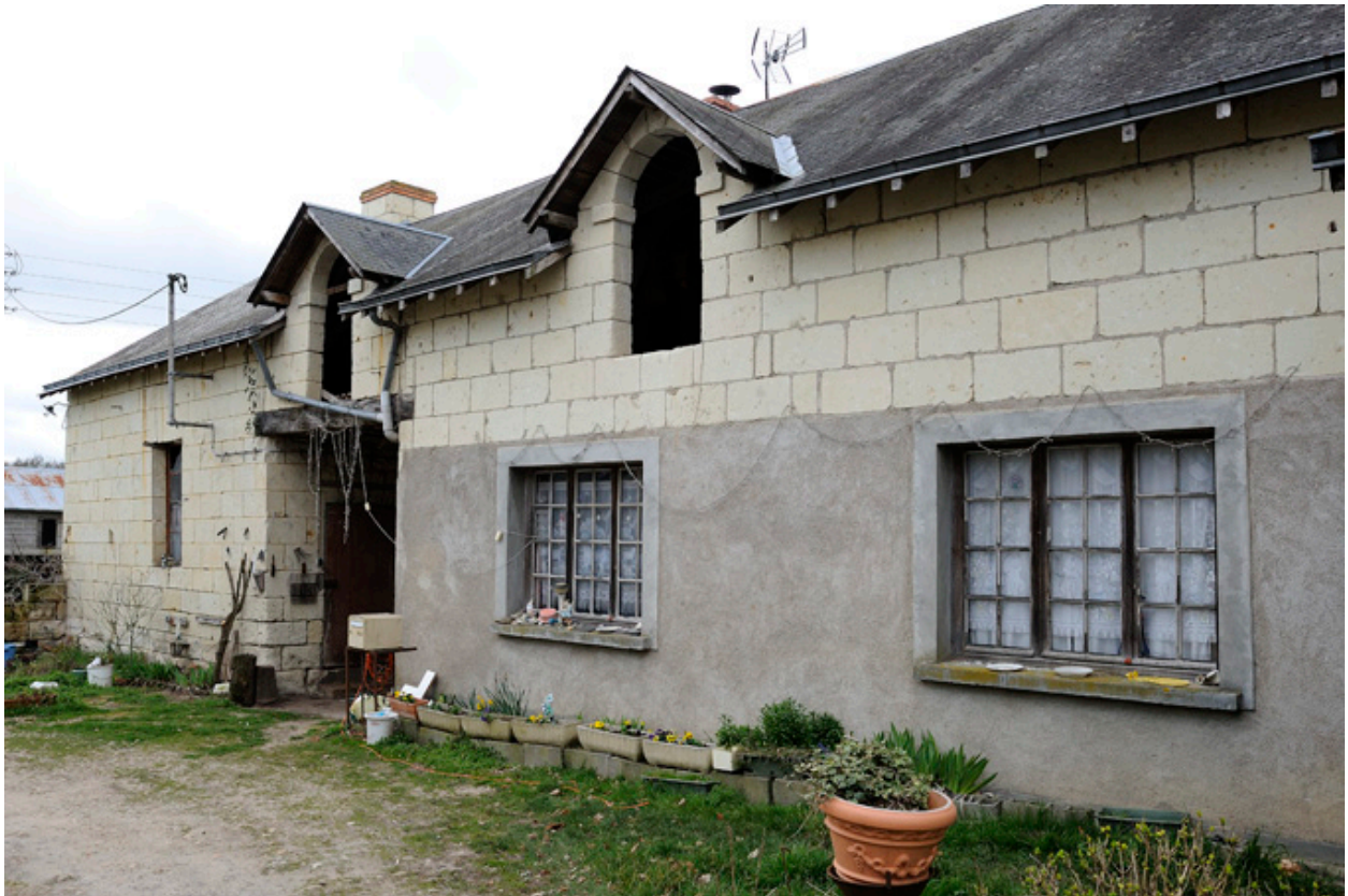
Communs et logement, depuis la cour
