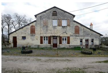
Façade postérieure, sur cour Phot. Bruno Rousseau, Phot. Youenn Communeau IVR52_20114900702NUCA
