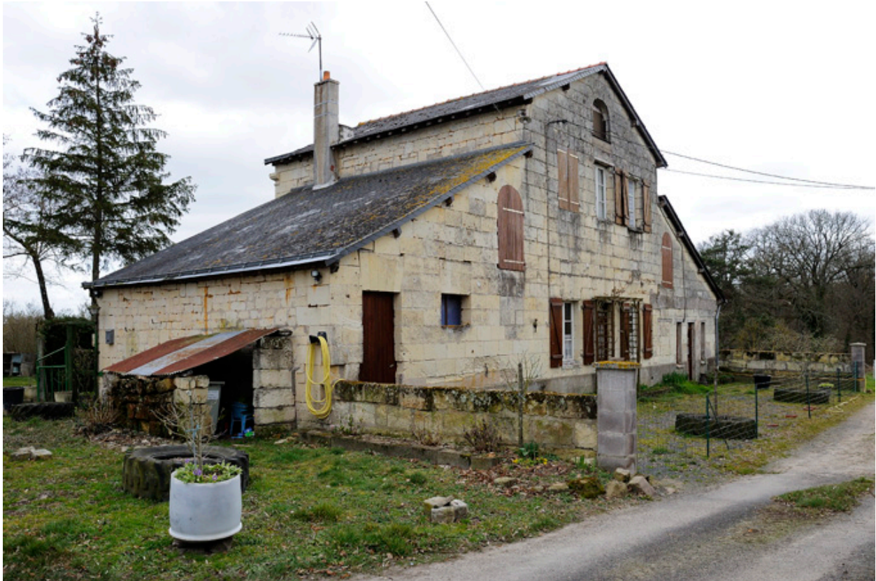
Angle nord-ouest du bâtiment principal
