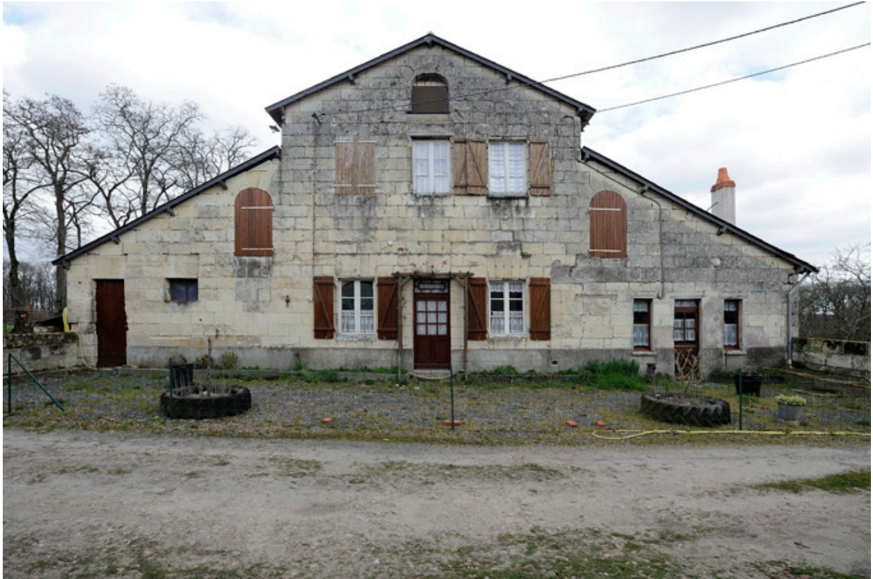
Façade postérieure, sur cour
