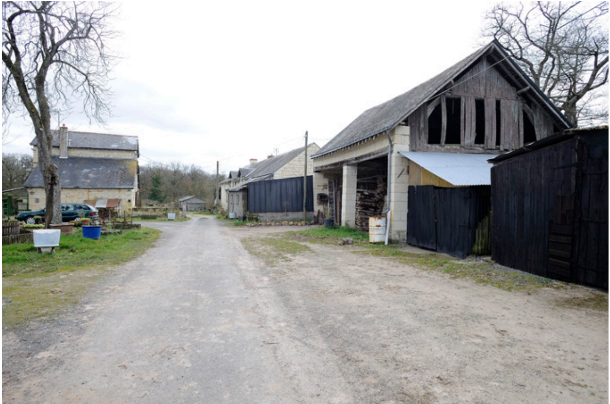
Vue d'ensemble, depuis le chemin d'accès nord
