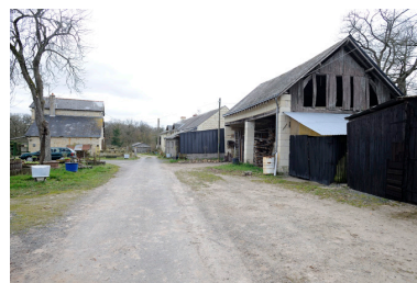
Vue d'ensemble, depuis le chemin d'accès nord Phot. Bruno Rousseau, Phot. Youenn Communeau IVR52_20114900706NUCA
