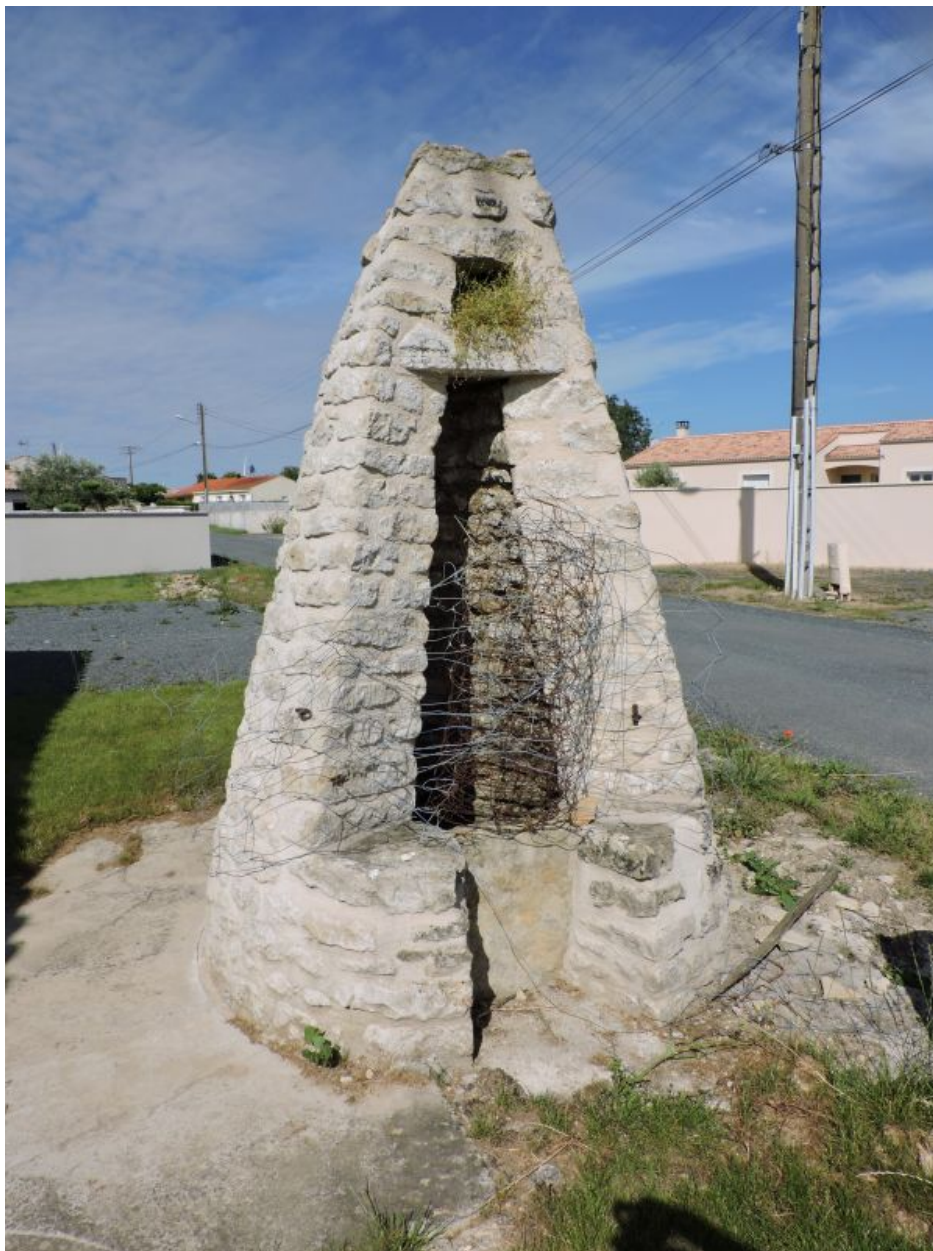
Le puits vu depuis l'est.
