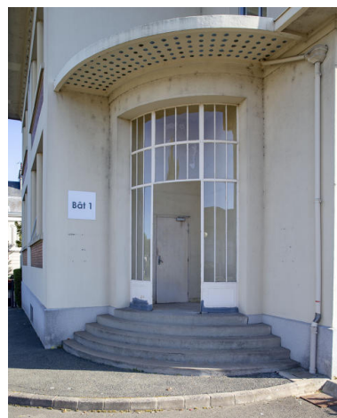
Vue de l'entrée en angle du bâtiment à bureaux depuis le sud-ouest. Phot. Pierre-Bernard Fourny IVR52_20197202114NUCA
