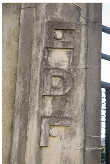
Vue de l'inscription EDF sur le portail. Phot. Pierre-Bernard Fourny IVR52_20197202096NUCA
