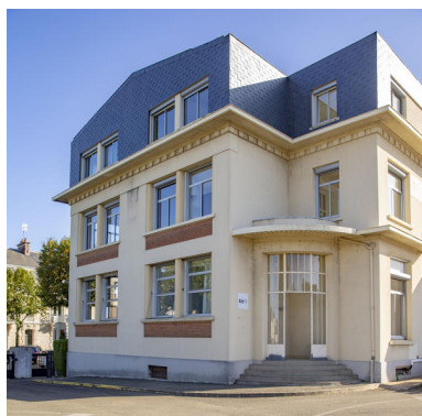
Vue du bâtiment de l'immeuble à bureaux depuis le sud-ouest. Phot. Pierre-Bernard Fourny IVR52_20197202115NUCA
