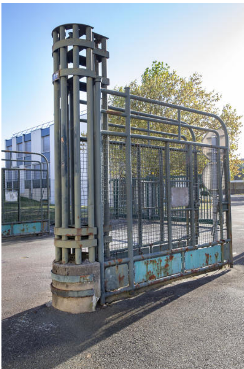
Vue du jambage central du porche d'entrée côté rue du colonel Reynal.
