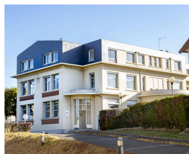
Vue du bâtiment de bureaux. Phot. Pierre-Bernard Fourny IVR52_20197202099NUCA
