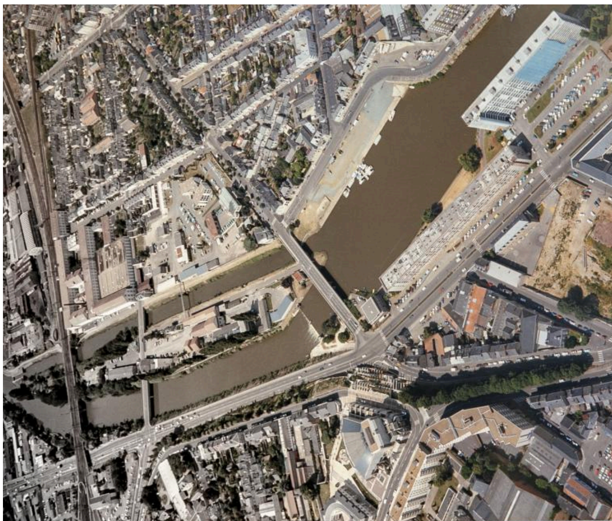
Vue aérienne de l'île et des rives de Sarthe avec l'usine EDF-GDF, 1987.
