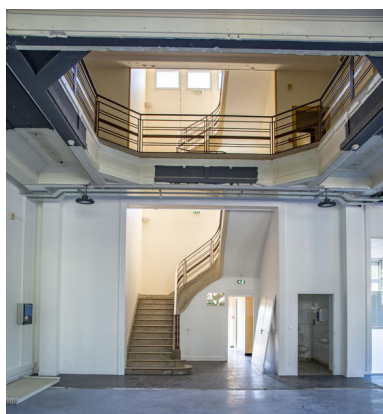
Vue de l'escalier donnant dans le hall principal du bâtiment à bureaux.
