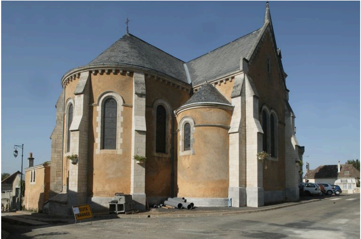
Vue du chevet et du bras nord du transept.
