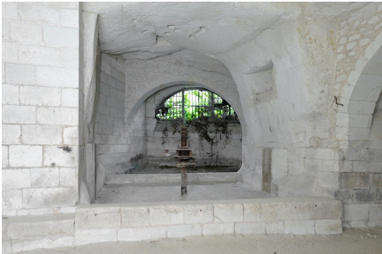
Champfleury : caves. Détail du pressoir : traces d'anciens mécanismes de pressoir à roue et vestiges d'un pressoir à vis métallique et cage en bois.
