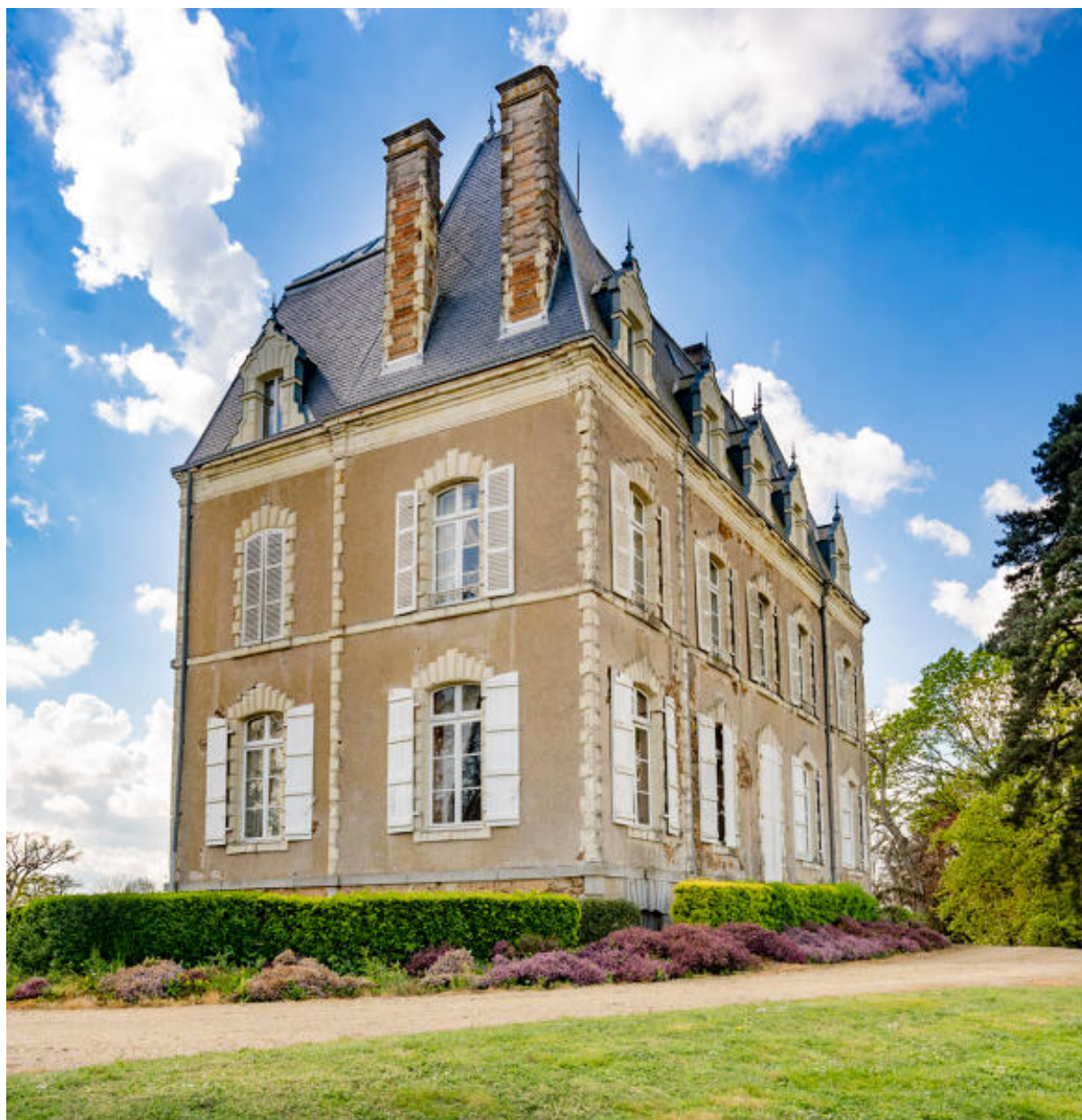
La façade nord vers la Mayenne.
