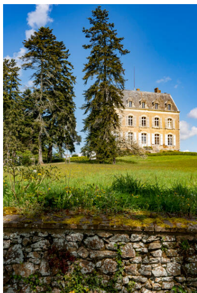
La demeure côté sud. Phot. Pierre-Bernard Fourny IVR52_20225300446NUCA
