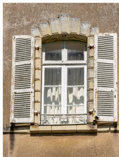
Une fenêtre de la demeure. Phot. Pierre-Bernard Fourny IVR52_20225300456NUCA
