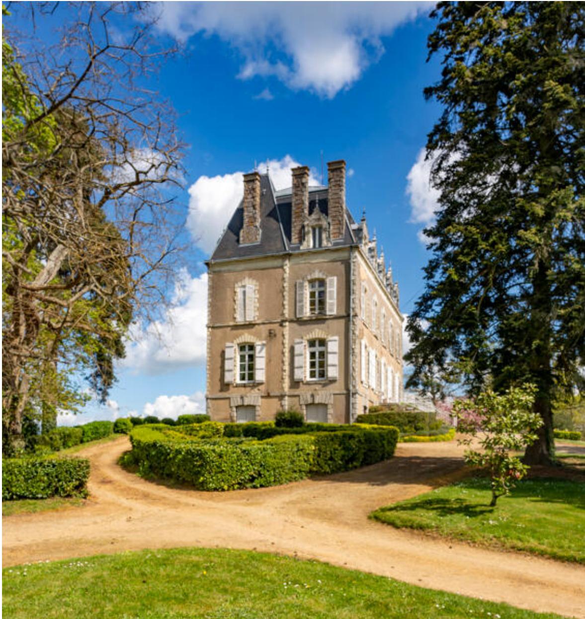
La façade latérale ouest.
