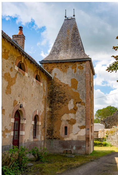
La tour des communs. Phot. Pierre-Bernard Fourny IVR52_20225300470NUCA
