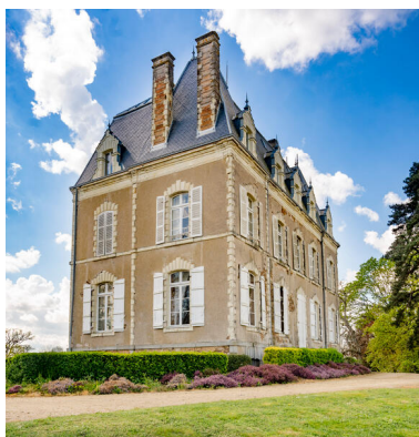
La façade nord vers la Mayenne. Phot. Pierre-Bernard Fourny IVR52_20225300459NUCA
