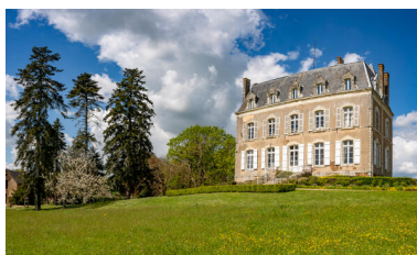
La demeure côté sud. Phot. Pierre-Bernard Fourny IVR52_20225300453NUCA
