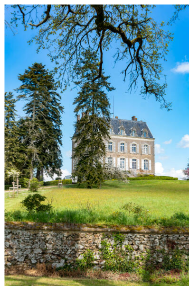
La demeure côté sud. Phot. Pierre-Bernard Fourny IVR52_20225300450NUCA
