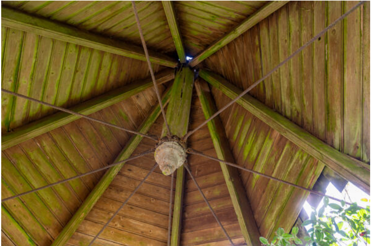
Un détail de la charpente du kiosque.
