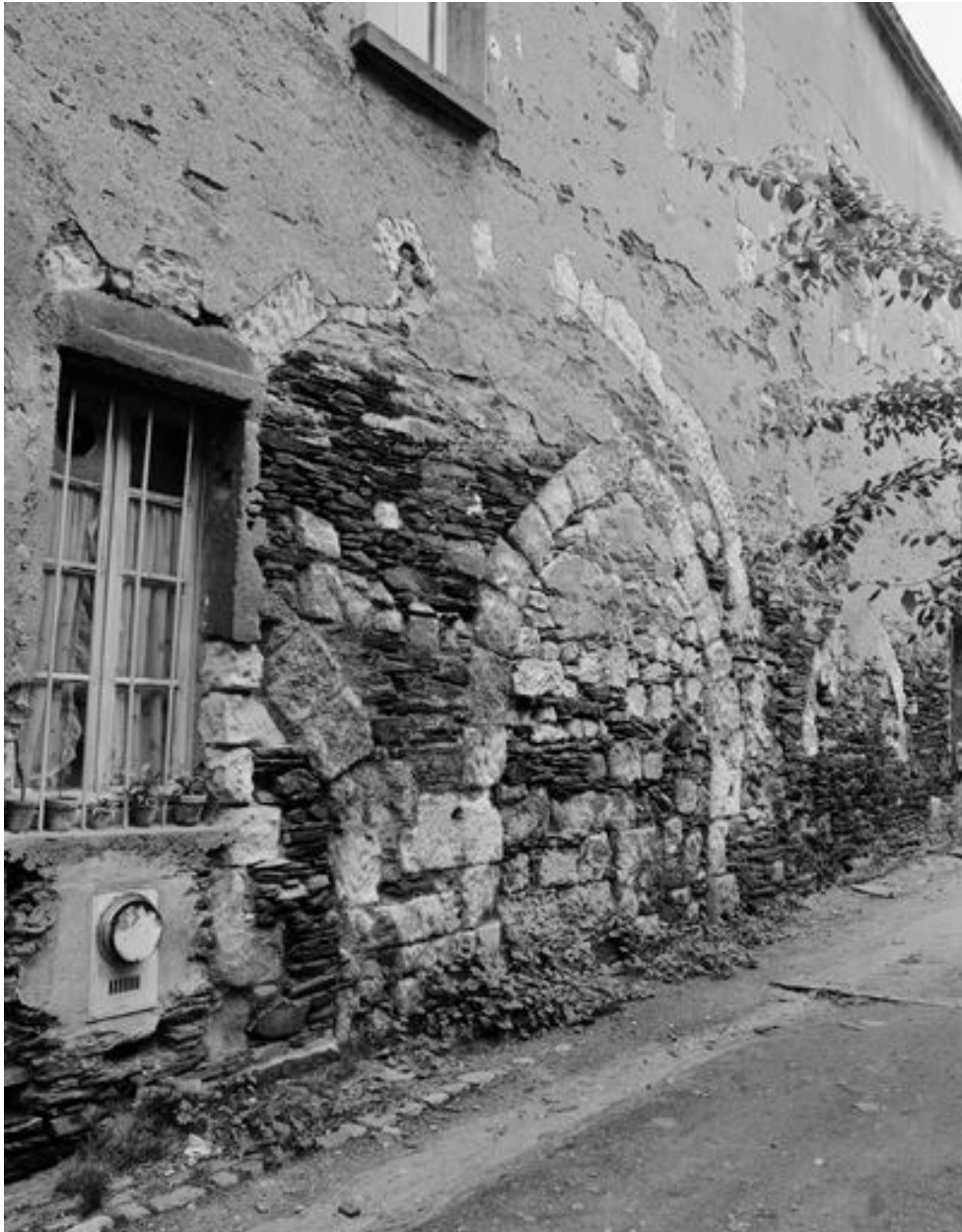
Vestiges de la salle du chapitre, détail de l'élévation intérieure nord visible dans la cour, 15 rue des Carmes.
