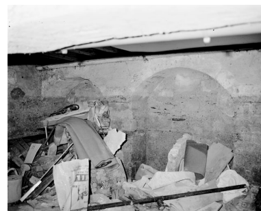
Aile sud du logement des religieux, arcs en sous-sol situés 14 rue des Carmes. Phot. François Lasa IVR52_19834902111X
