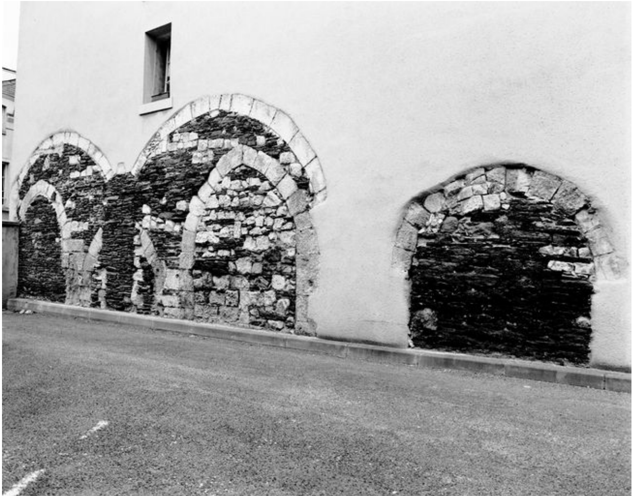
Vestiges de la salle du chapitre : élévation intérieure nord visible dans la cour, 15 rue des Carmes.
