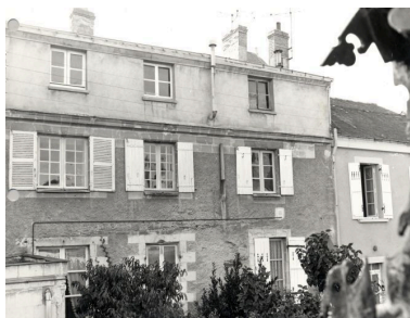
Aile sud du logement des religieux : façade ouest sur jardin remployée dans un lotissement de demeures : partie située 18 quai des Carmes, vue d'ensemble. Phot. François Lasa IVR52_19834902104X
