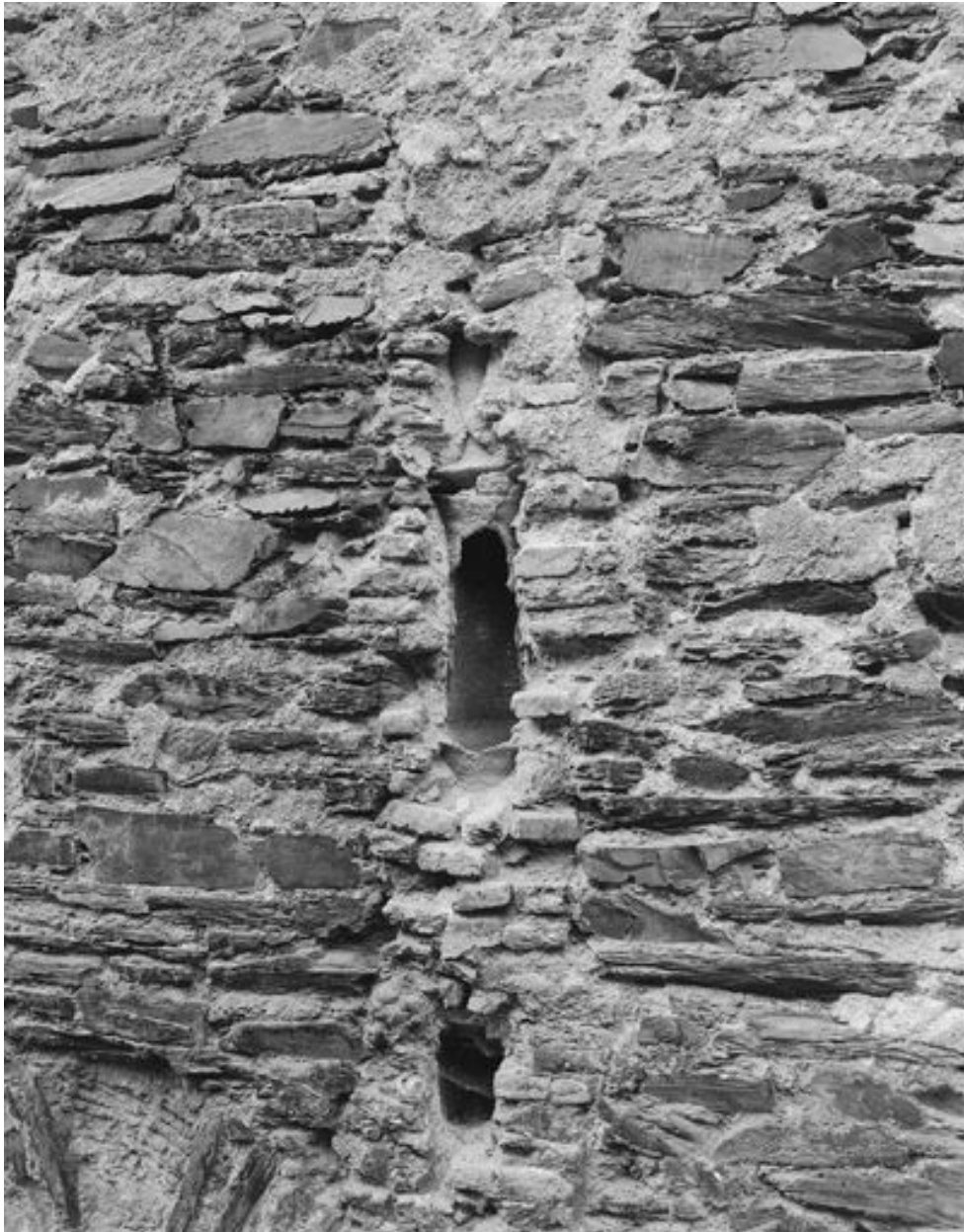
Vestige de l'aile orientale du cloître, élévation sur la rue Bonnetière : détails de maçonnerie et de canalisation.
