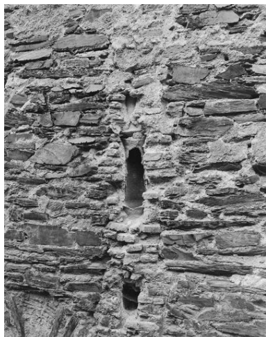
Vestige de l'aile orientale du cloître, élévation sur la rue Bonnetière : détails de maçonnerie et de canalisation. Phot. François Lasa IVR52_19794901713X
