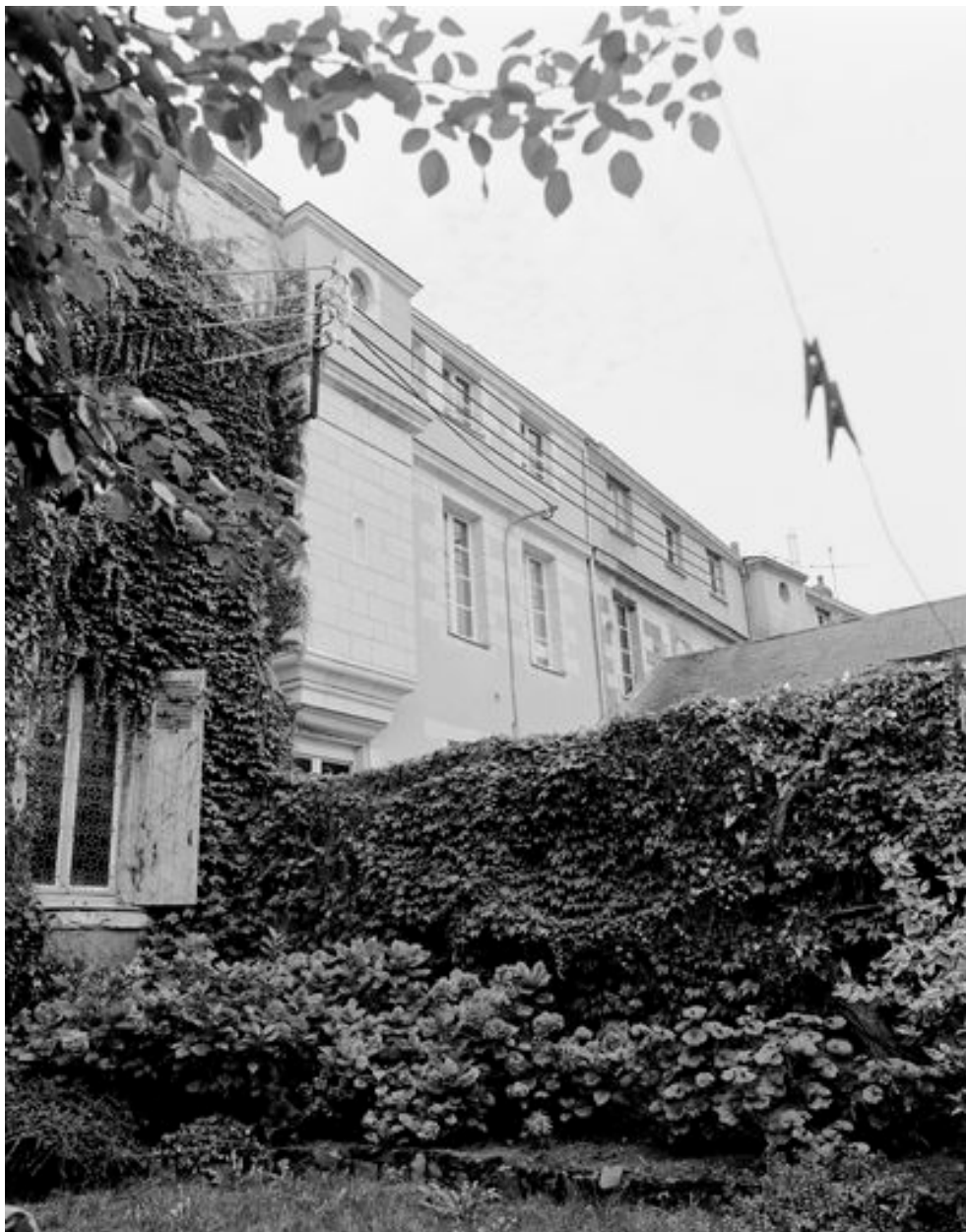
Aile sud du logement des religieux : façade ouest sur jardin remployée dans un lotissement de demeures : vue des parties hautes aux 16 et 18 quai des Carmes.
