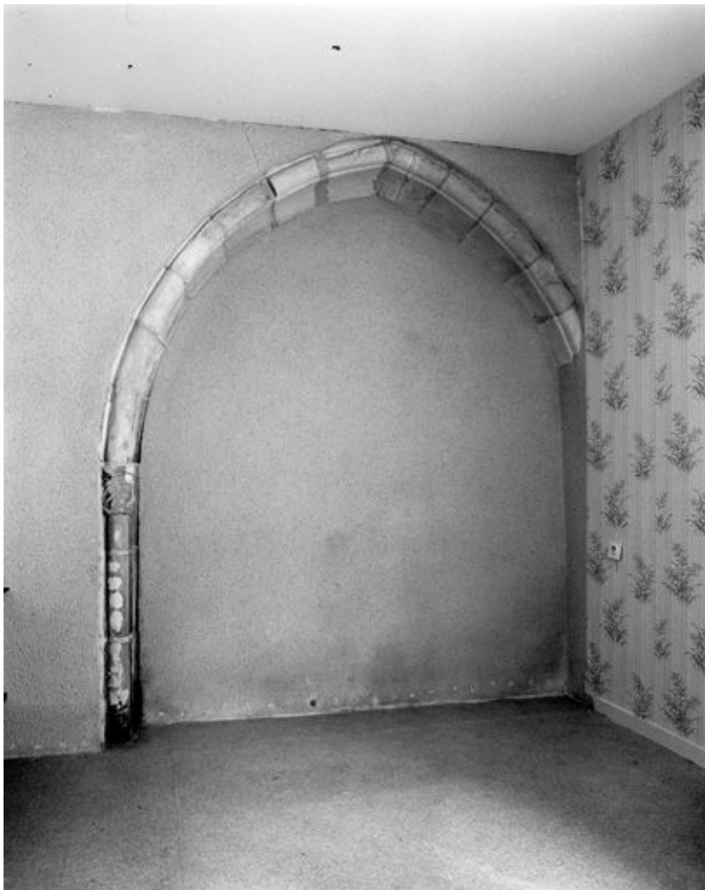
Vestige de la salle du chapitre, mur nord, arcade située à l'extrémité ouest : face extérieure (nord) donnant initialement sur le cloître. Visible actuellement au rez-de-chaussée de l'immeuble, 13 rue des Carmes.
