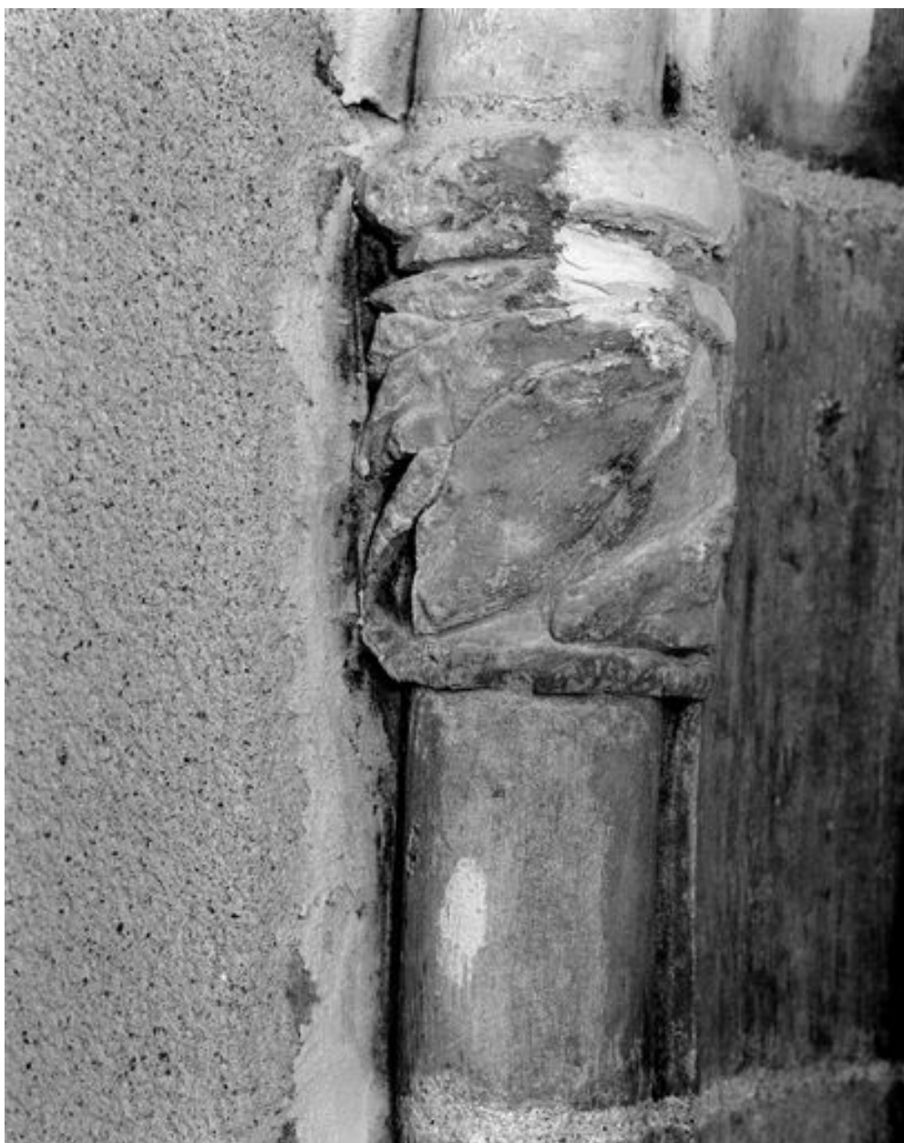
Vestige de la salle du chapitre, mur nord : arcade située à l'extrémité ouest, face extérieure (nord) donnant initialement sur le cloître : détail sur le chapiteau de gauche (sud).
