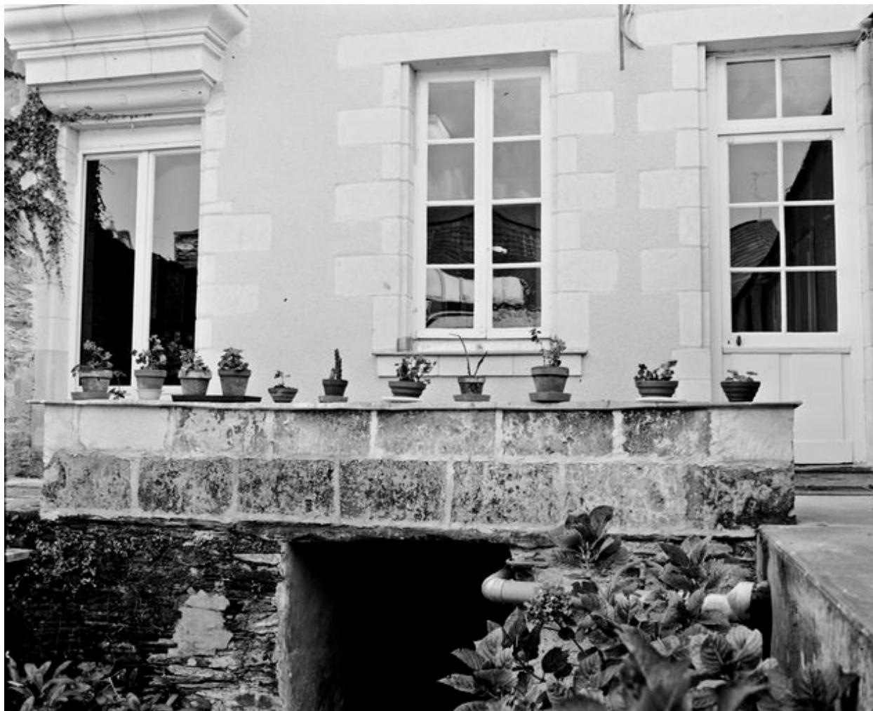
Aile sud du logement des religieux : façade ouest sur jardin remployée dans un lotissement de demeures : partie située 16 quai des Carmes, détail sur les baies du rez-de-chaussée.
