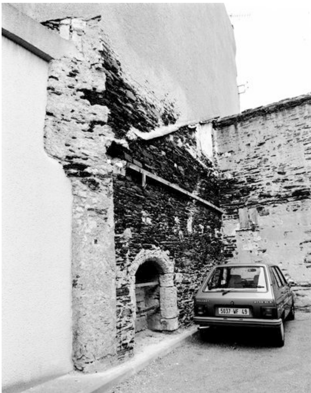
Porte de communication entre l'aile orientale du cloître et le pavillon de la cuisine : élévation côté cuisine. Visible dans la cour, 15 rue des Carmes.
