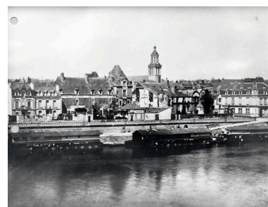
Vue d'ensemble du quai des Carmes, avec le couvent du même nom sur la partie gauche du document : pavillon de la cuisine et aile nord du logement des religieux, fotogr., entre 1886 et 1889. Phot. François Lasa IVR52_19834902112X
