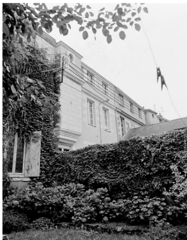
Aile sud du logement des religieux : façade ouest sur jardin remployée dans un lotissement de demeures : vue des parties hautes aux 16 et 18 quai des Carmes. Phot. François Lasa IVR52_19834902121X
