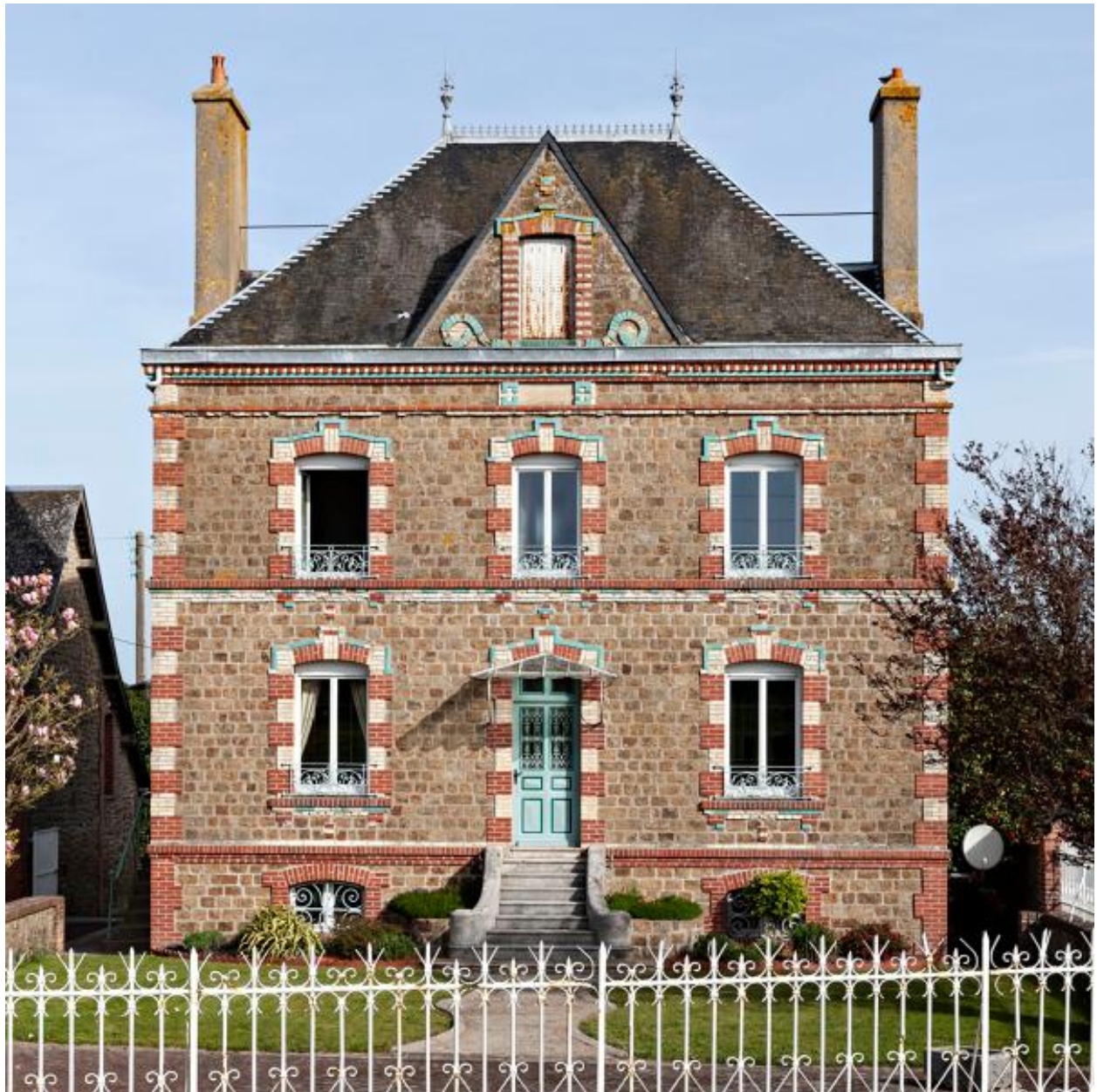
Ferme du Fresne, maison.
