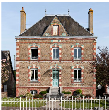
Ferme du Fresne, maison. Phot. Yves Guillotin IVR52_20195300464NUCA
