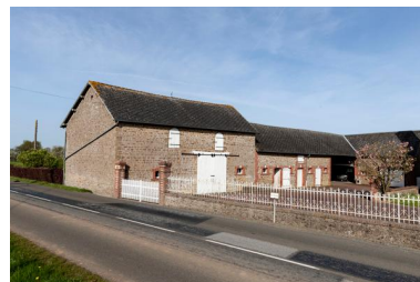
Ferme du Fresne : remise, étable, fenil, grange. Phot. Yves Guillotin IVR52_20195300463NUCA
