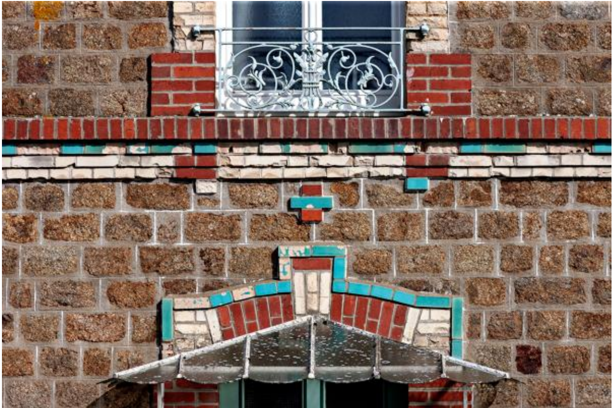
Ferme du Fresne, travée centrale, bandeau courant entre le rez-de-chaussée et le premier niveau.
