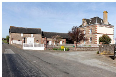
Ferme du Fresne, vue d'ensemble depuis la route. Phot. Yves Guillotin IVR52_20195300462NUCA
