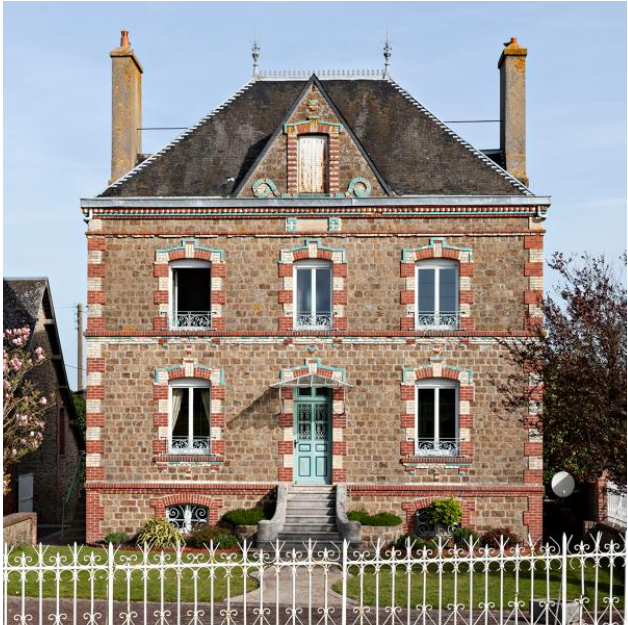
Ferme du Fresne, maison.
