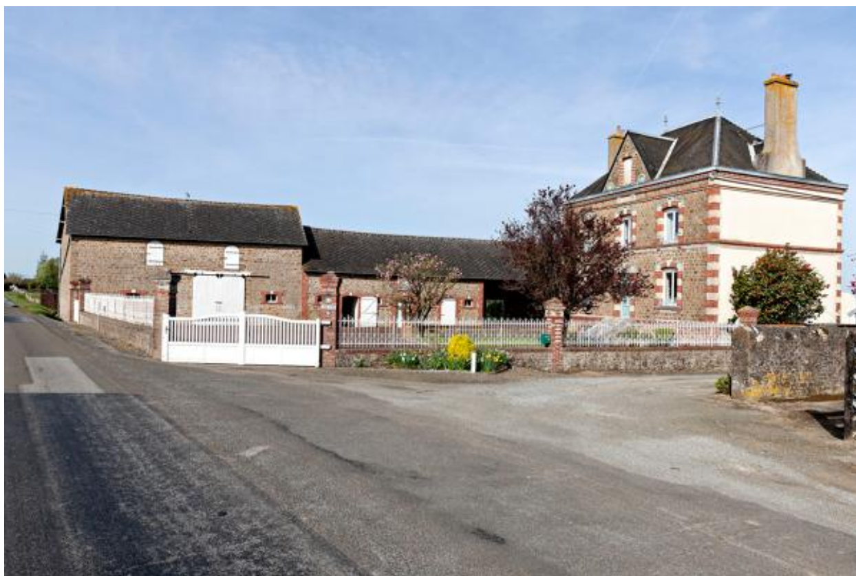
Ferme du Fresne, vue d'ensemble depuis la route.
