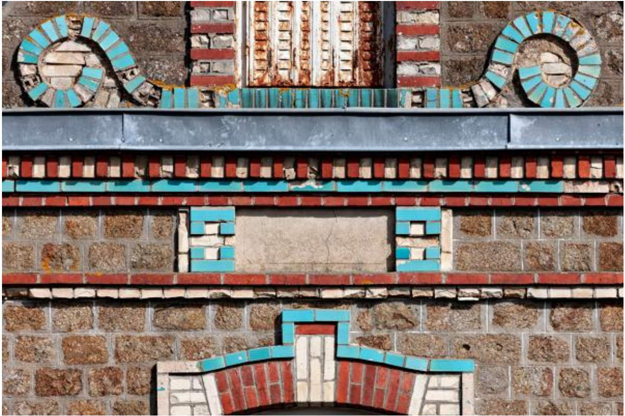
Ferme du Fresne, travée centrale, décor de briques, base de la lucarne.
