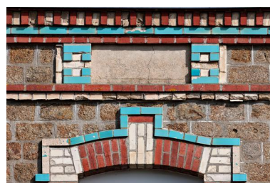
Ferme du Fresne, linteau et table surmontant la fenêtre de la travée centrale du premier niveau. Phot. Yves Guillotin IVR52_20195300468NUCA
