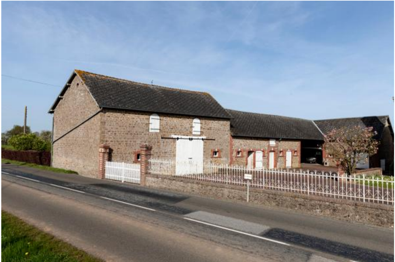
Ferme du Fresne : remise, étable, fenil, grange.
