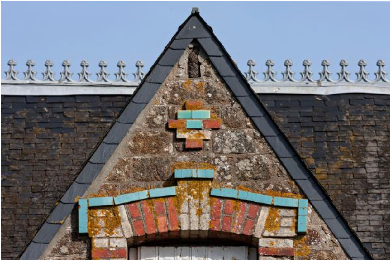
Ferme du Fresne, haut de la lucarne de la maison.
