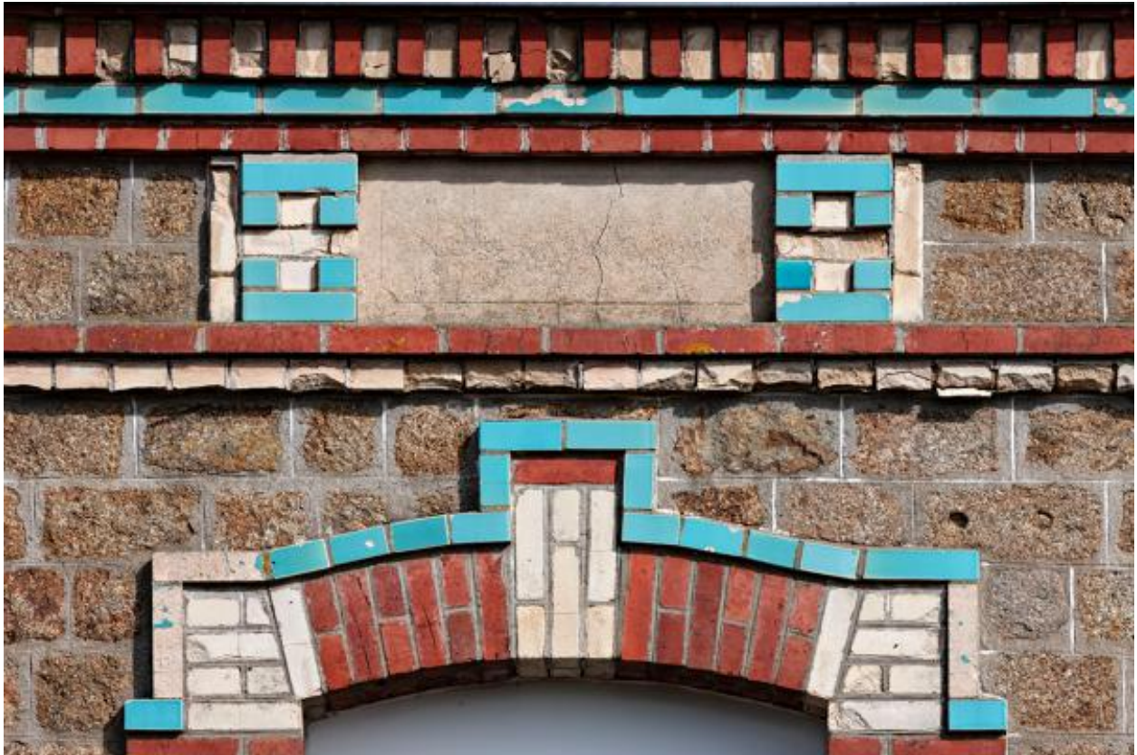
Ferme du Fresne, linteau et table surmontant la fenêtre de la travée centrale du premier niveau.
