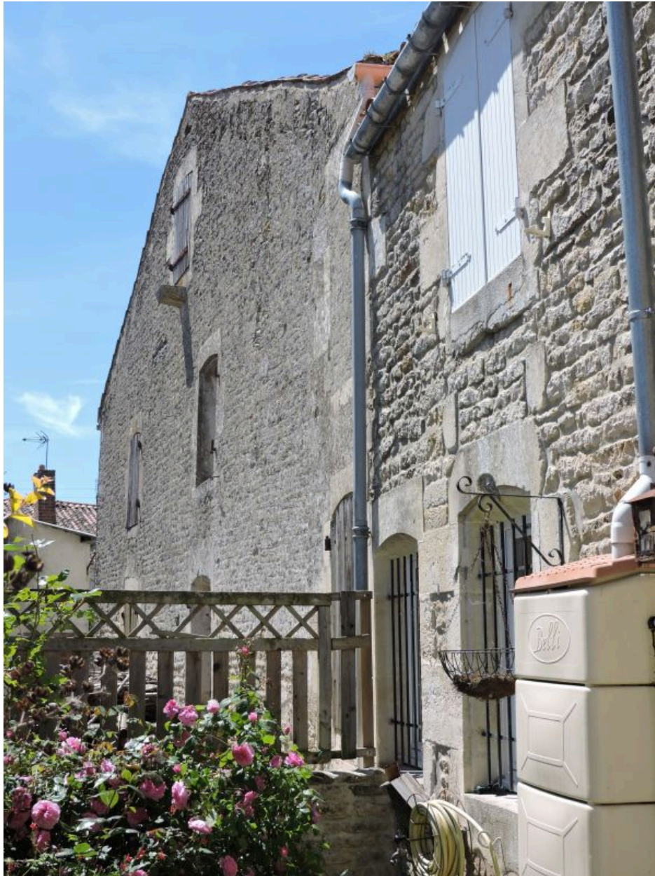
A droite, les baies de l'aile ouest, avec linteaux en arc délardé.
