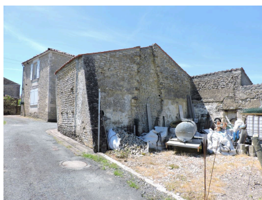
Vestiges de maison (cheminée) à l'arrière de la remise, vus depuis le nord-est. Phot. Yannis Suire IVR52_20198501383NUCA
