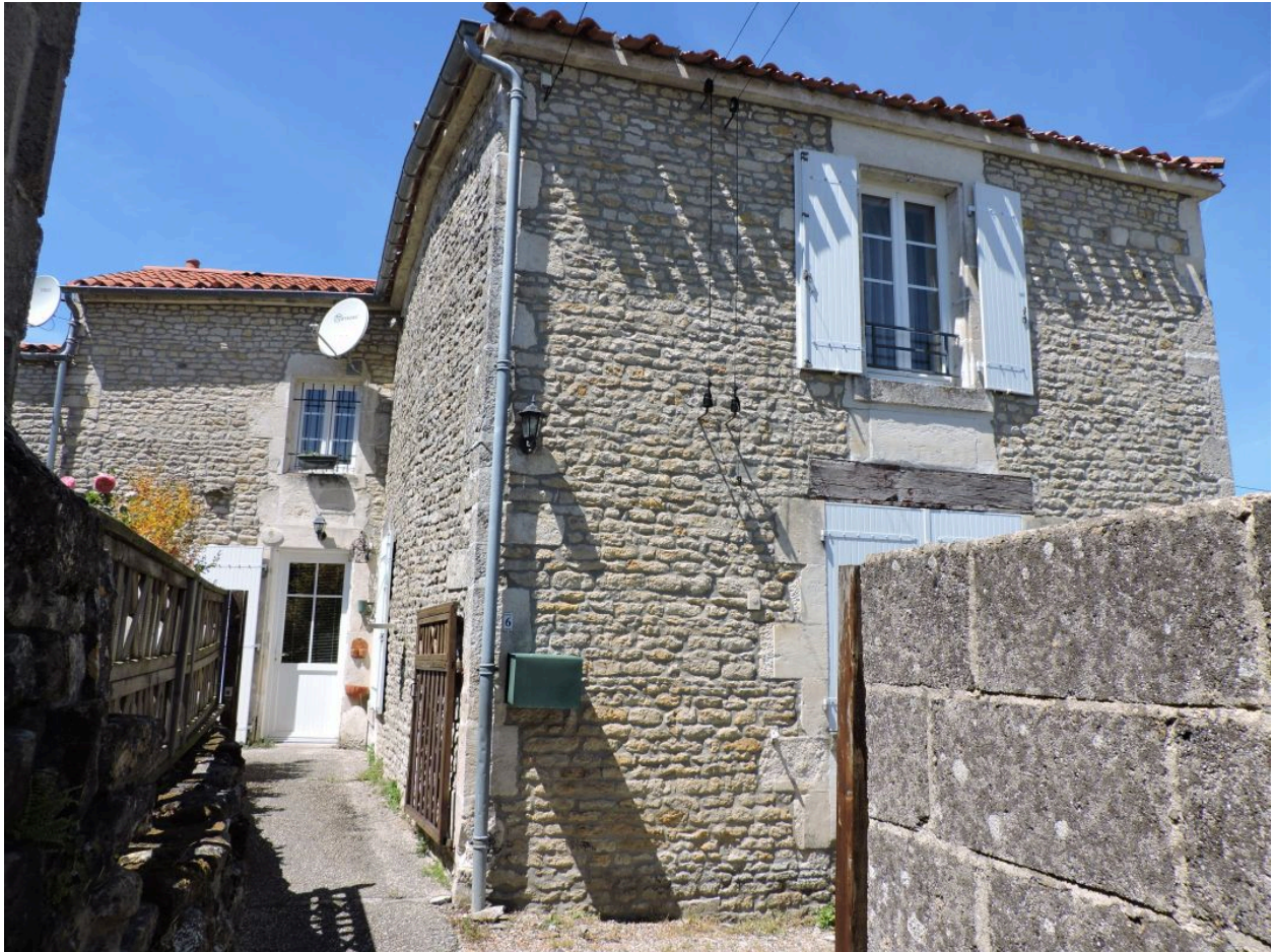
La maison vue depuis le sud-est.
