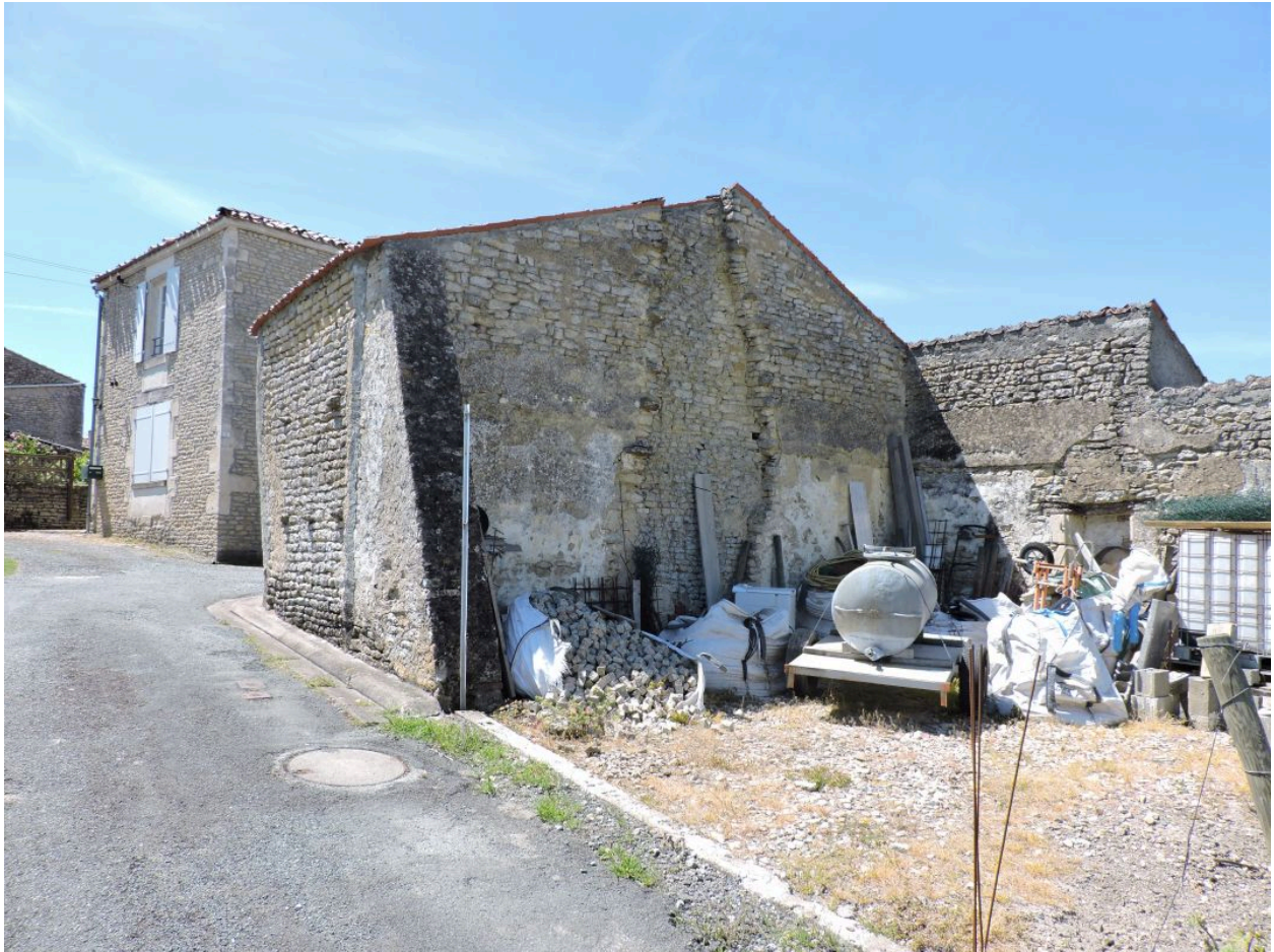
Vestiges de maison (cheminée) à l'arrière de la remise, vus depuis le nord-est.
