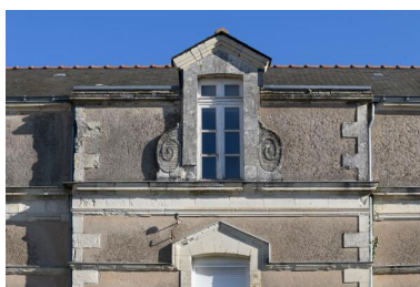
Détail de la lucarne centrale à ailerons, maison, 1 place du Général de Gaulle, Saint-Laurent-du-Mottay. Phot. Armelle Maugin IVR52_20234900283NUCA
