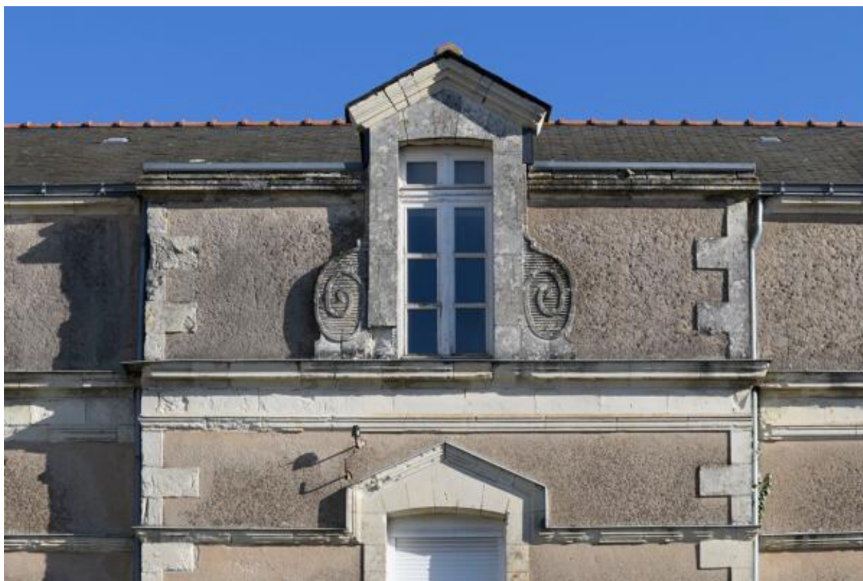
Détail de la lucarne centrale à ailerons, maison, 1 place du Général de Gaulle, Saint-Laurent-du-Mottay.
