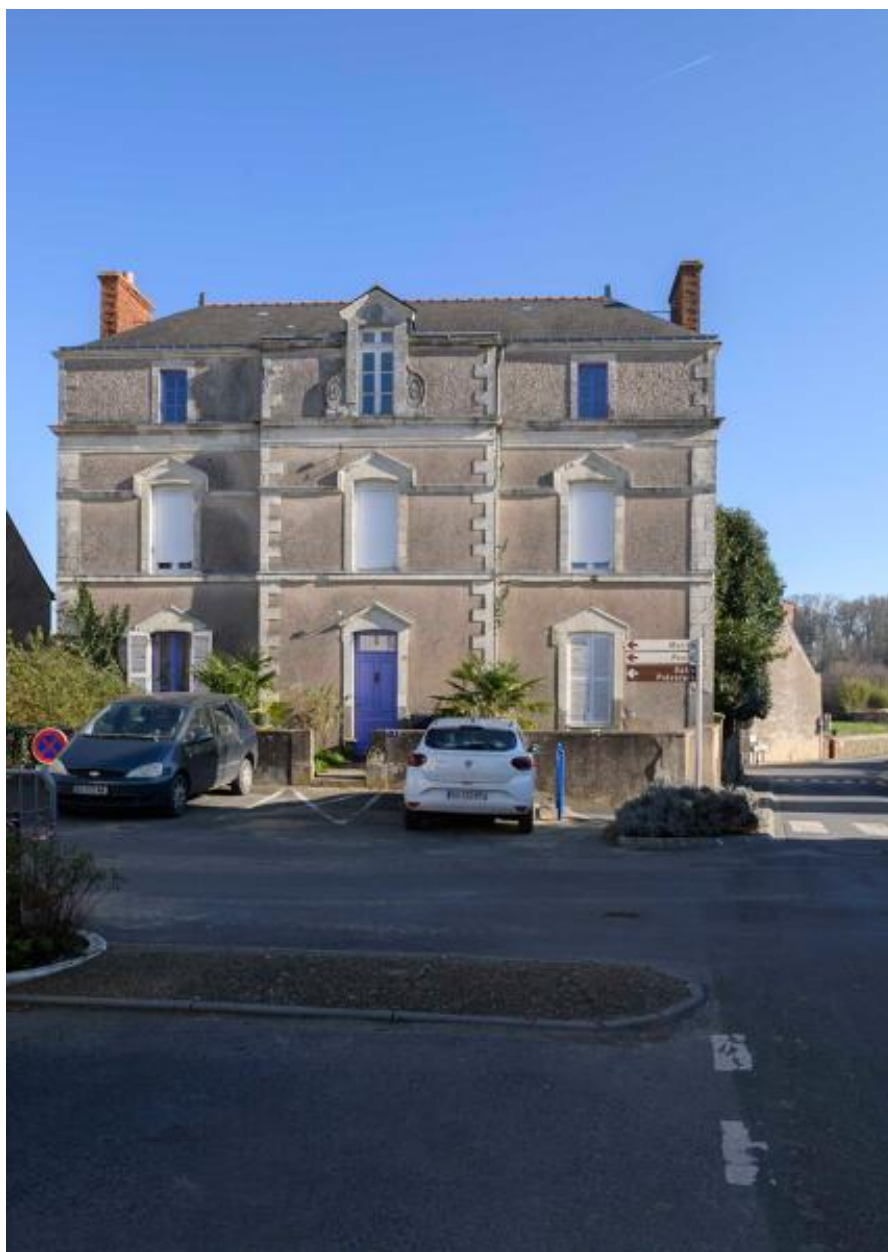
Maison, 1 place du Général de Gaule, Saint-Laurent-du-Mottay.
