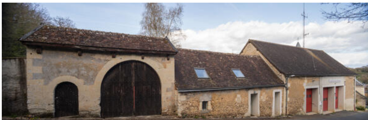
Le porche, les étables et la grange donnant sur la rue de l'Église.
