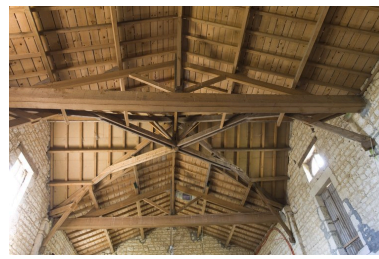
Partie centrale de la charpente du bâtiment sud. Phot. Patrice Giraud IVR52_20108500353NUCA
