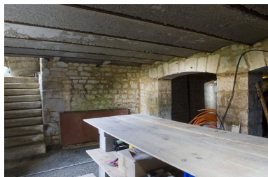
Vue du sous-sol de la maison, occupant la partie ouest du bâtiment sud. Phot. Patrice Giraud IVR52_20108500350NUCA
