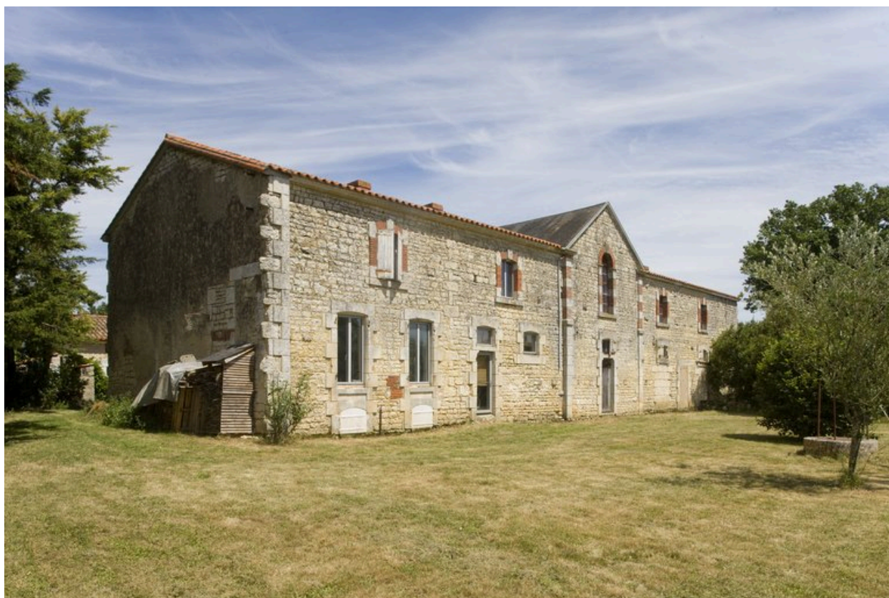
Vue de volume du bâtiment sud : maison à gauche, étable à bovins à droite (vue prise du sud-ouest).
