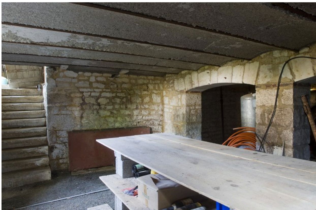
Vue du sous-sol de la maison, occupant la partie ouest du bâtiment sud.
