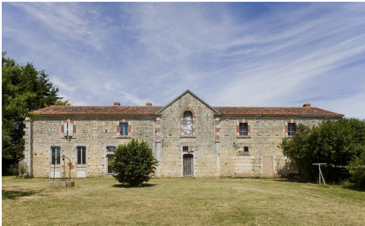
Façade sud du bâtiment sud.
