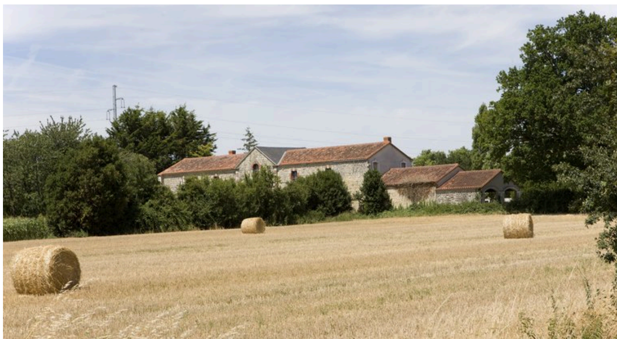
Vue éloignée prise du sud montrant les corps de bâtiments au sud de la cour.
