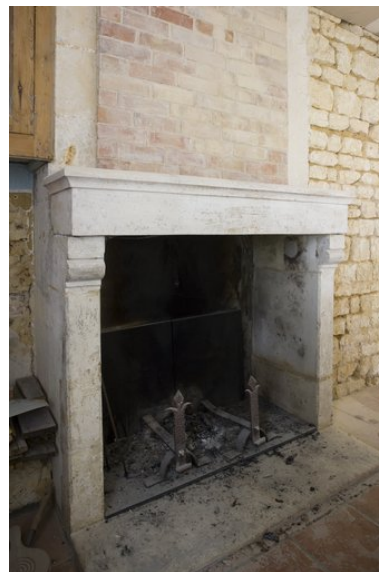
Cheminée de la cuisine. Phot. Patrice Giraud IVR52_20108500354NUCA
