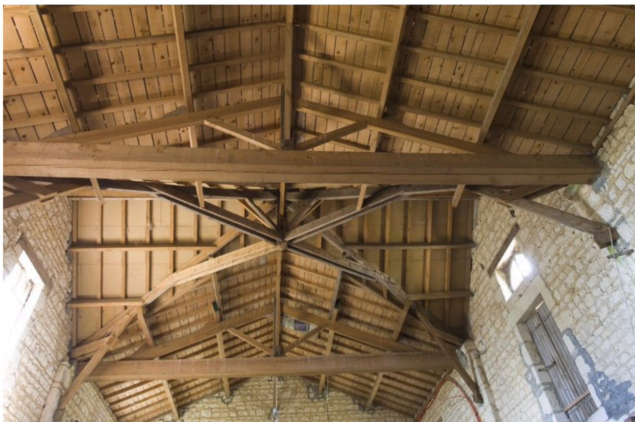
Partie centrale de la charpente du bâtiment sud.
