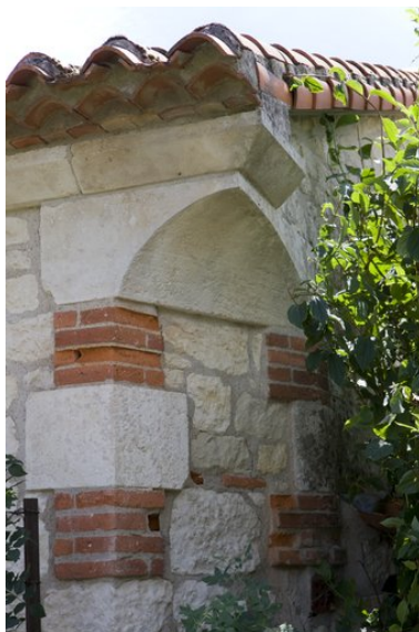
Trompe à l'un des angles du bâtiment nord. Phot. Patrice Giraud IVR52_20108500359NUCA
