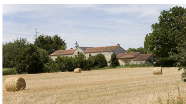
Vue éloignée prise du sud montrant les corps de bâtiments au sud de la cour. Phot. Patrice Giraud IVR52_20108500360NUCA
