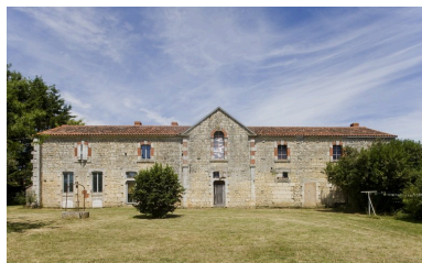
Façade sud du bâtiment sud. Phot. Patrice Giraud IVR52_20108500357NUCA
