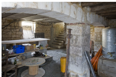
Vue du sous-sol de la maison. Phot. Patrice Giraud IVR52_20108500351NUCA
