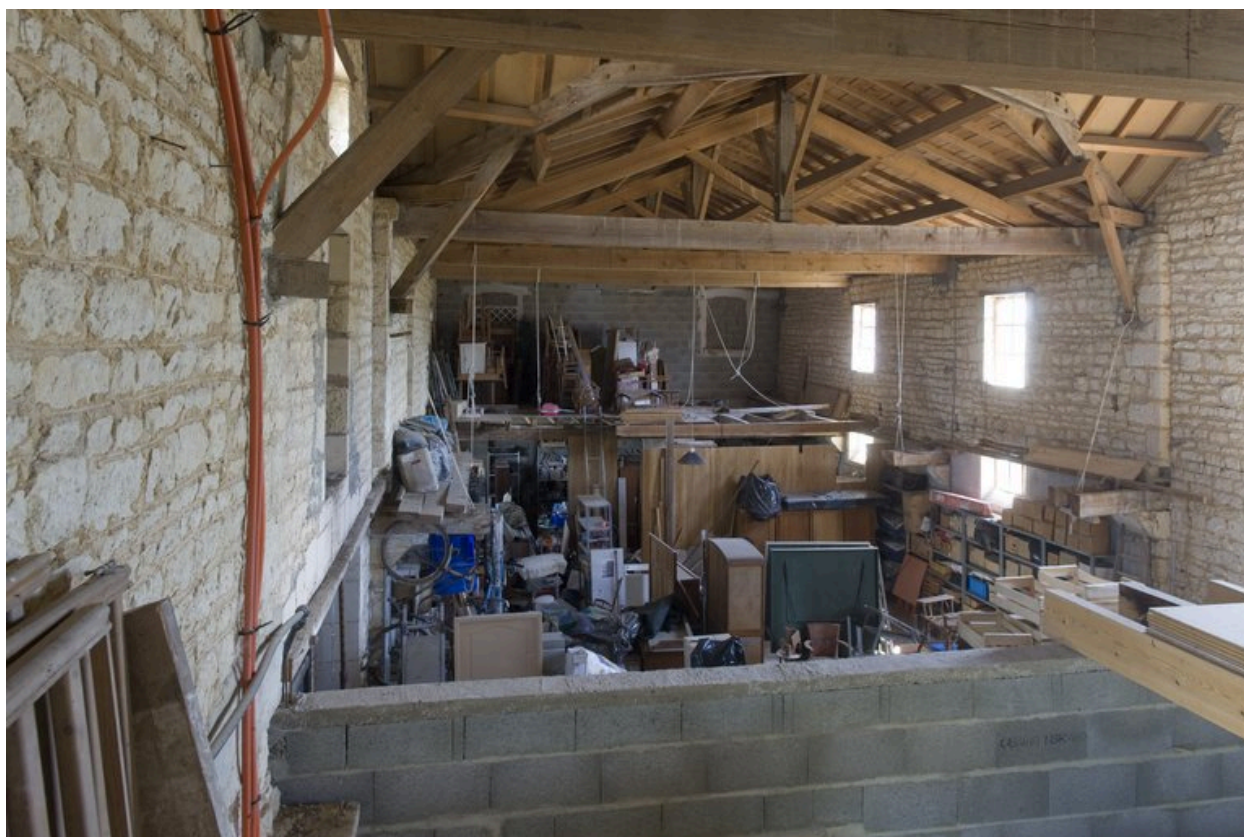
Vue intérieure du bâtiment sud montrant la partie est, réservée aux dépendances agricoles.
