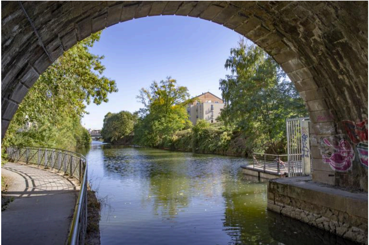
Vue du canal et de l'île aux Planches à droite prise sous le pont du chemin de fer
