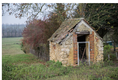
Une petite dépendance. Phot. Pierre-Bernard Fourny IVR52_20187202367NUCA
