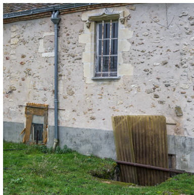
La façade arrière. Phot. Pierre-Bernard Fourny IVR52_20187202368NUCA
