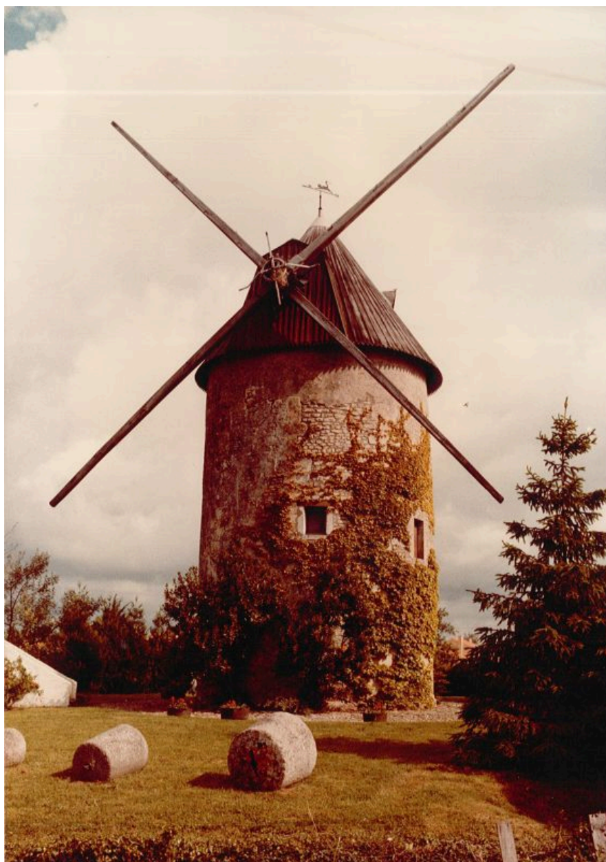
Le moulin vu depuis le sud en 1988.
