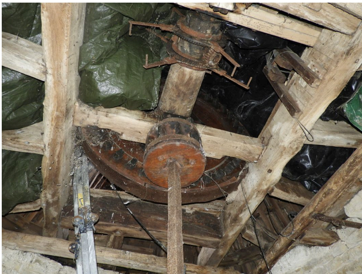
Détail du mécanisme sous le toit : la lanterne, le rouet et l'arbre.
