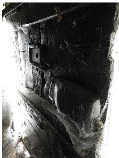
Ouilleton et serrure de la porte est. Phot. Yannis Suire IVR52_20188501128NUCA
