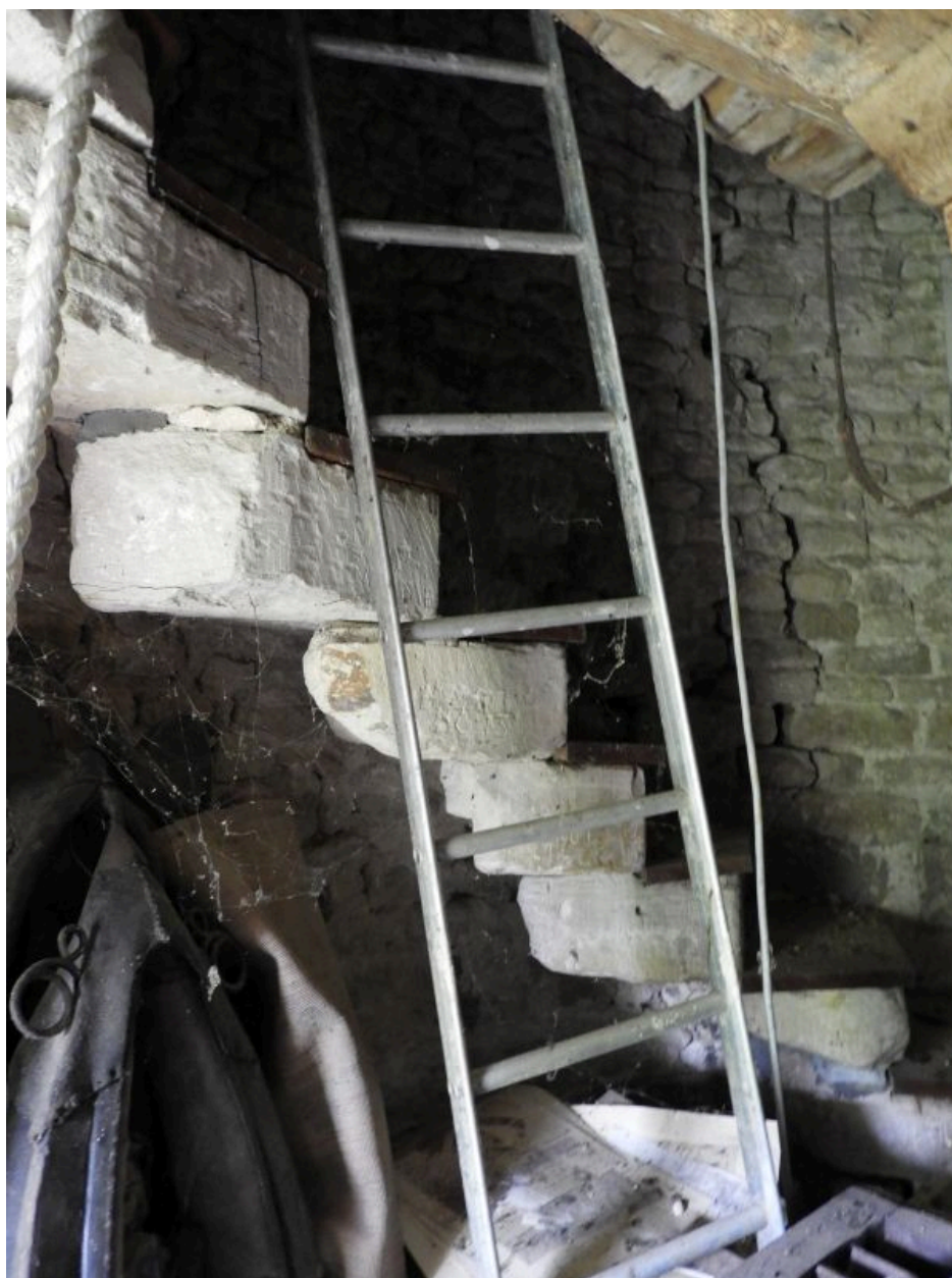
L'escalier intérieur en pierre, au rez-de-chaussée
