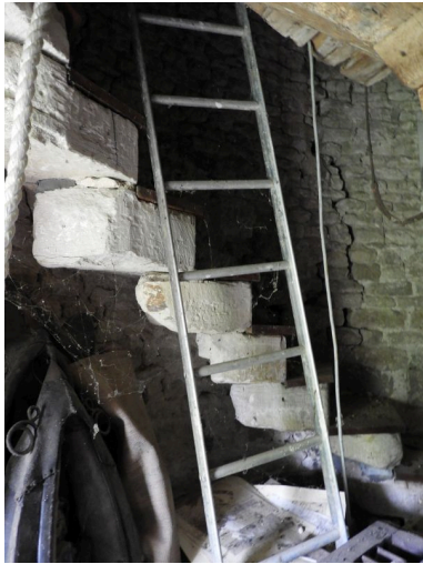
L'escalier intérieur en pierre, au rez-de-chaussée Phot. Yannis Suire IVR52_20188501133NUCA
