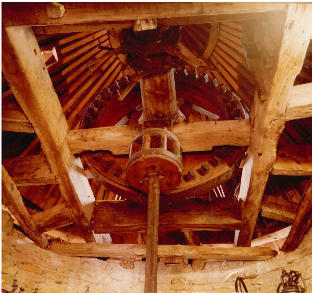
Le mécanisme sous le toit, vers 1980 : rouet, lanterne et arbre.
