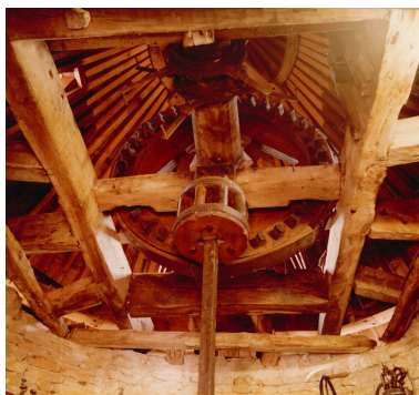
Le mécanisme sous le toit, vers 1980 : rouet, lanterne et arbre. Phot. Yannis (reproduction) Suire IVR52_20188501143NUCA
