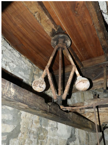
Le régulateur Watt, au premier étage. Phot. Yannis Suire IVR52_20188501139NUCA
