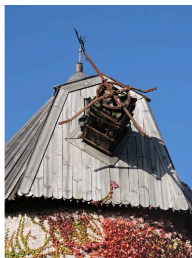
L'extrémité de l'arbre avec des vestiges d'aires de type Berton.
