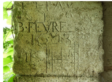
La date 1613 sur le jambage de la porte est. Phot. Yannis Suire IVR52_20188501125NUCA
