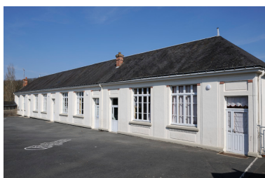
Ecole : façade ouest Phot. Bruno Rousseau, Phot. Youenn Communeau IVR52_20114900794NUCA
