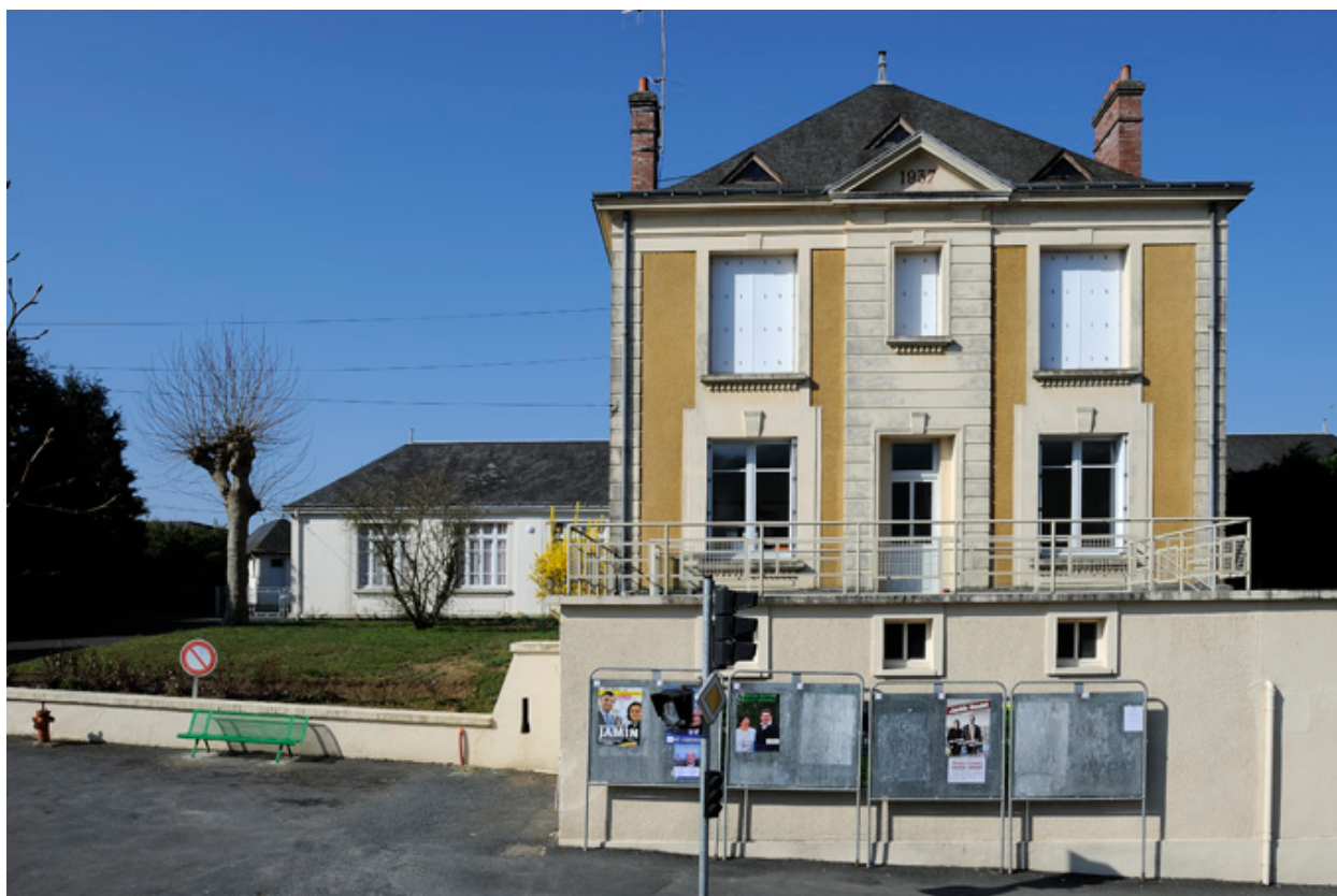
Maison du directeur : façade principale
