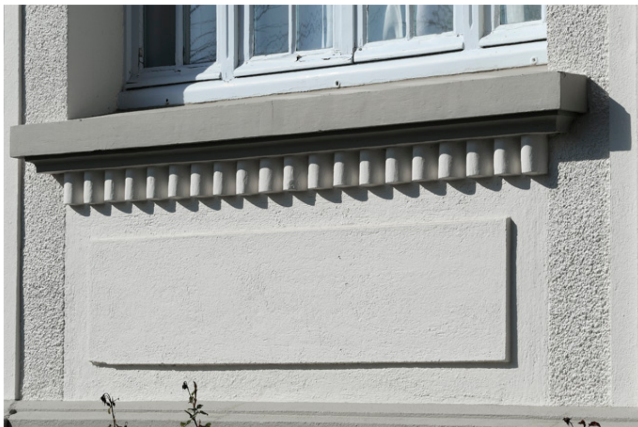
Ecole : façade est, allège et appuis de fenêtre à modillons
