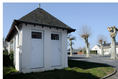
Buanderie et W.C. des enseignants Phot. Bruno Rousseau, Phot. Youenn Communeau IVR52_20114900621NUCA
