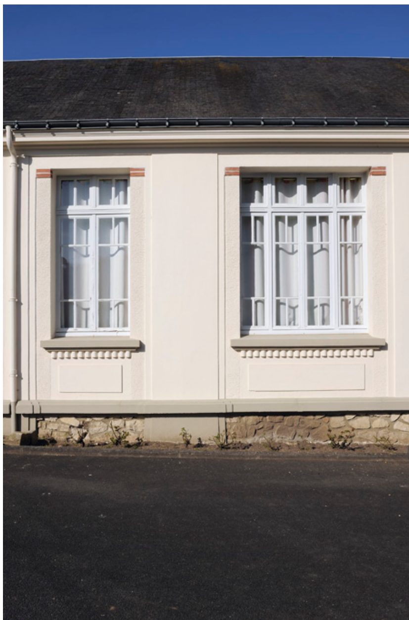
Ecole : façade est, détail de deux baies (1)
