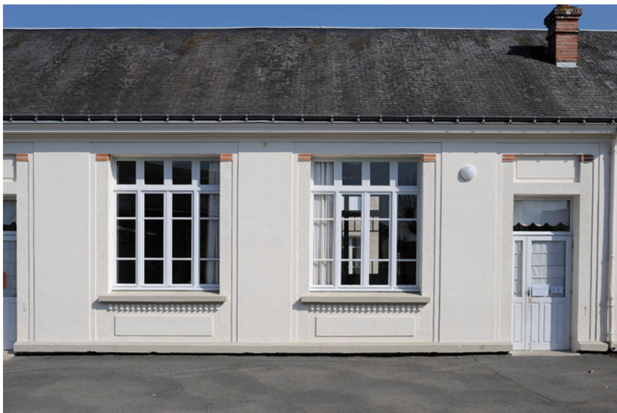
Ecole : façade ouest, module d'une salle de classe
