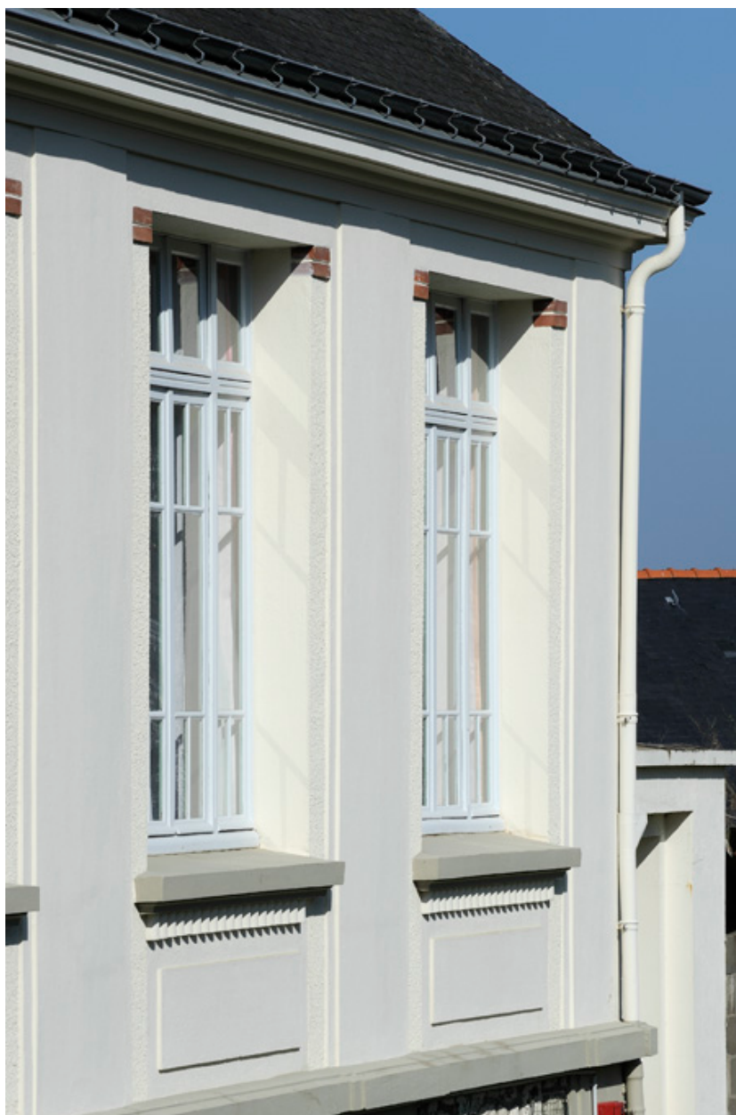
Ecole : façade est, détail de deux baies (2)
