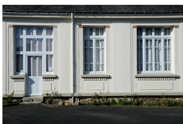
Ecole : façade est, détail de trois baies (celle de gauche appartient à l'extension de 1957) Phot. Bruno Rousseau, Phot. Youenn Communeau IVR52_20114900615NUCA
