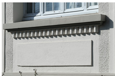
Ecole : façade est, allège et appuis de fenêtre à modillons Phot. Bruno Rousseau, Phot. Youenn Communeau IVR52_20114900619NUCA
