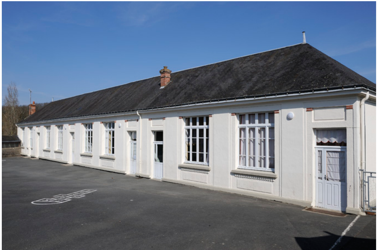
Ecole : façade ouest
