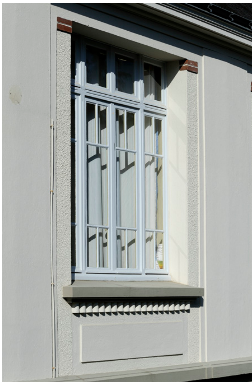
Ecole : façade est, détail d'une baie
