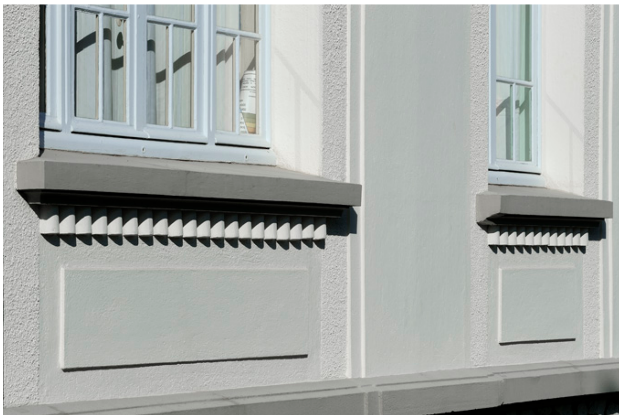
Ecole : façade est, allèges et appuis de fenêtre à modillons
