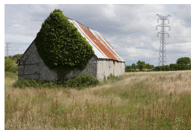
Vue d'ensemble depuis le sud. Phot. Denis Pillet IVR52_20084402021NUCA
