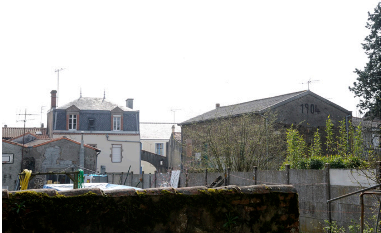
Vue du premier atelier de l'entreprise Durand-Chéné et de la maison de Joseph Chéné, depuis le jardin de Christian Chéné.
