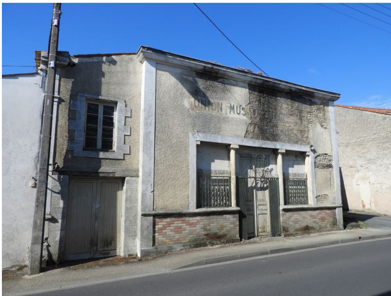
La façade nord de la salle.
