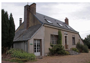
Vue de volume. Phot. Jean-Baptiste Darrasse IVR52_20107201386NUCA
