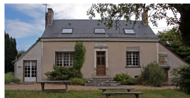
Maison forestière : façade antérieure. Phot. Jean-Baptiste Darrasse IVR52_20107201385NUCA
