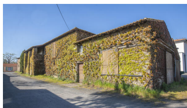
Élévation ouest du chai. Phot. Pierre-Bernard Fourny IVR52_20224400129NUCA
