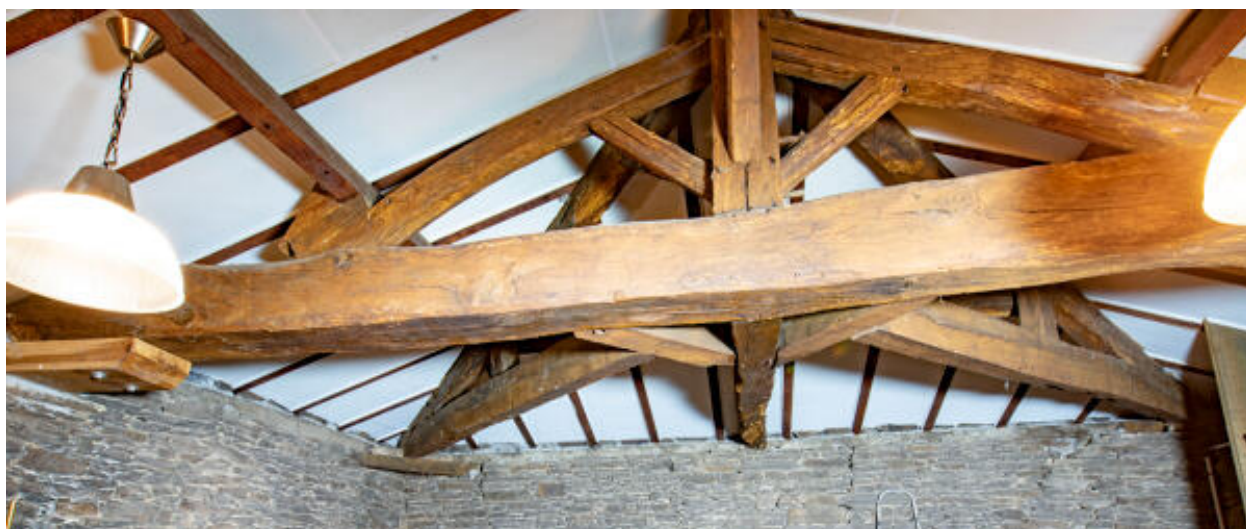
Demi-enrayure de la charpente en partie nord de l'étage d'habitation.
