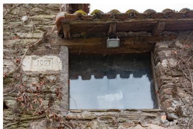
Baie et date portée sur l'élévation ouest. Phot. Pierre-Bernard Fourny IVR52_20234400079NUCA
