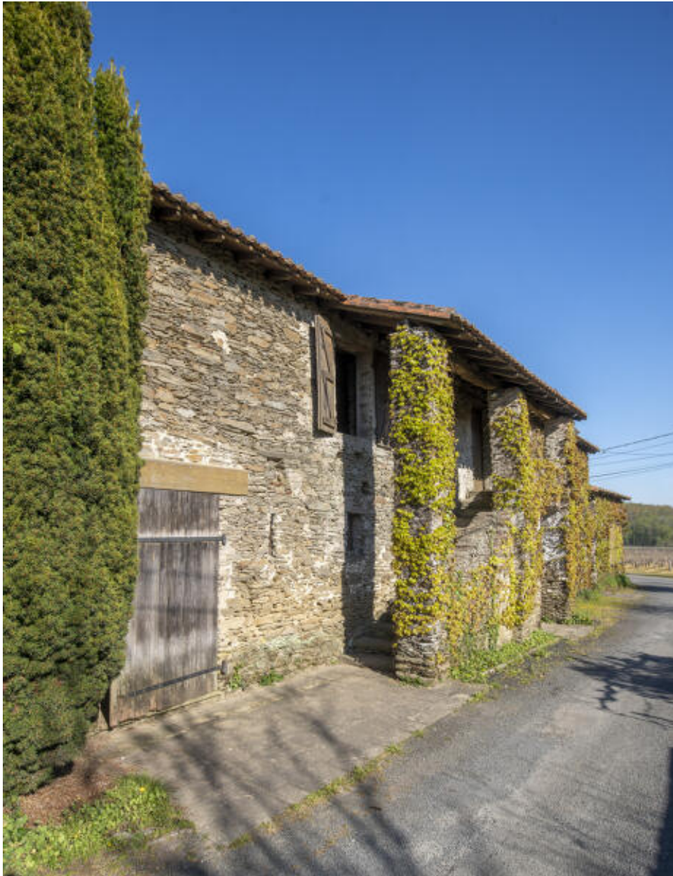
Escalier menant à l'étage d'habitation, en élévation ouest du chai.
