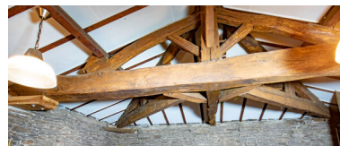
Demi-enrayure de la charpente en partie nord de l'étage d'habitation. Phot. Pierre-Bernard Fourny IVR52_20234400082NUCA
