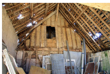
La grange, pignon ouest mitoyen en pan-de-bois : le mur arrière n'est pas rehaussé. Phot. Jean-Baptiste Darrasse IVR52_20077202422NUCA
