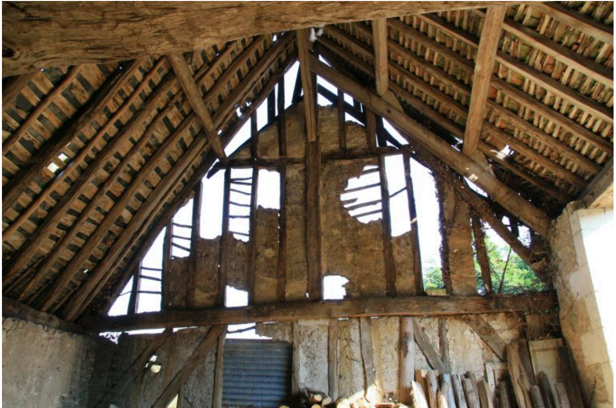
La grange : pignon est en pan-de-bois.
