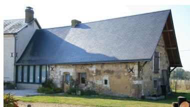
Ancienne maison 2 remaniée en étable puis aménagée en annexe de la maison d'habitation. Phot. Jean-Baptiste Darrasse IVR52_20077202423NUCA
