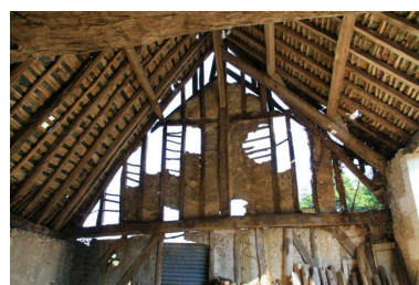
La grange : pignon est en pan-de-bois. Phot. Jean-Baptiste Darrasse IVR52_20077202421NUCA
