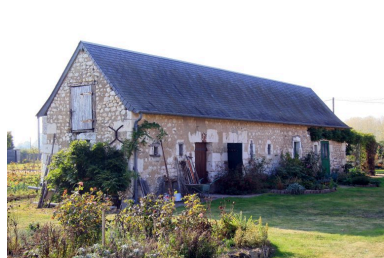
La vieille ferme : anciens toits à porcs. Phot. Jean-Baptiste Darrasse IVR52_20077202425NUCA
