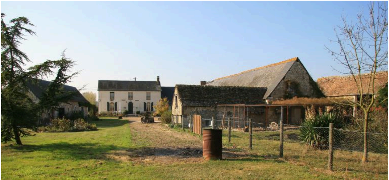
Vue d'ensemble prise de l'est : la nouvelle maison d'habitation.
