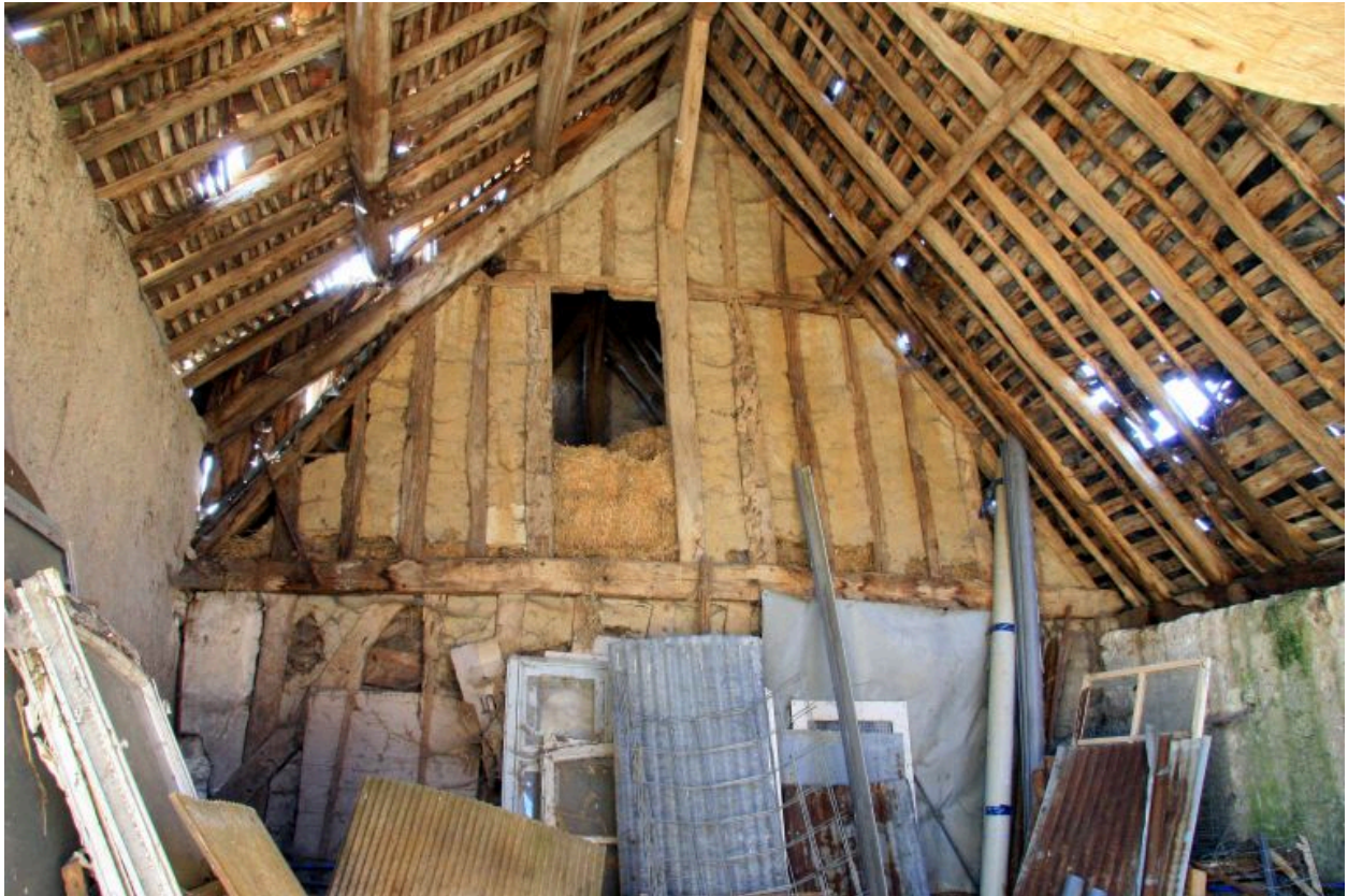
La grange, pignon ouest mitoyen en pan-de-bois : le mur arrière n'est pas rehaussé.
