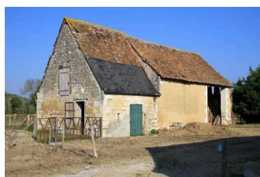
La grange en partie remaniée : le mur de façade a été rehaussé. Phot. Jean-Baptiste Darrasse IVR52_20077202420NUCA
