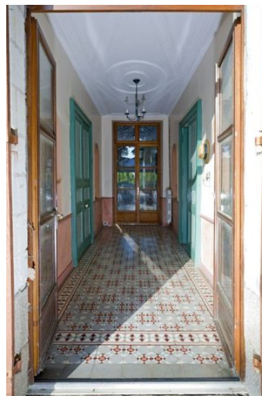
Entrée traversante aux murs agrémentés de quatre niches. Phot. Yves Guillotin IVR52_20104402810NUCA
