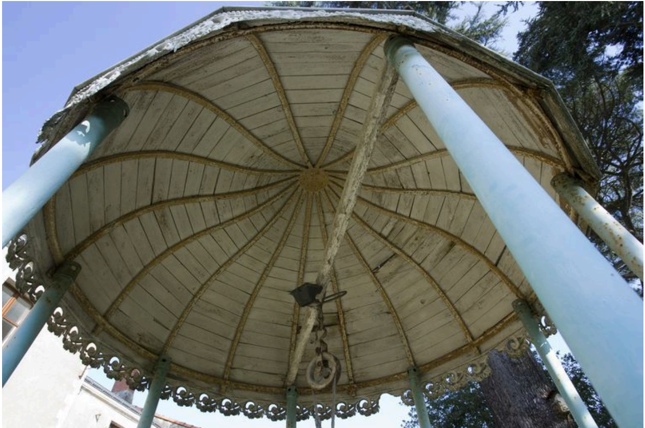
Dôme surmontant le puits : détails.
