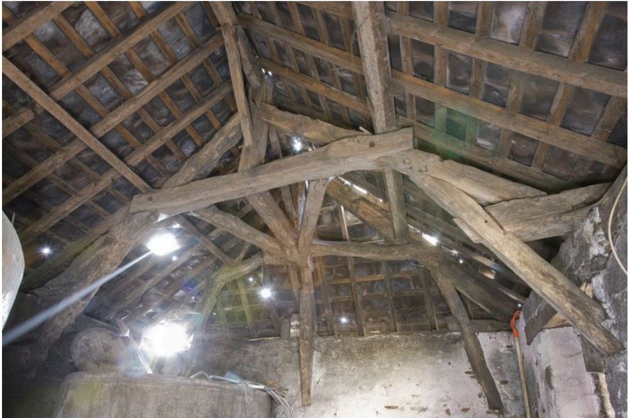
Cellier : détail de charpente.
