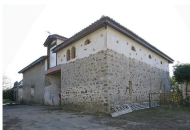
Dépendance sud : la partie droite a été récemment remaniée. Phot. Yves Guillotin IVR52_20104402833NUCA
