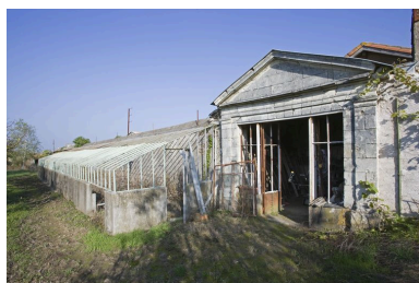
Jardin. L'orangerie, à la façade incluse dans le mur de clôture (ca 1800) ; la serre adossée (ca 1935). Phot. Yves Guillotin IVR52_20104402813NUCA
