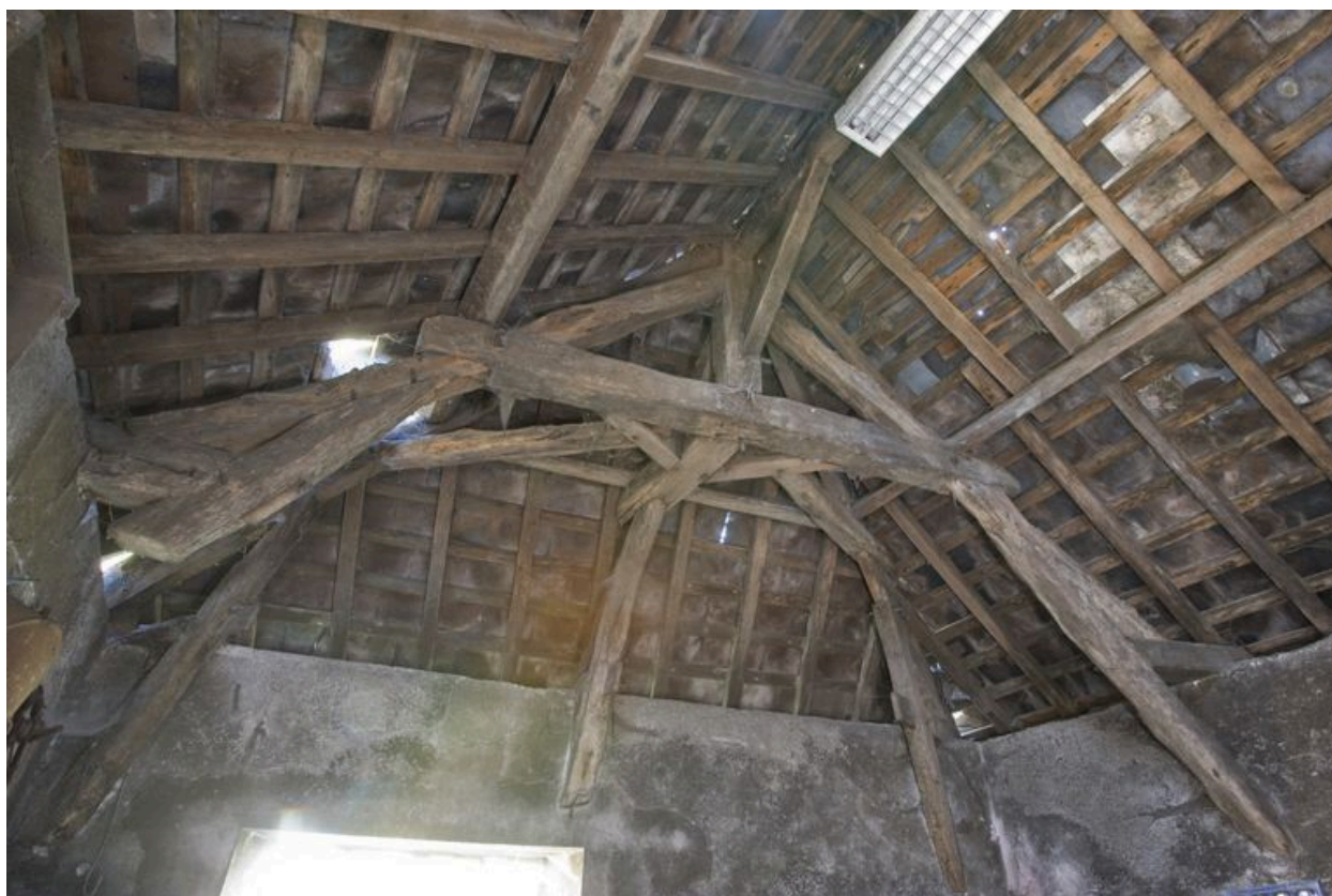
Cellier : détail de charpente.
