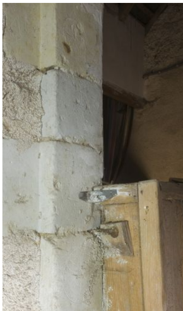
Les combles : série de graffitis à motifs de rosaces. Phot. Yves Guillotin IVR52_20104402804NUCA
