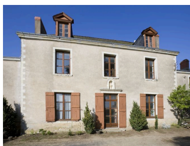
Façade est, partie centrale. Phot. Yves Guillotin IVR52_20104402825NUCA
