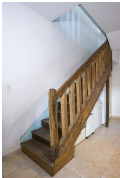
Cuisine : escalier d'accès à l'étage, 19e siècle. Phot. Yves Guillotin IVR52_20104402805NUCA
