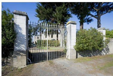
Le portail d'entrée sur cour. Phot. Yves Guillotin IVR52_20104402835NUCA
