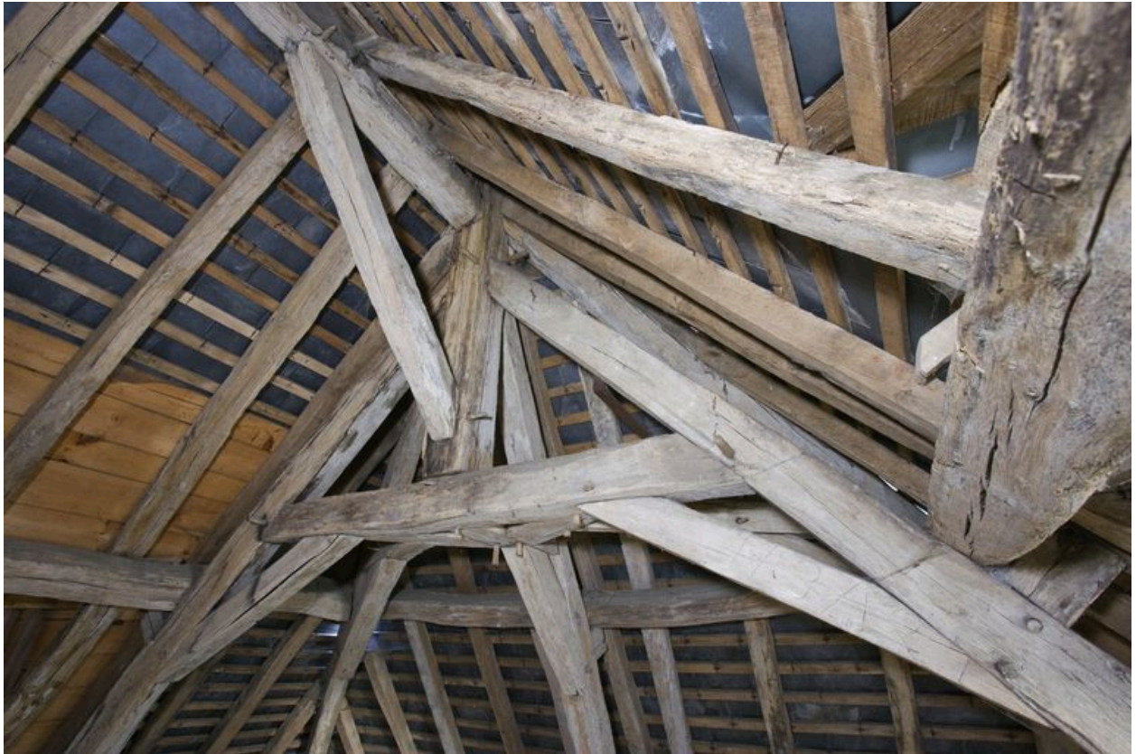
Les combles : détail d'une croupe.
