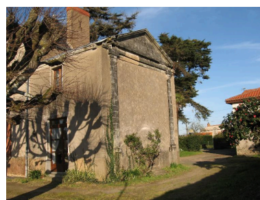
Pignon de l'ancien jardin d'hiver avant restauration : les marches d'accès sont encore visibles [ca 2000]. Phot. Yves Guillotin IVR52_20104402962NUCAB
