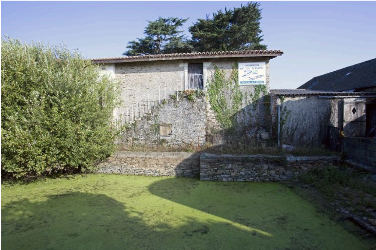
Dépendance sud : façade sud avec l'escalier extérieur donnant sur la pièce d'eau.
