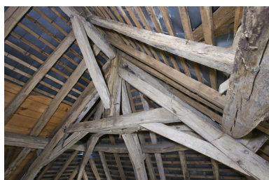
Les combles : détail d'une croupe. Phot. Yves Guillotin IVR52_20104402803NUCA
