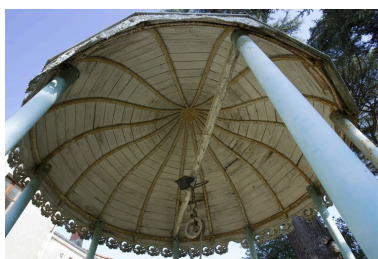
Dôme surmontant le puits : détails. Phot. Yves Guillotin IVR52_20104402827NUCA
