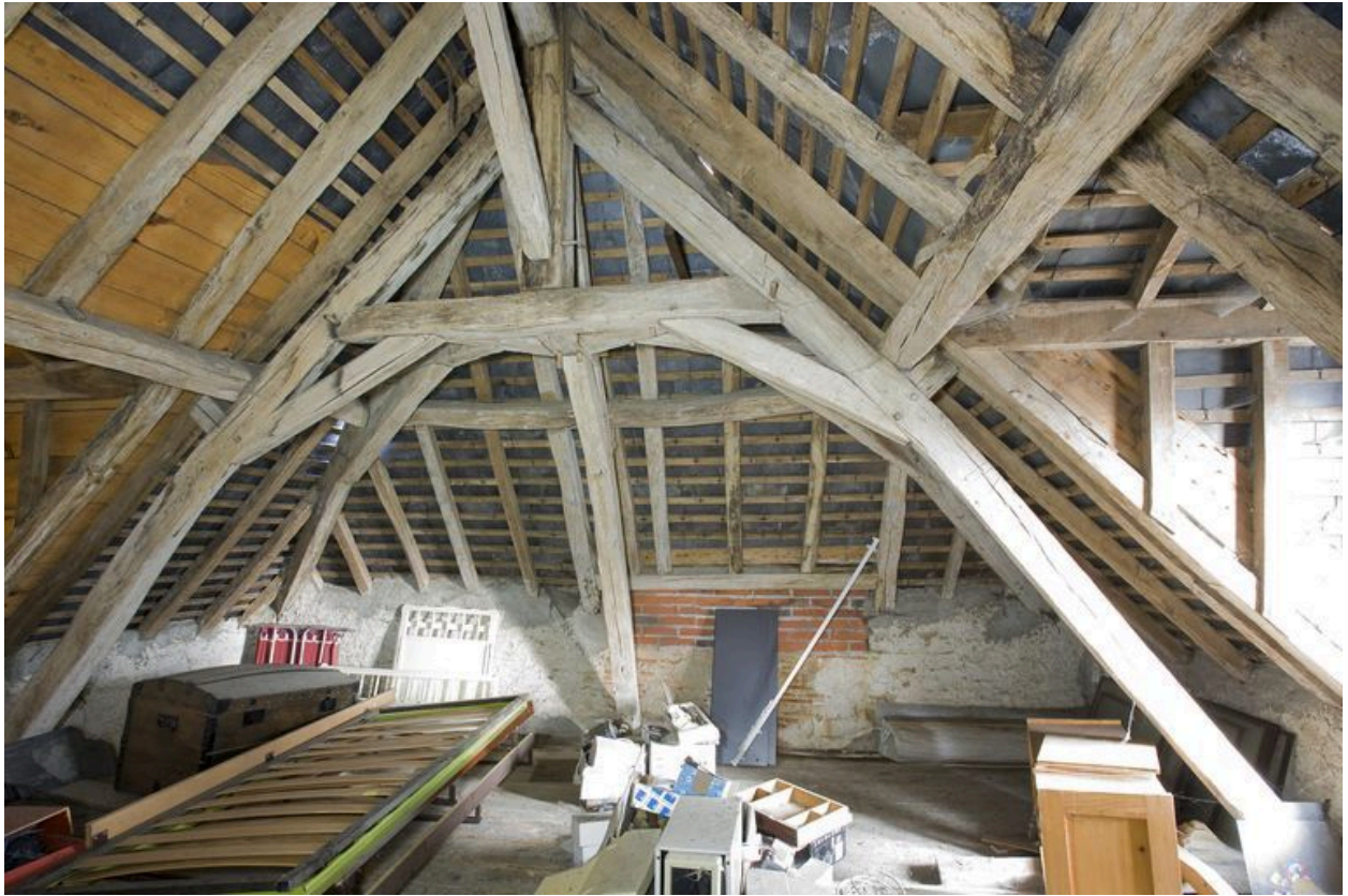
Les combles : charpente.
