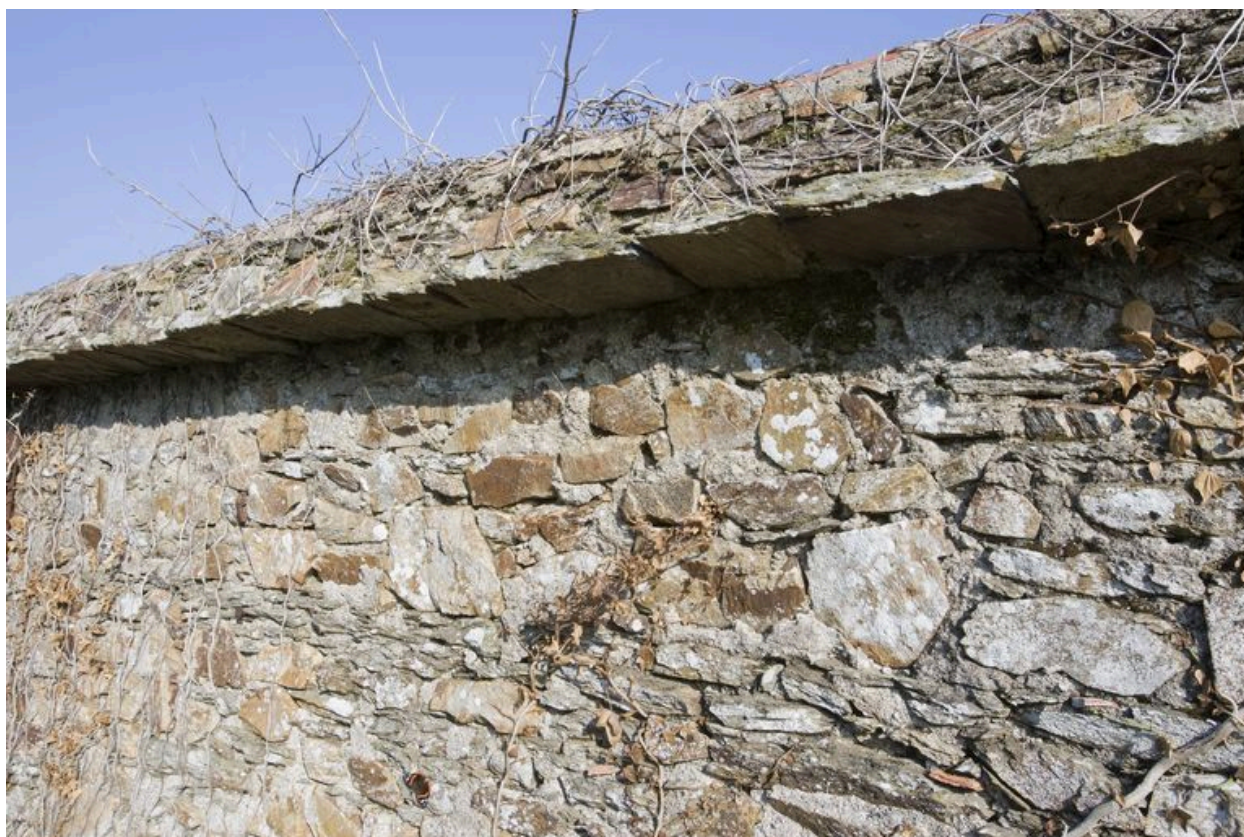
Jardin. Face sud du mur nord : appareillage de pierres destiné à conserver la chaleur solaire.
