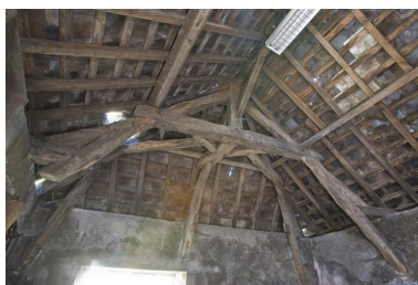
Cellier : détail de charpente. Phot. Yves Guillotin IVR52_20104402829NUCA
