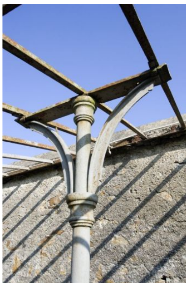
Jardin. La serre adossée : détail de ferronnerie. Phot. Yves Guillotin IVR52_20104402815NUCA
