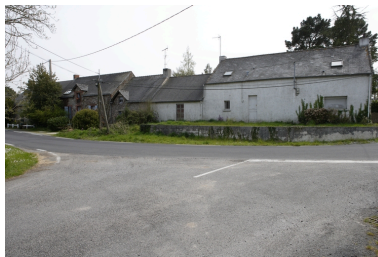
Vue d'ensemble depuis le nord. Phot. Denis Pillet IVR52_20084401537NUCA
