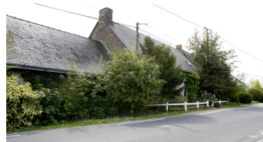
Vue d'ensemble depuis l'est. Phot. Denis Pillet IVR52_20084401538NUCA
