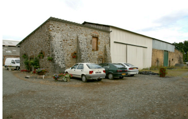
L'ancienne étable-grange vue depuis le nord-ouest. Phot. François Lasa IVR52_20035302252NUCA
