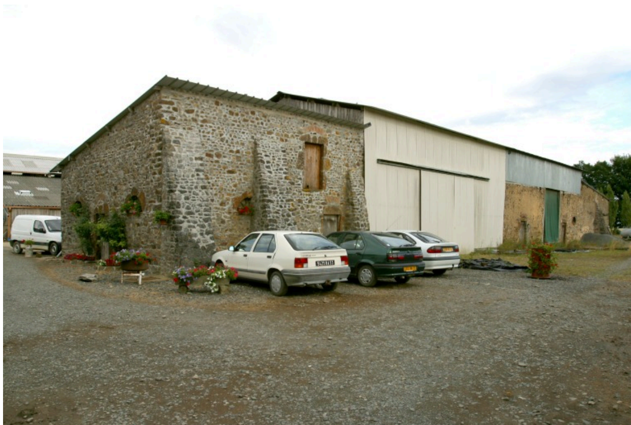
L'ancienne étable-grange vue depuis le nord-ouest.
