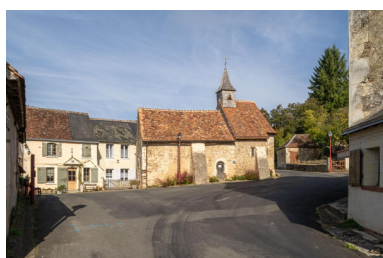
Le carrefour central, vu depuis le sud-est. Phot. Jeanne Minier IVR52_20257200735NUCA
