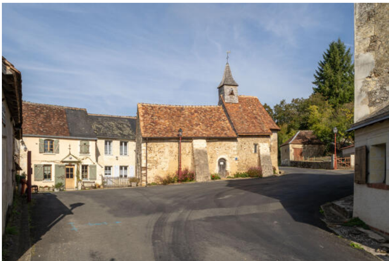
Le carrefour central, vu depuis le sud-est.
