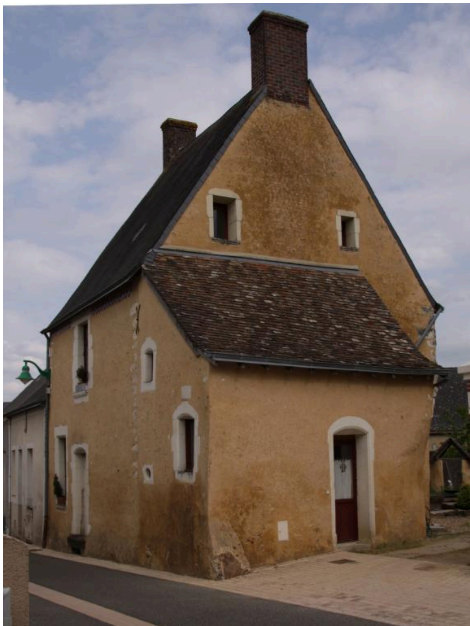
Etage, 1 pièce à feu par niveau au XVI e siècle. Auberge du Lion d'Or, Saint-Vincent-du-Lorouër.
