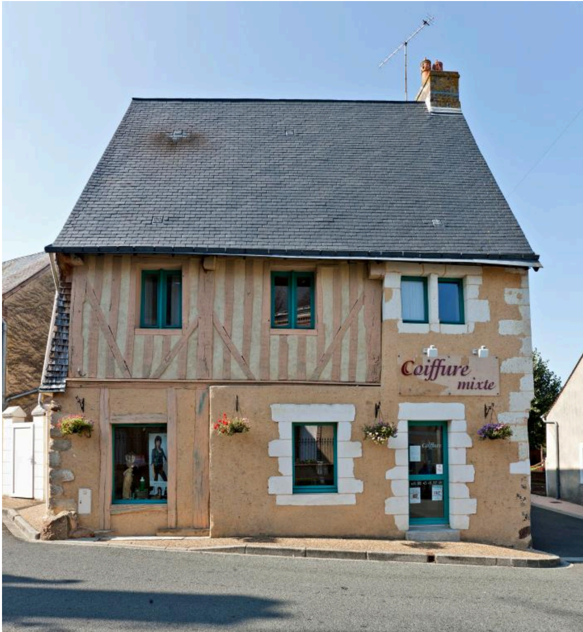
Etage, avec pan de bois (XVI e siècle). Le Pilier Vert, Pruillé-l'Eguillé.
