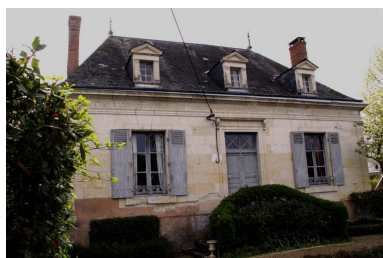
Rez-de-chaussée, 2 pièces à feu, couloir central. 6, rue Gérard-Dupré, Saint-Vincent-du-Lorouër. Phot. Jean-Baptiste Darrasse IVR52_20107200710NUCA
