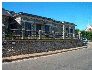
Elévation antérieure de la station d'épuration. Phot. Jonathan Truillet IVR52_20057200654NUCA
