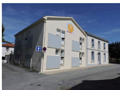
La maison de retraite vue depuis le sud-ouest, à l'angle entre la rue de la Fontaine et la rue Pousse Fenouil. Phot. Yannis Suire IVR52_20198501649NUCA
